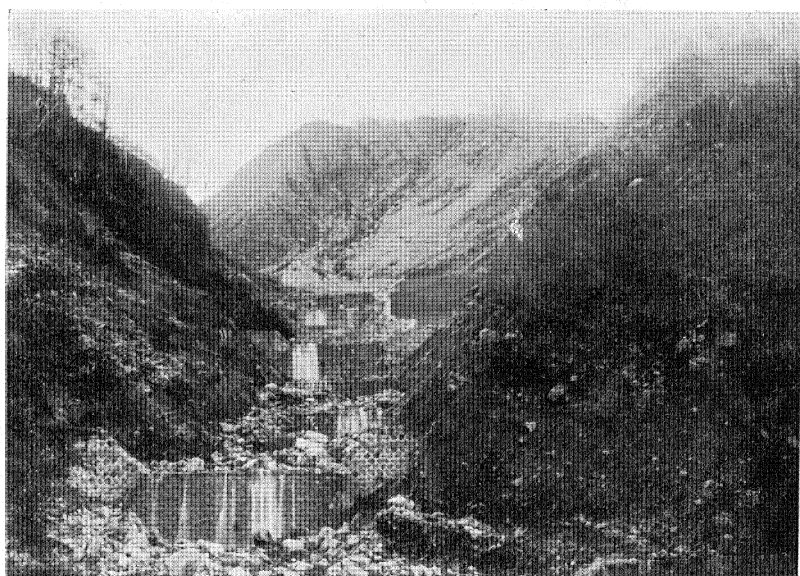
馬見ヶ崎川支溪ナヘ澤（第18号堰堤ヨリ上流ヲ望ム）
