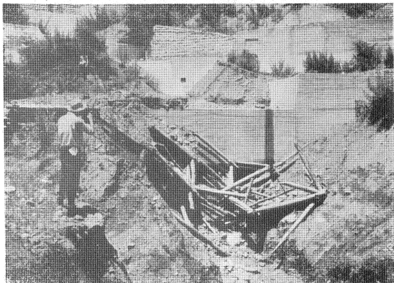
上 長野縣北安曇郡七貴村蜂ヶ澤に於ける 砂防課築設のコンクリート堰堤
