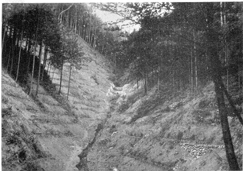
東京府西多摩郡五日市町庄ノ澤に於ける荒廢林地復舊工事 （昭和十四年度施行）
