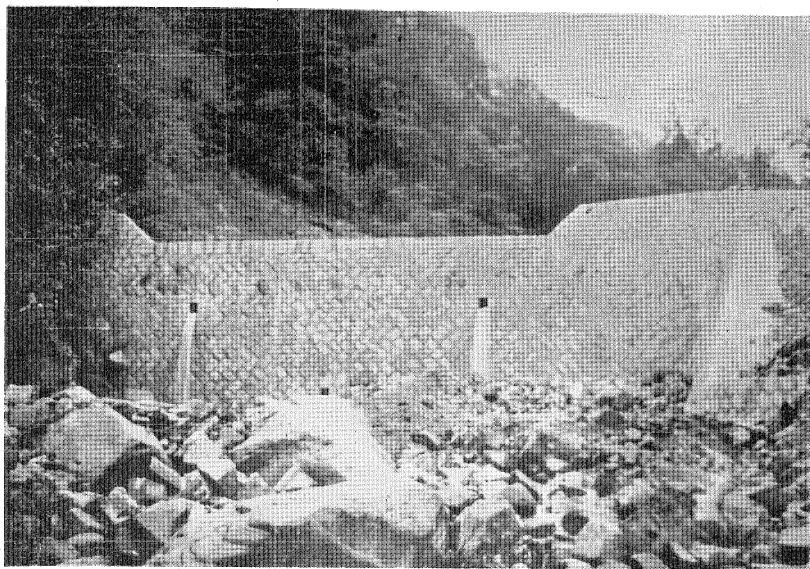
石川縣能美郡白峰村字白峰下杉谷 第一號練積堰堤工
