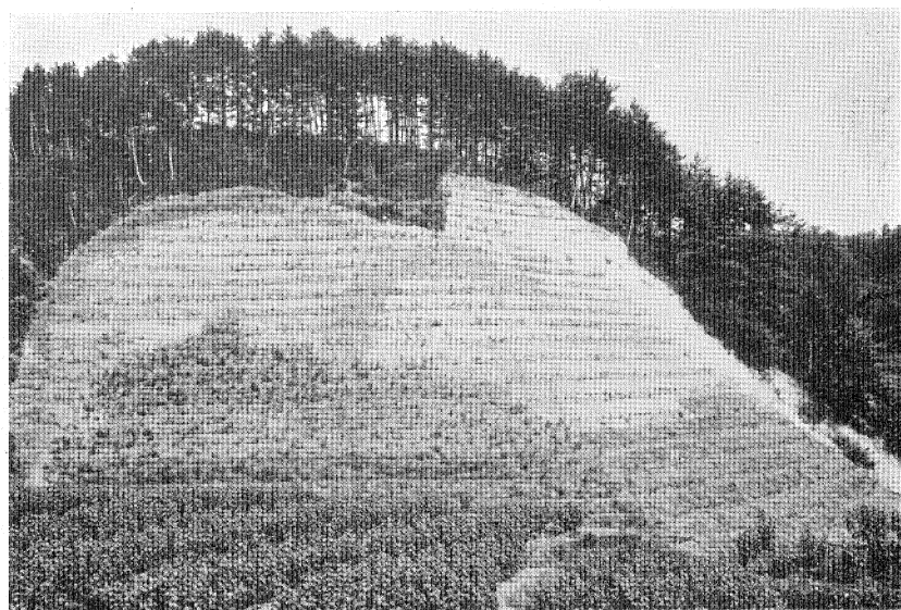
同上昭和四年度工事施行後
