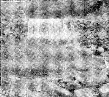
小山町湯船澤に於ける練積堰堤工
