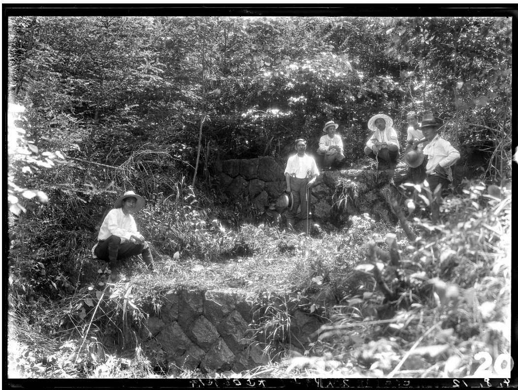
R128 ヒノキオ沢 石堰堤（昭和4年8月12日）[写真中央が諸戸博士] 【砂防8号, 45p, 8月11日に関連記事あり】
