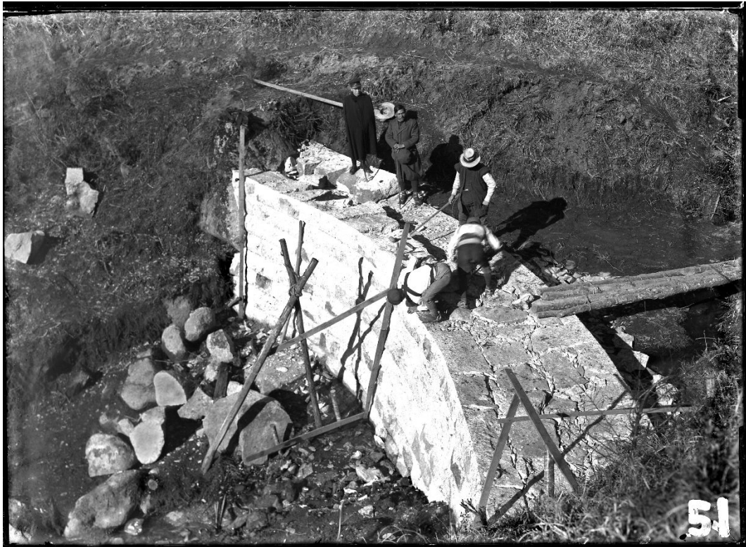
R064 シシネド沢 石堰堤(施工中)[左から2人目が諸戸博士](大正5年12月) 【諸戸北郎博士収集写真集 1010 と同一写真】
