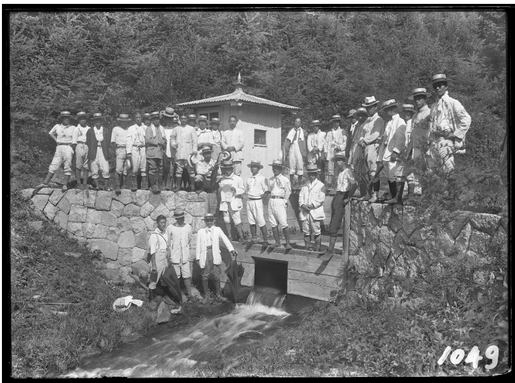
R034 ハビロ沢 量水堰堤 砂防講習生(撮影時期不明) [右岸袖部 前列左から7人目が諸戸博士]
