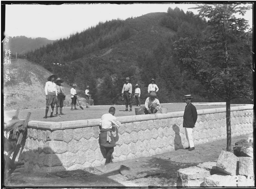
R017 水神社 奥宮拝殿 石垣工事(昭和3年6月)
