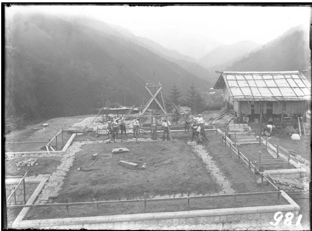
R019 水神社 奥宮 建築工事(昭和3年8月)
