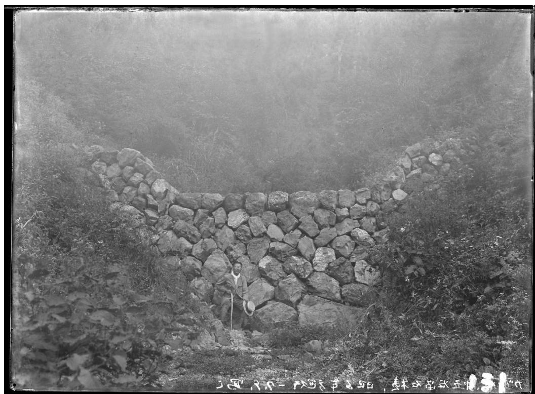
R229 カツラ谷 第5石堰堤(昭和7年9月)
