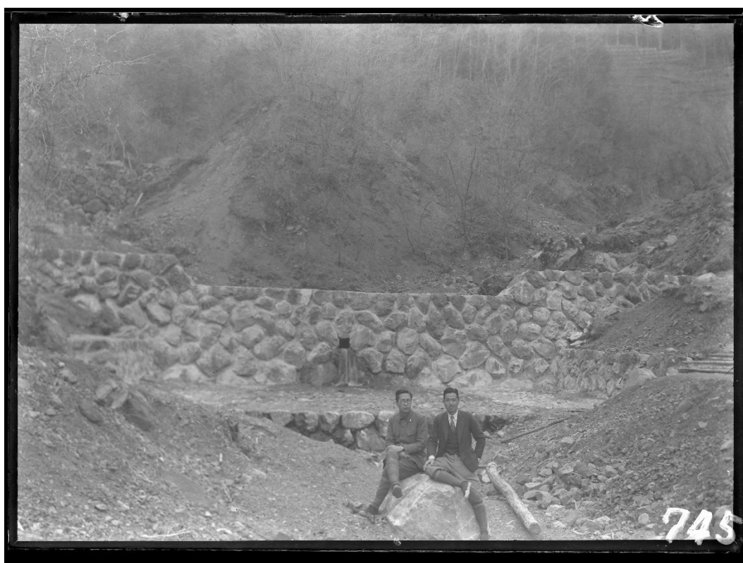
R271 場所不明 堰堤(撮影時期不明)
