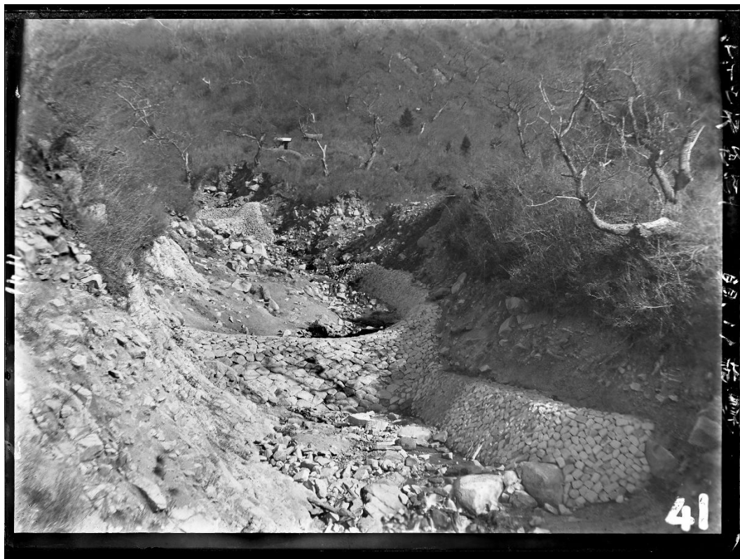
R260 ブドウ沢 砂防工 石堰堤(明治 44 年 11 月)
