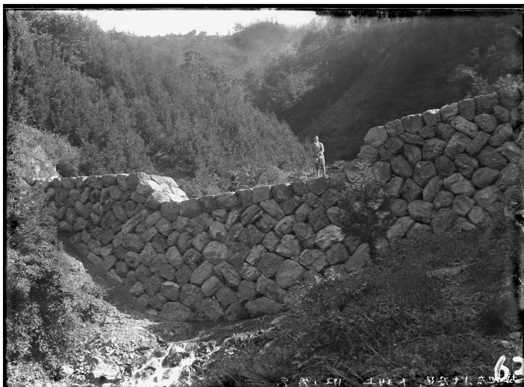
R223 シオジ谷 第7石堰堤(昭和7年9月)
