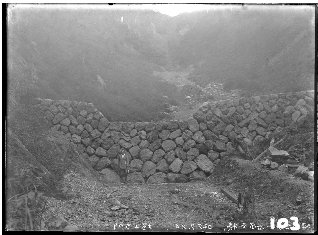
R222 シオジ谷 第1石堰堤(昭和7年9月20日)
