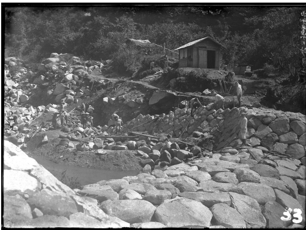
R273 山梨県 砂防工事(撮影時期不明)
