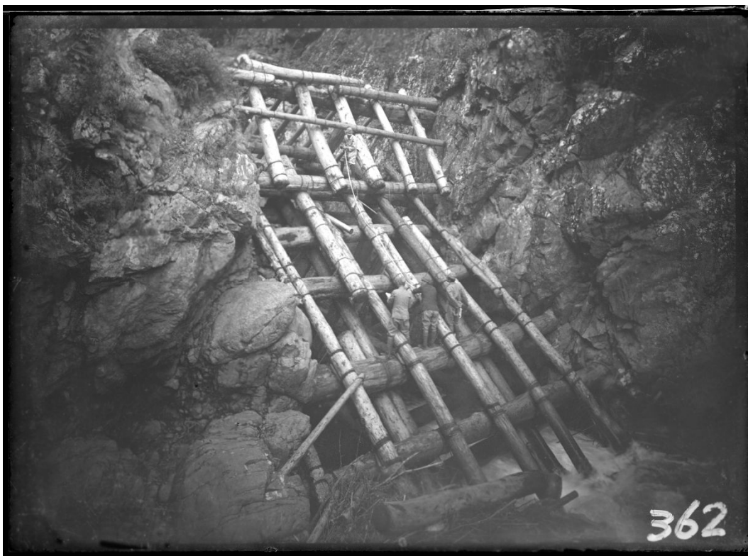
R274 運搬用施設(撮影時期不明)
