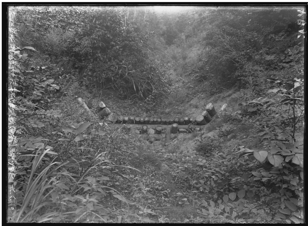
R259 朝日川沿岸奥縄ミノウチ沢 木堰堤(昭和 5 年施行)(昭和 6 年 8 月 20 日)
