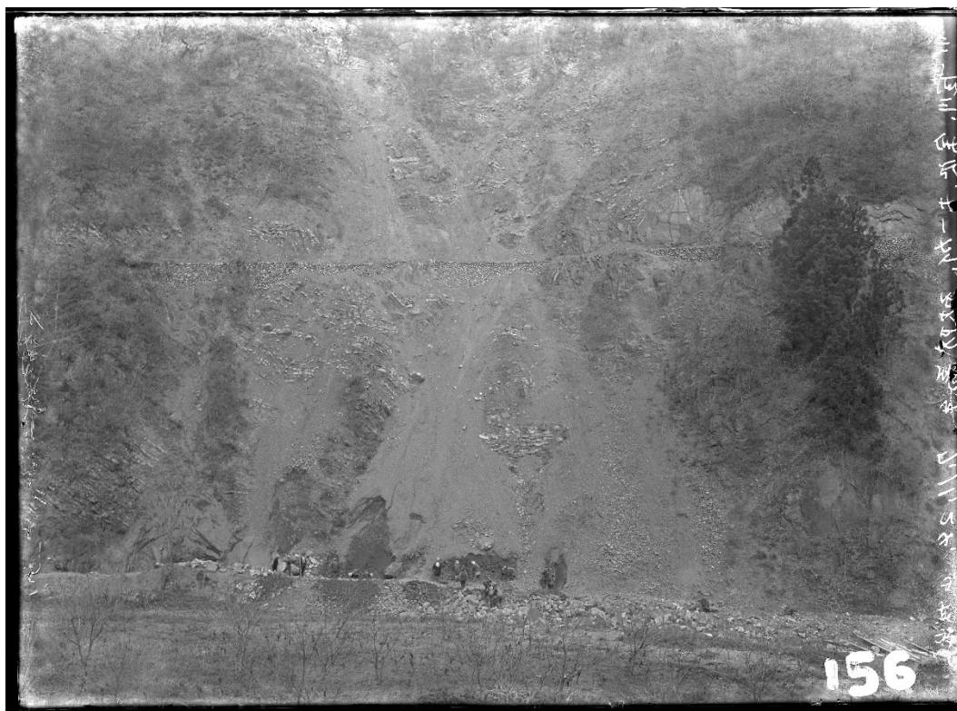
R246 小菅村 余沢崩壊(撮影時期不明)
