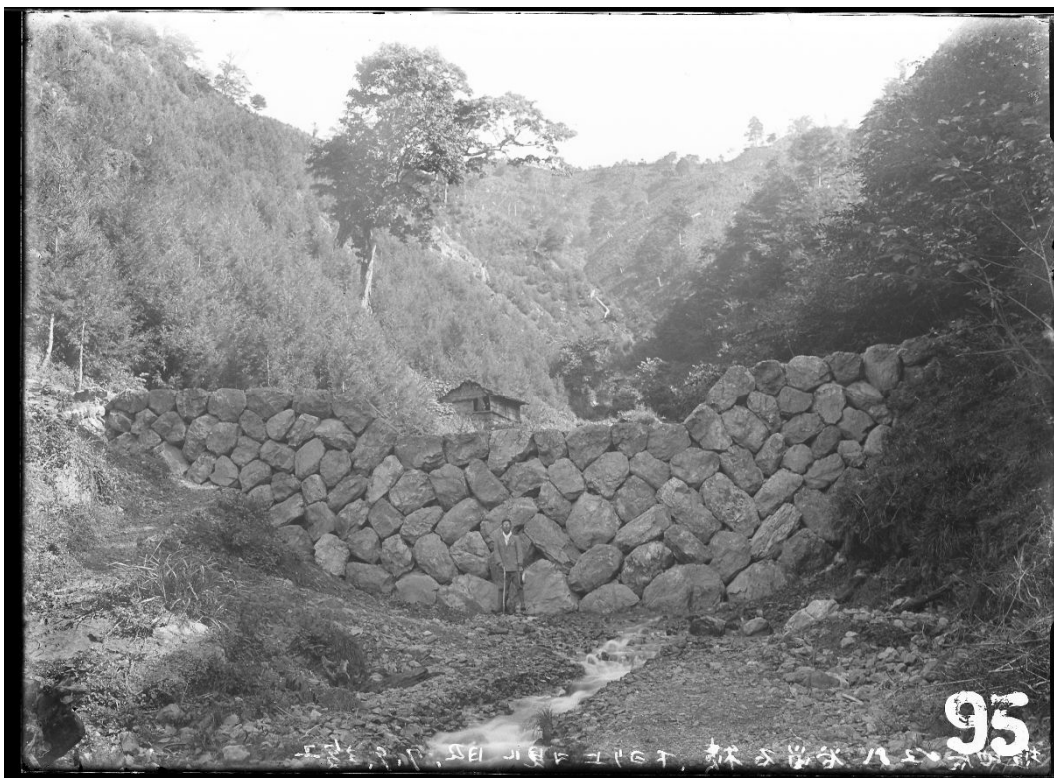
R221 シオジ谷 石堰堤(昭和7年9月)
