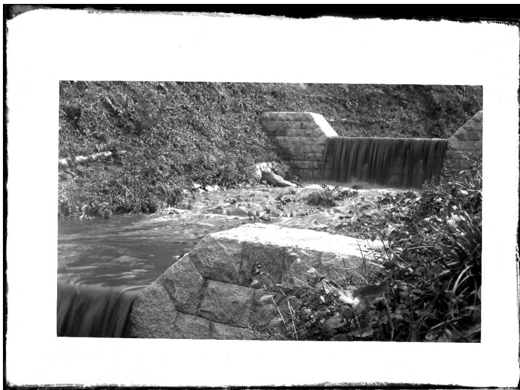
R250 水源林 石堰堤(撮影時期不明)
