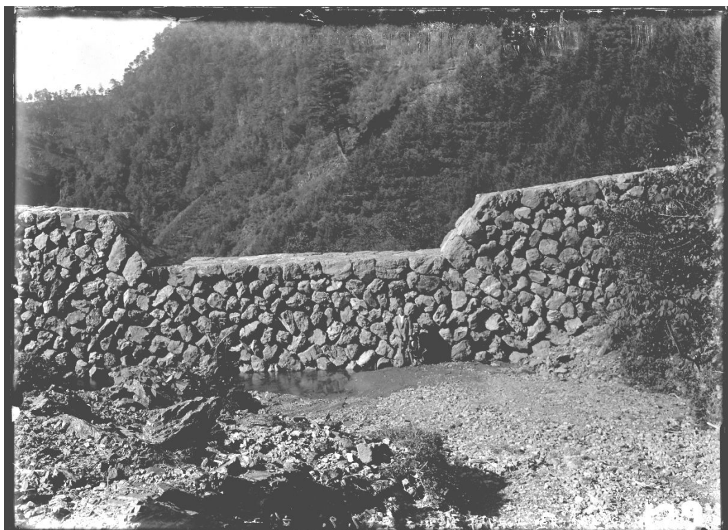
R225 シオジ谷 第8石堰堤(昭和7年9月20日)
