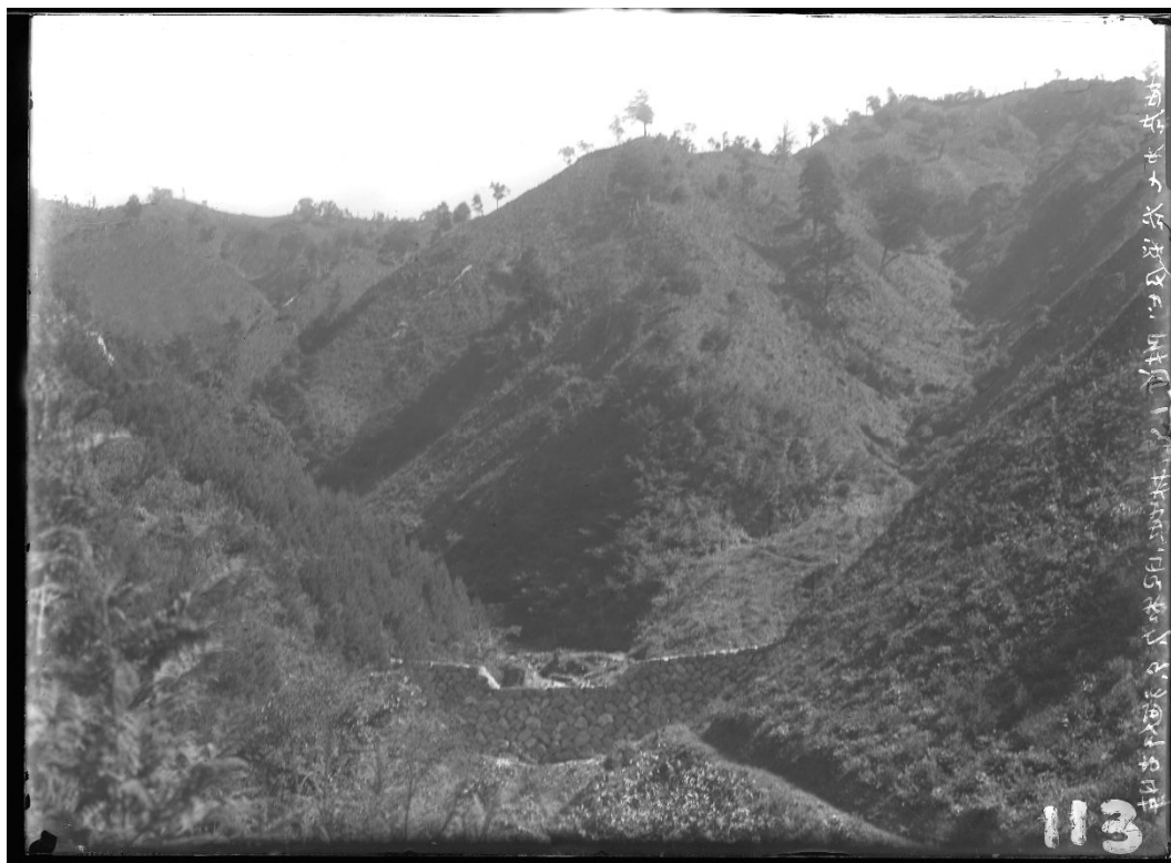
R224 シオジ谷 第7石堰堤(昭和7年9月)
