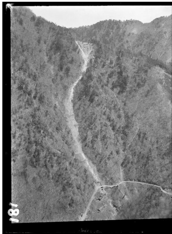
R253 水源林 崩壊地(撮影時期不明)
