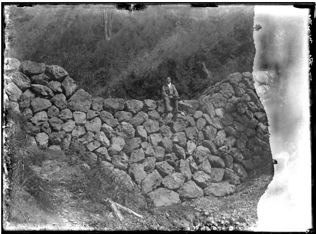
R220 シオジ谷 石堰堤(昭和7年9月)
