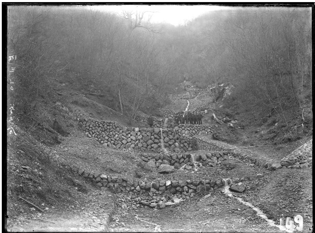
R213 釜土谷 堰堤工事(昭和3年10月)
