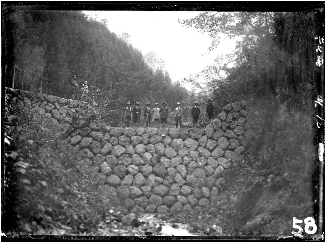
R206 水久保沢 石堰堤(撮影時期不明, 写真に「5 年 10 月」の文字あり)
