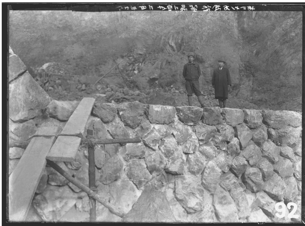
R185 ありさめ 堰堤(昭和 24 年 2 月)
