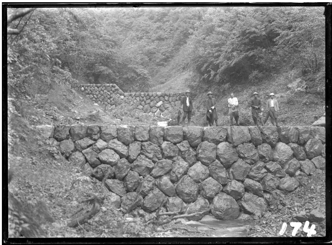
R194 モクボ谷 石堰堤(昭和 11 年 5 月) 【「砂防」口絵写真集 S48-2 と同一写真】
