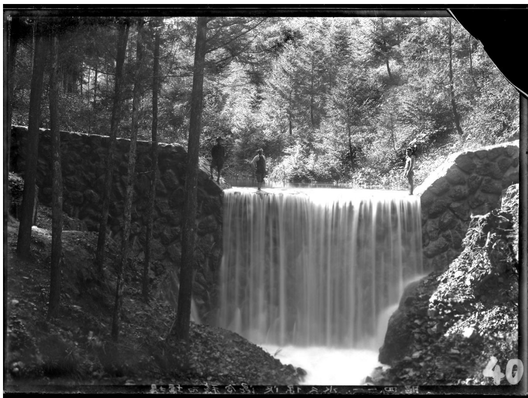
R203 ミズクボ沢 混合積石堰堤(昭和4年11月)
