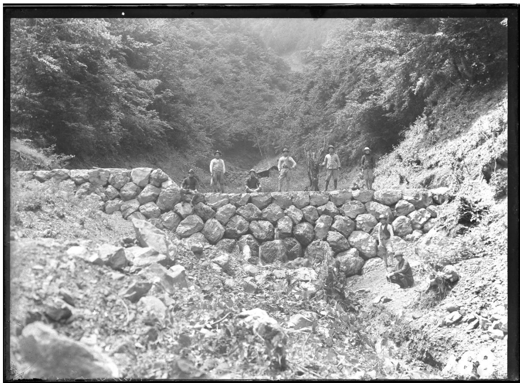
R209 サイグチ 石堰堤(昭和 11 年 2 月)
