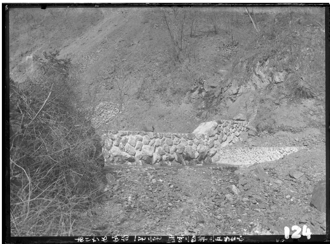
R186 ありさめ 砂防 1 号 2 号工事(昭和 24 年 2 月)
