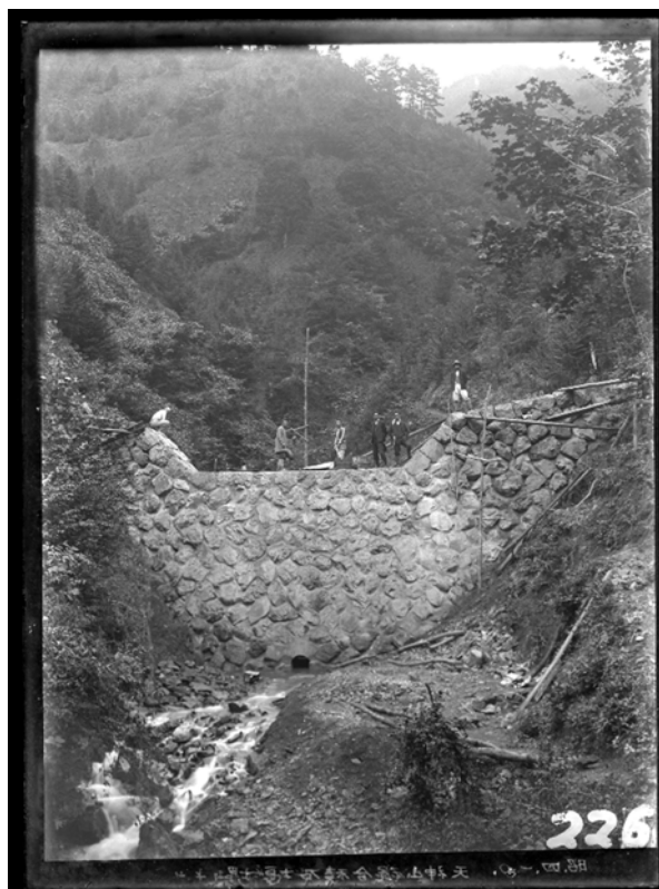
R197 天神山 混合積石堰堤(昭和4年10月)
