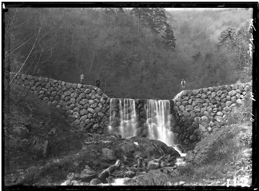
R192 モクボ谷 石堰堤(撮影時期不明, 写真に「5年3月」の文字あり)
