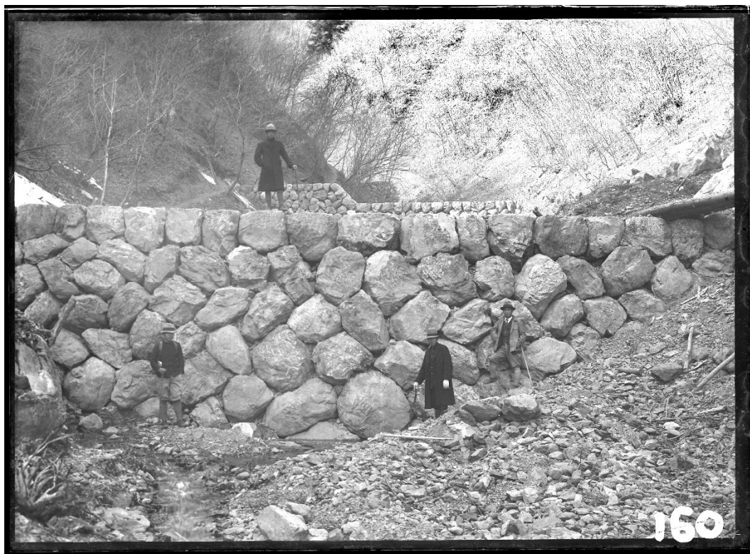
R193 モクボ谷 石堰堤(昭和11年3月)
