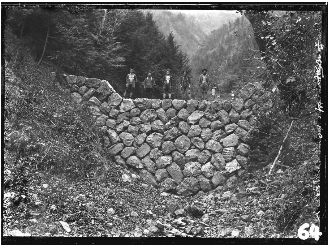
R207 水久保沢 石堰堤(撮影時期不明, 写真に「5 年 10 月」の文字あり)
