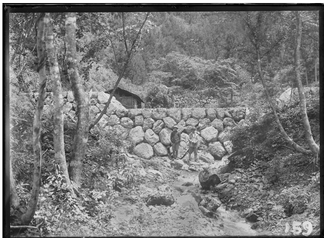
R211 ヌタクボ谷 石堰堤(昭和 11 年)
