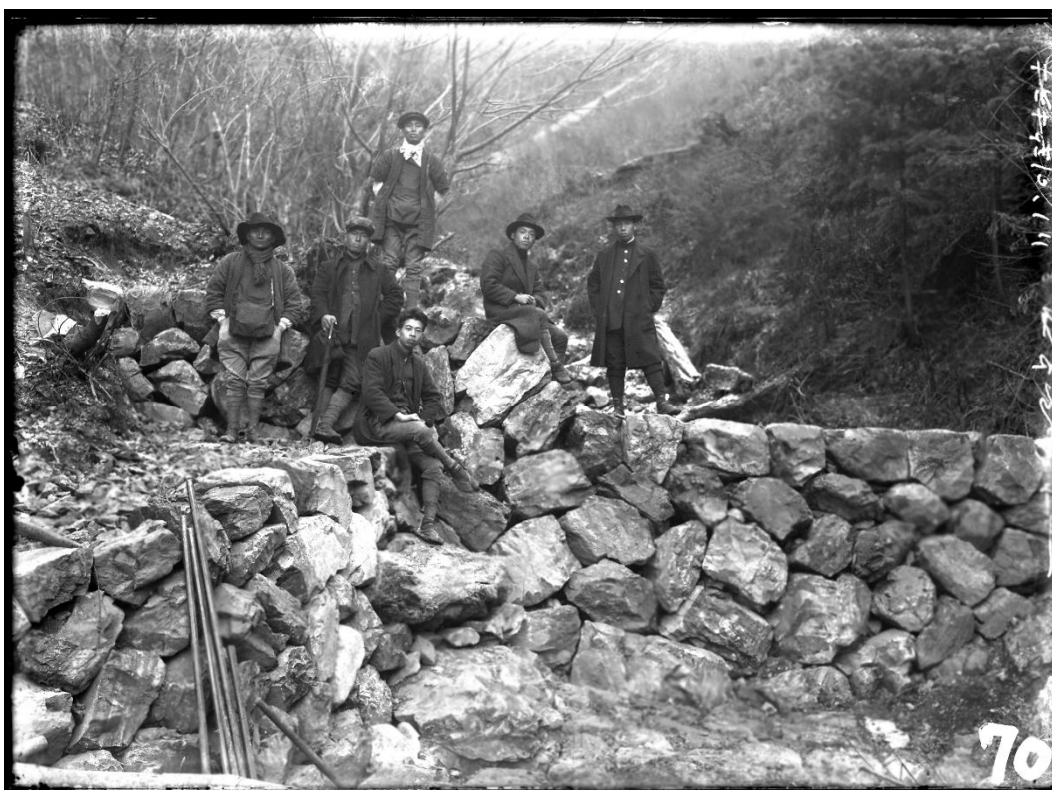
R166 サカサ沢 石堰堤(大正 10 年 12 月)
