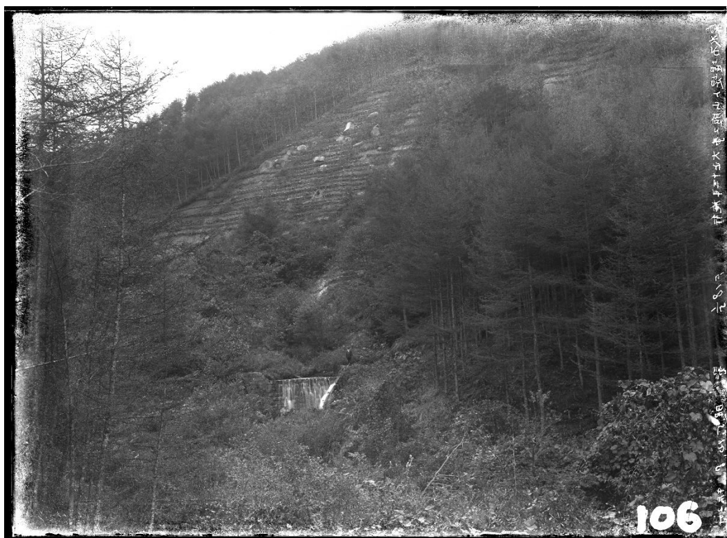
R156 センスイ谷 石堰堤 山腹工 大正 13 年施行(昭和 5 年 10 月 8 日)
