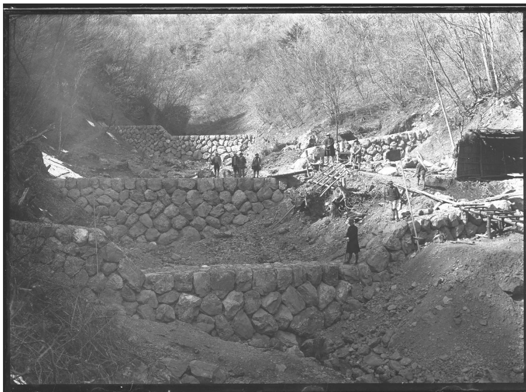
R195 モクボ谷 石堰堤(昭和 11 年 8 月)
