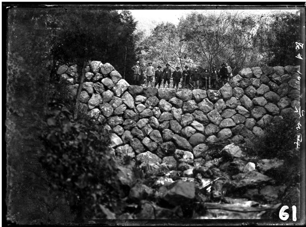
R204 ミズクボ沢 石堰堤(昭和5年9月)
