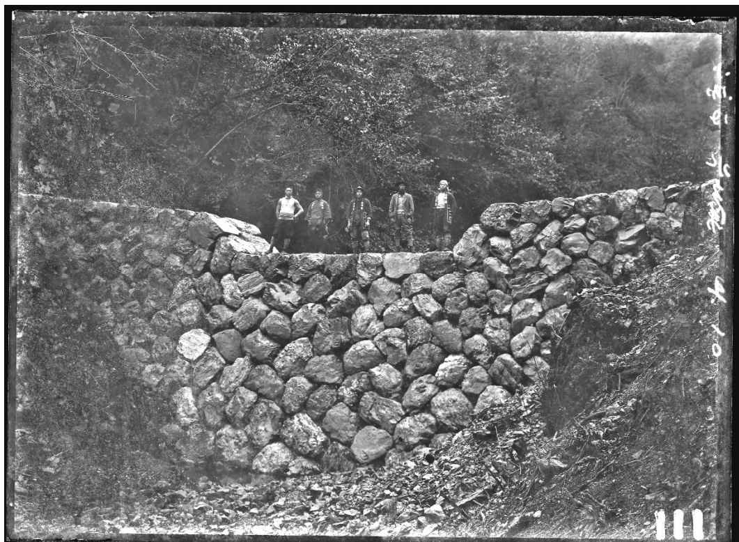
R205 水久保沢 石堰堤(昭和5年10月)
