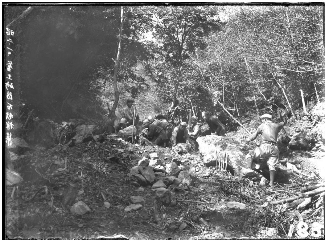
R214 釜土砂防 石材採取(昭和2年10月)
