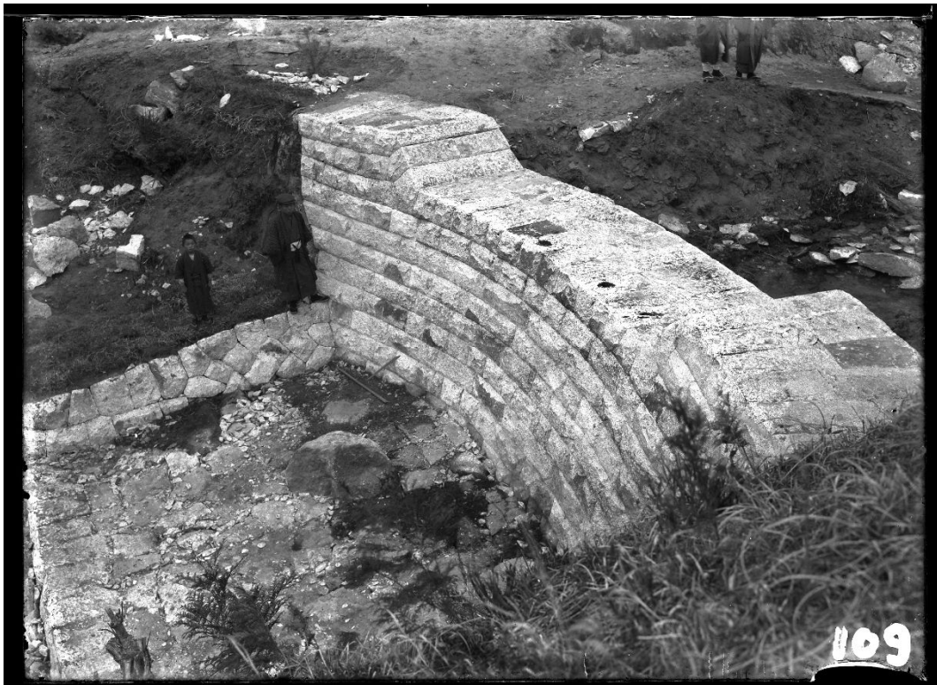
R066 シシネド沢 石堰堤(アーチ) (大正 5 年 12 月) 【諸戸北郎博士収集写真集 1019 と同一写真】
