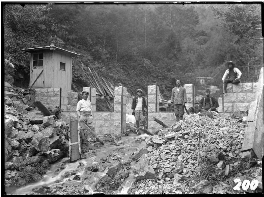
R083 カネバ沢 量水堰堤(改築中)(撮影時期不明)
