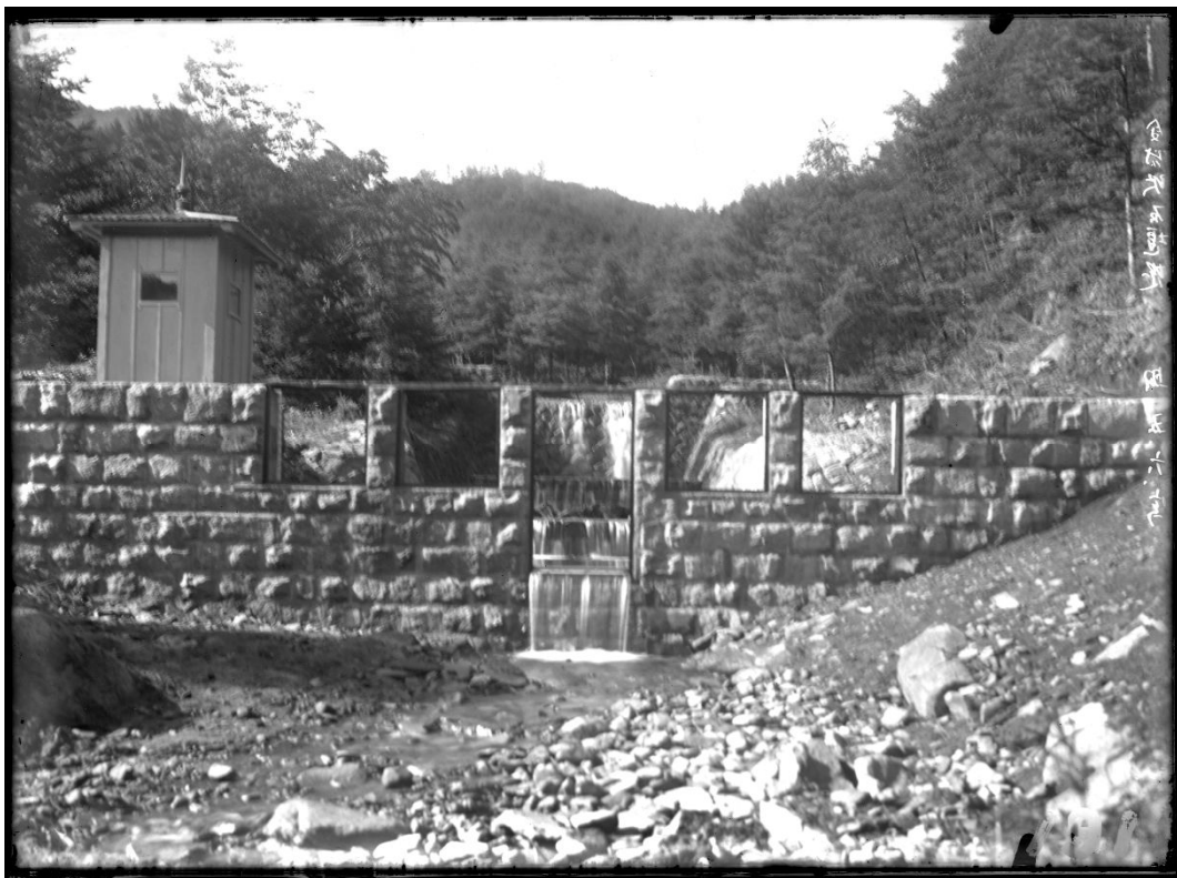
R089 カネバ沢 量水堰堤(昭和 5 年 6 月)
