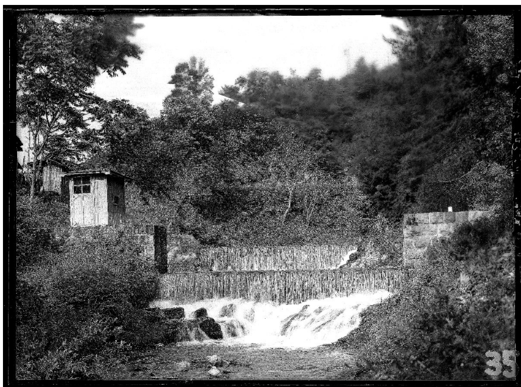
R103 高橋川 量水堰堤(撮影時期不明, 写真に「12 年 6 月 26 日」の記載あり)
