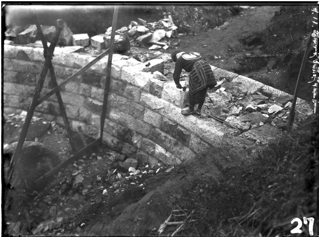
R065 シシネド沢 石堰堤(施工中)(大正5年11月) 【諸戸北郎博士収集写真集 1008 と同一写真】
