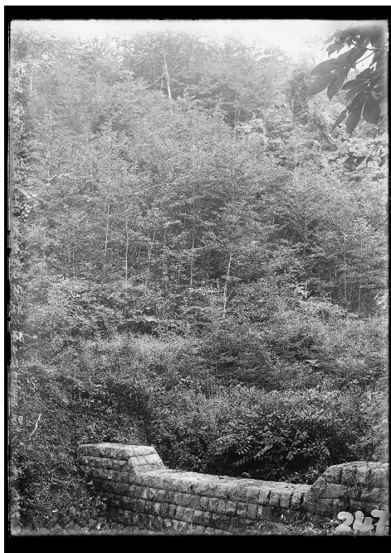
R097 カネバ沢 石堰堤 砂防工事施工 10 年目 (昭和 2 年 8 月)
