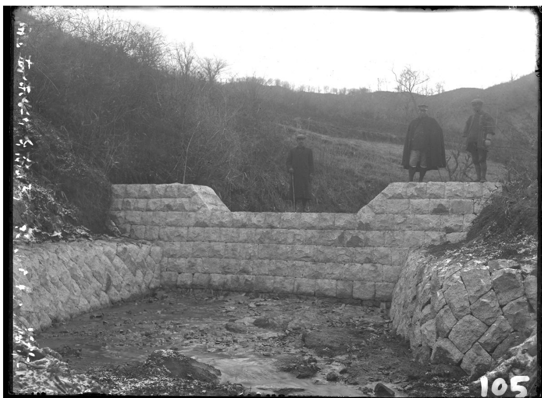
R132 馬場沢願地脇谷 第二石堰堤(大正 6 年 11 月)
