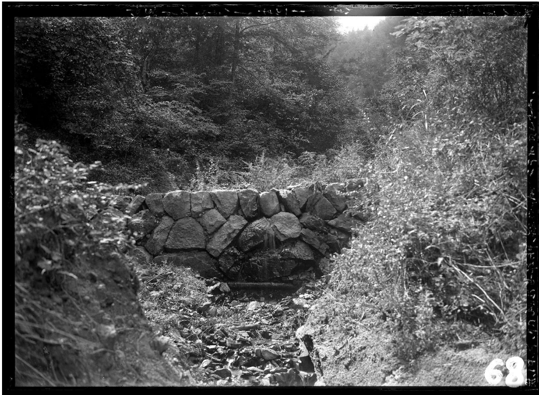
R139 犬切沢 石堰堤(昭和 15 年 9 月 27 日)
