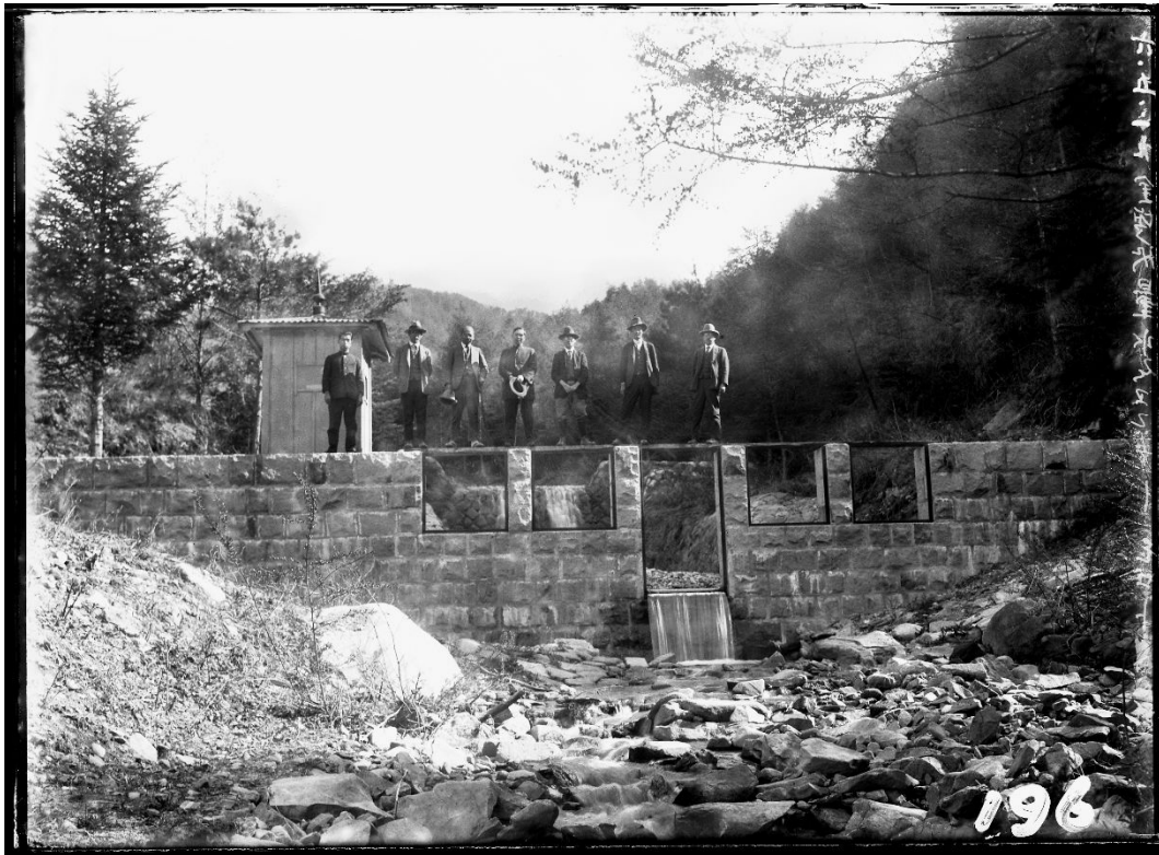
R088 カネバ沢 量水堰堤(昭和 6 年 5 月)
