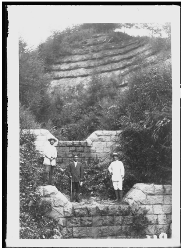
R133 馬場沢 石堰堤 山腹工(昭和 10 年 8 月)
