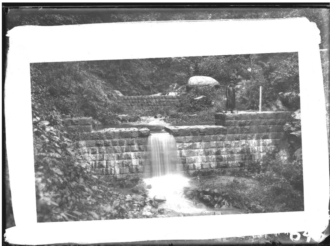
R093 カネバ沢 上流の量水堰堤 裏焼き(撮影時期不明)
