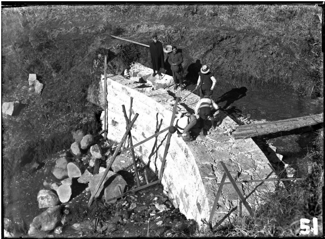
R064 シシネド沢 石堰堤(施工中)(左から2人目 諸戸博士)(大正5年12月) 【諸戸北郎博士収集写真集 1010 と同一写真】
