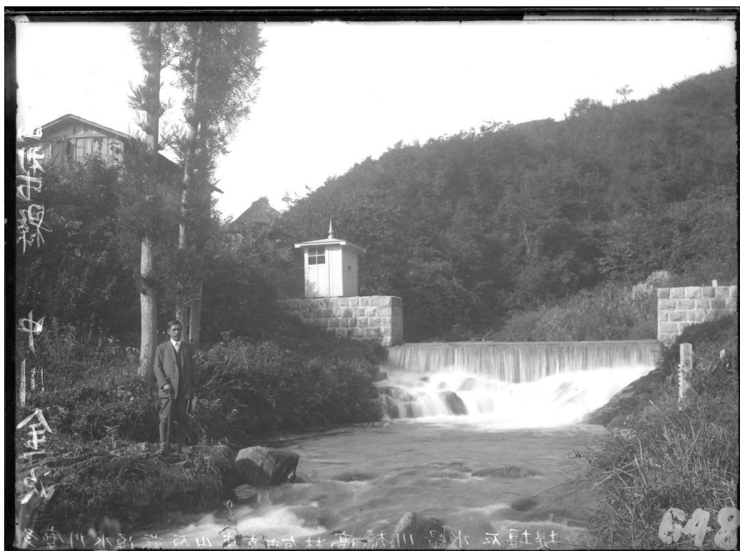
R102 高橋川 量水堰堤 諸戸博士(撮影時期不明) 【諸戸北郎博士収集写真集 1032 (撮影時期不明) と同一写真】
