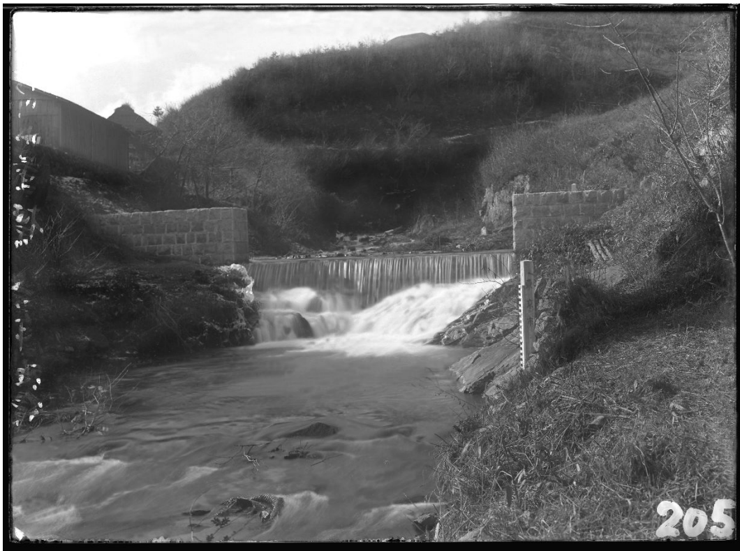
R098 高橋川 量水堰堤 大正 6 年施行(撮影時期不明) 【諸戸北郎博士収集写真集 1003 (大正 6 年 11 月 21 日) と同一写真】
