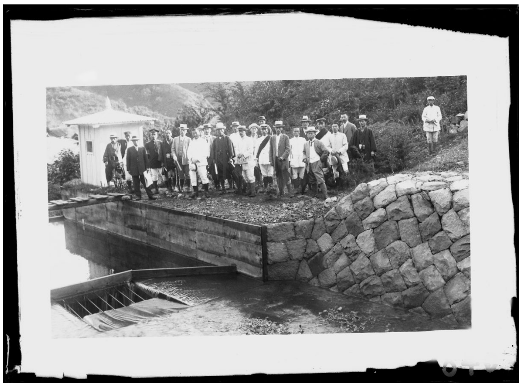
R076 カネバ沢 量水堰堤 山梨県知事視察(大正 6 年 9 月 18 日)
