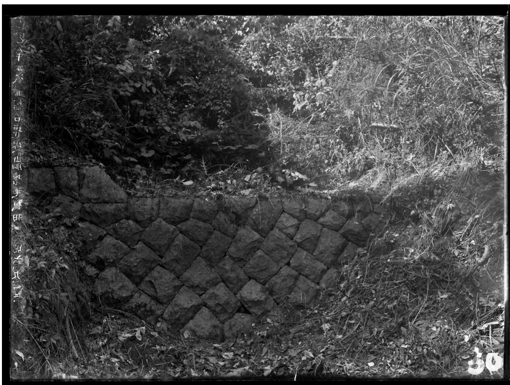
R129 ヒノキオ沢 石堰堤(昭和5年9月)
