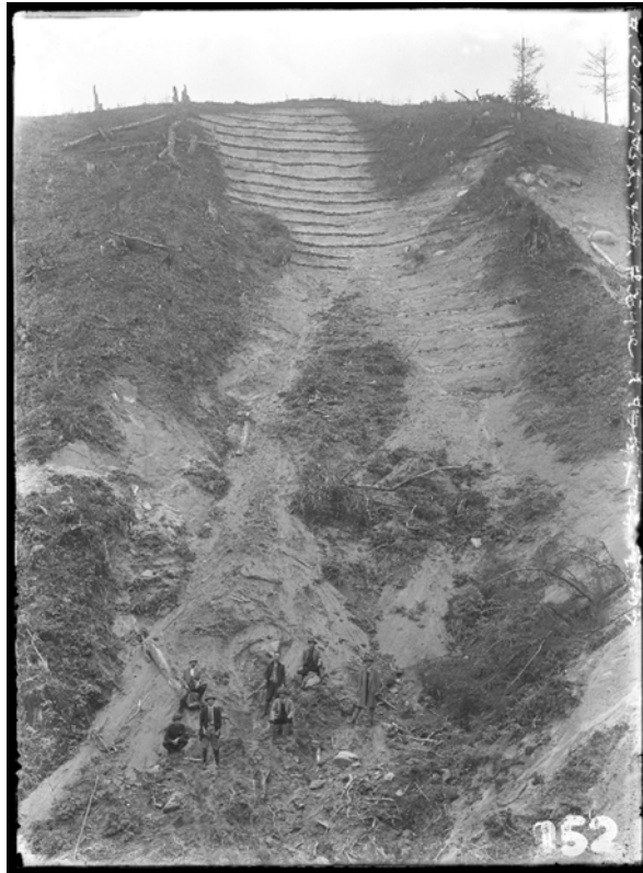
R106 高橋川 山腹工 手植(昭和5年10月)
