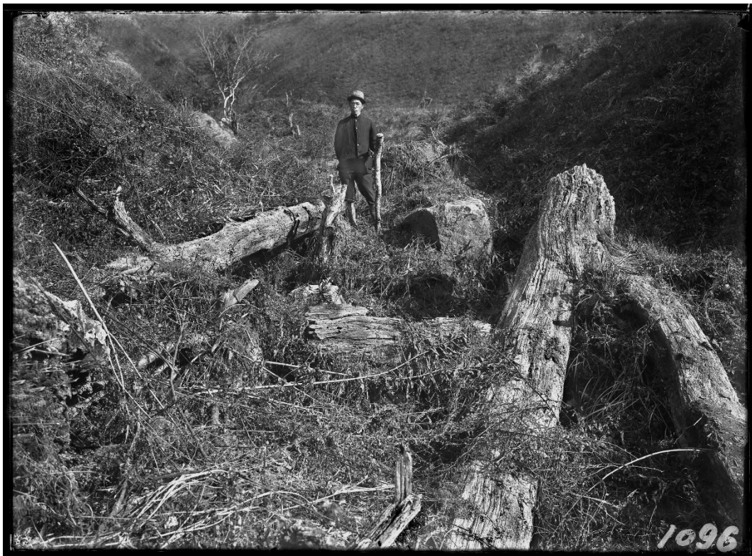
R074 シシネド沢 荒廃状況 明治40年8月の山津波による荒廃地(大正5年)
