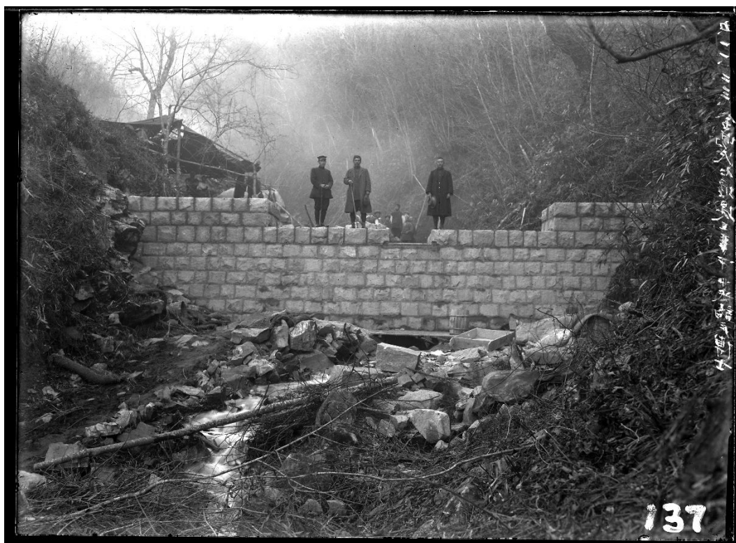
R092 カネバ沢 上流の量水堰堤(大正5年11月)
