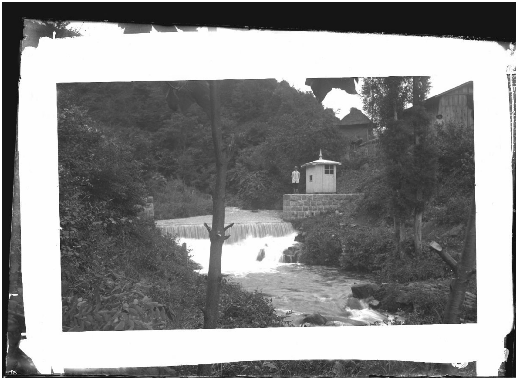
R100 高橋川 量水堰堤(裏焼き) (大正 10 年 7 月)
