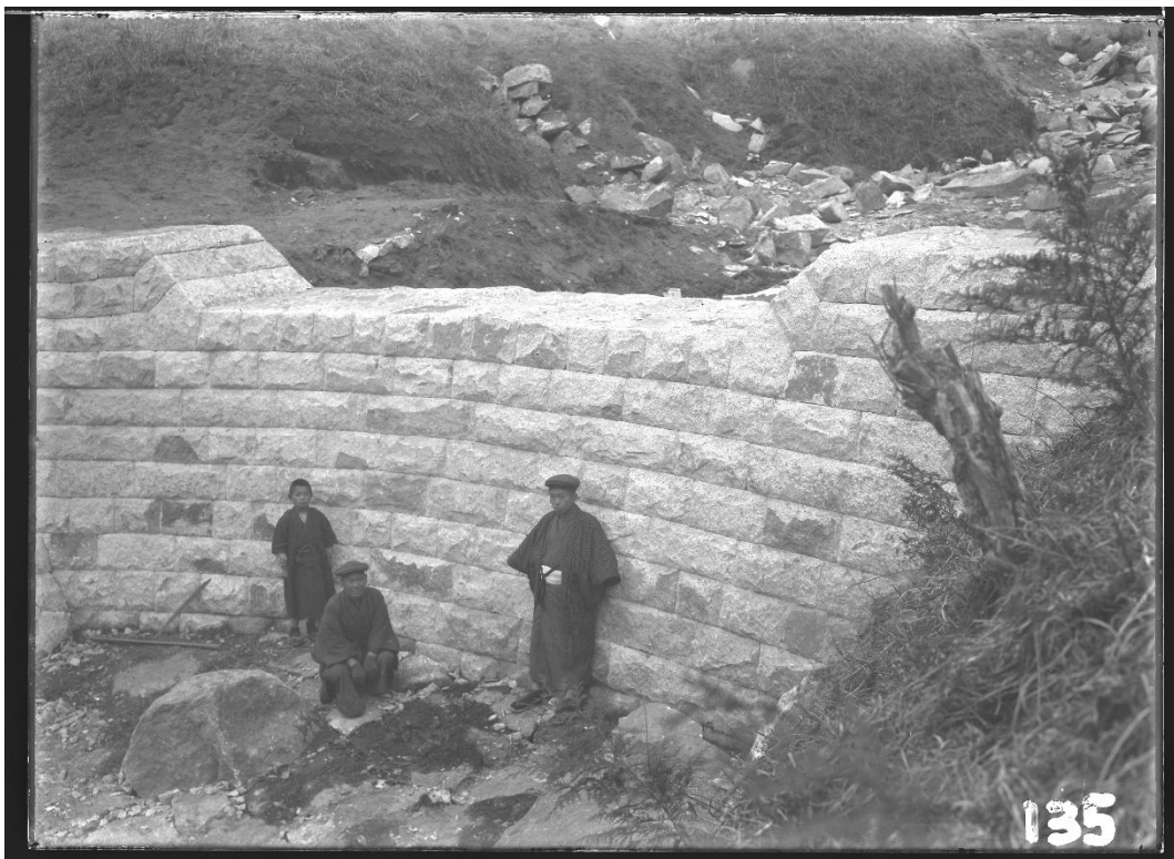
R067 シシネド沢 石堰堤(アーチ) (大正 5 年 12 月) 【諸戸北郎博士収集写真集 1018 と同一写真】
