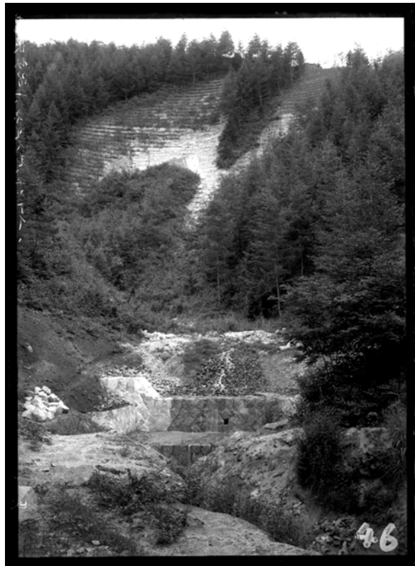
R140 犬切沢 練積堰堤(撮影時期不明)
