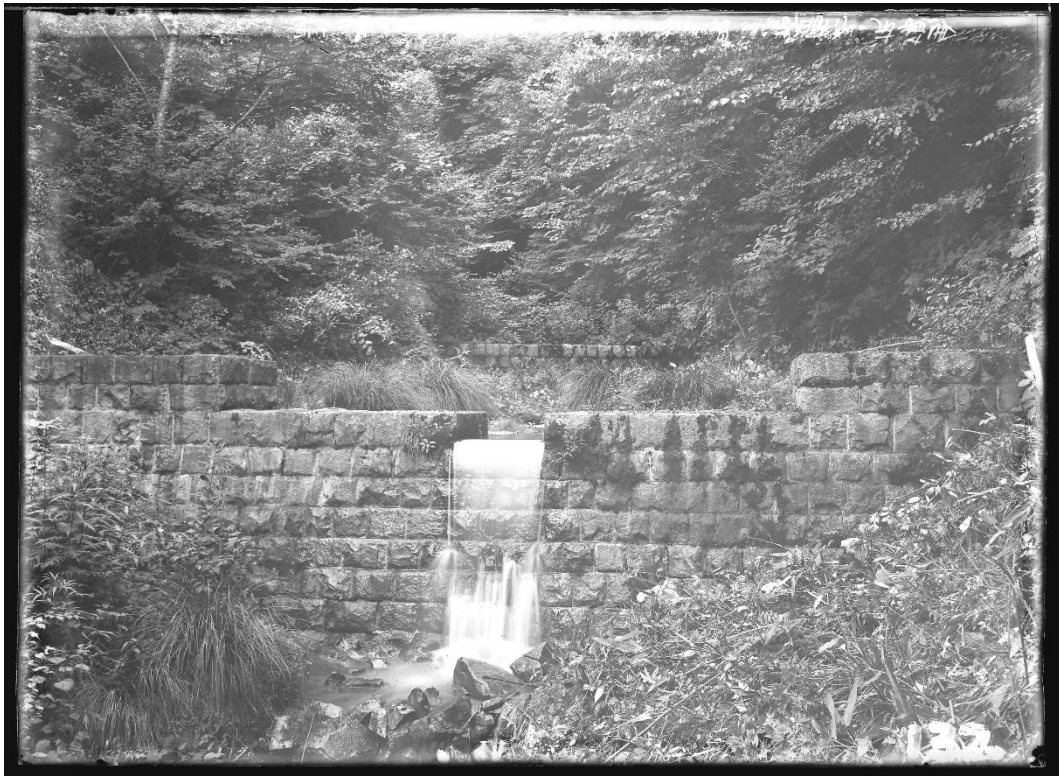
R094 カネバ沢 上流の量水堰堤(大正 15 年 7 月)
