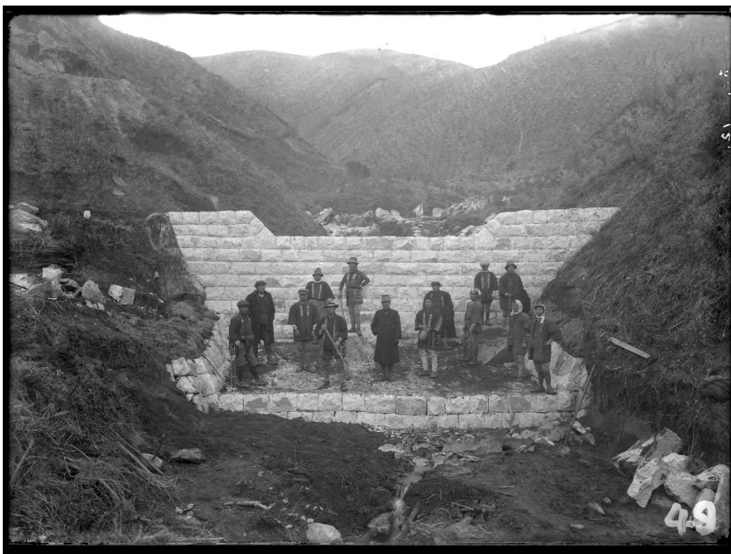
R069 シシネド沢 石堰堤(アーチ)(大正 5 年 12 月)
