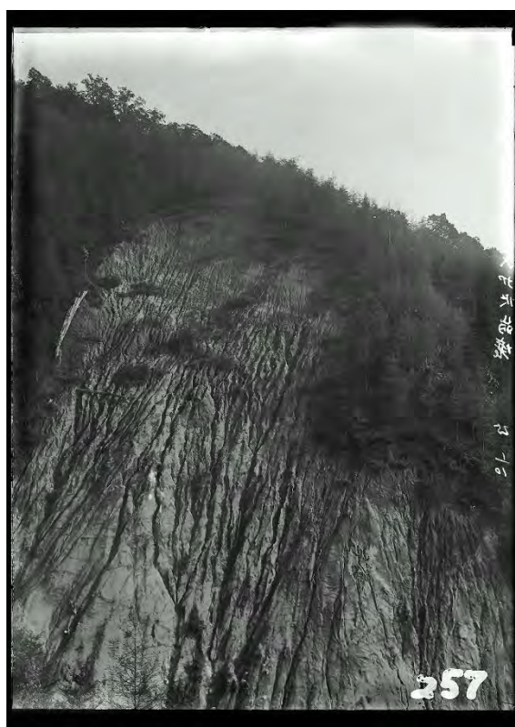
R135 犬切沢 関東大地震による崩壊地（大正 13 年 8 月）
