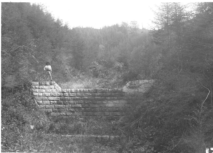
R071 シシネド沢 石堰堤(アーチ)(大正 12 年)
