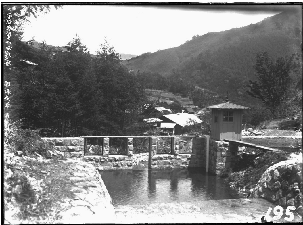
R087 カネバ沢 量水堰堤(昭和 5 年 5 月)
