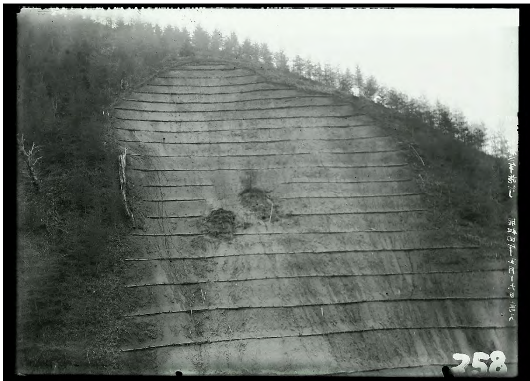
R137 犬切沢 山腹工 (昭和4年5月16日)
