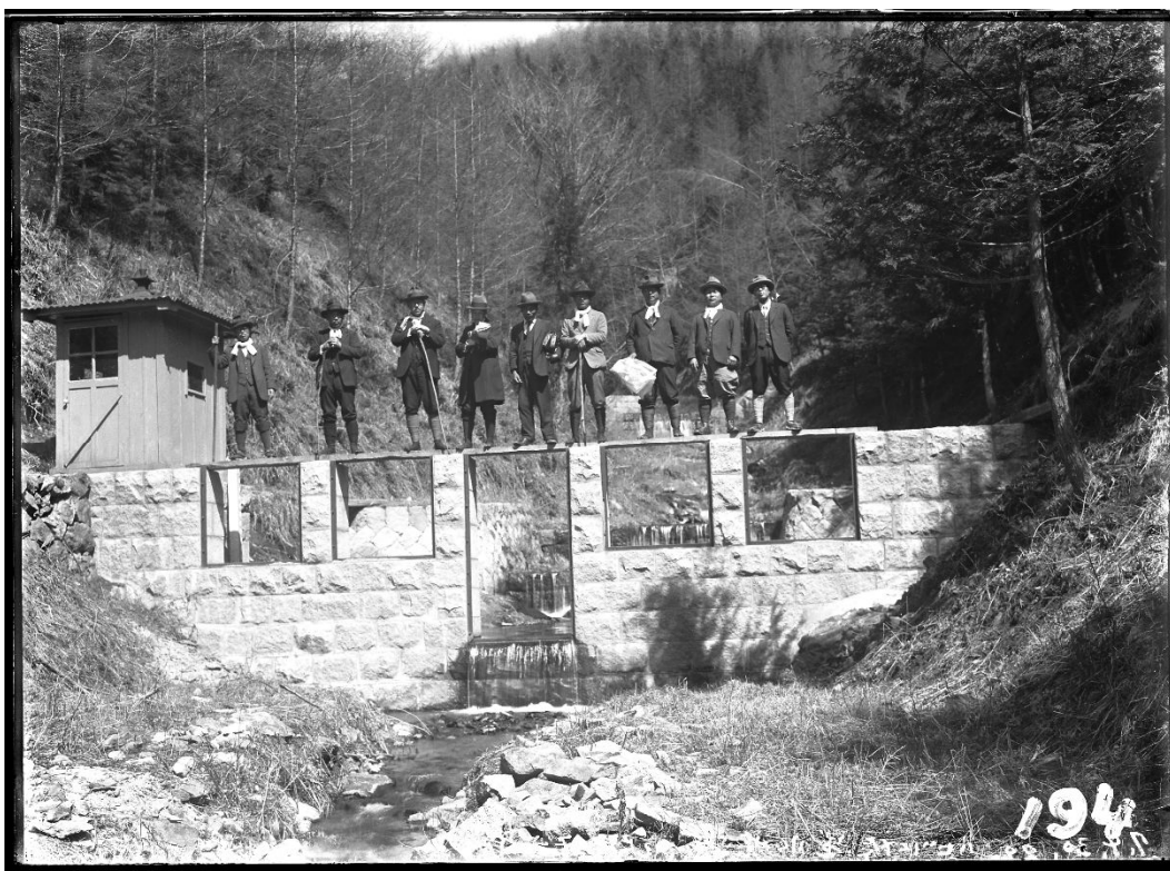
R041 ハビロ沢 量水堰堤(昭和 7 年 4 月)
