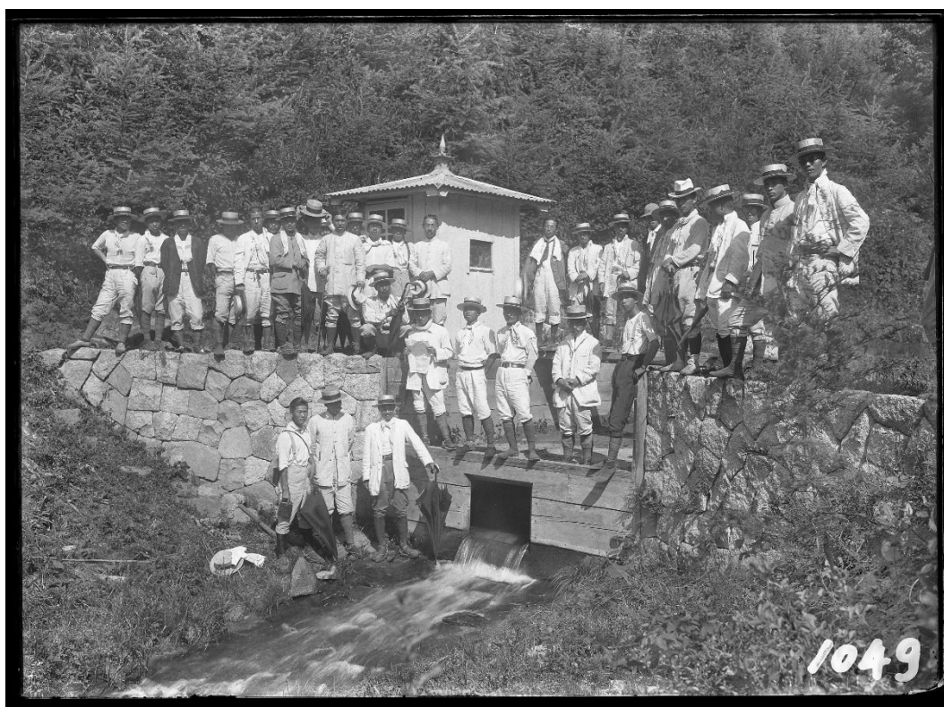
R034 ハビロ沢 量水堰堤 砂防講習生(撮影時期不明)
