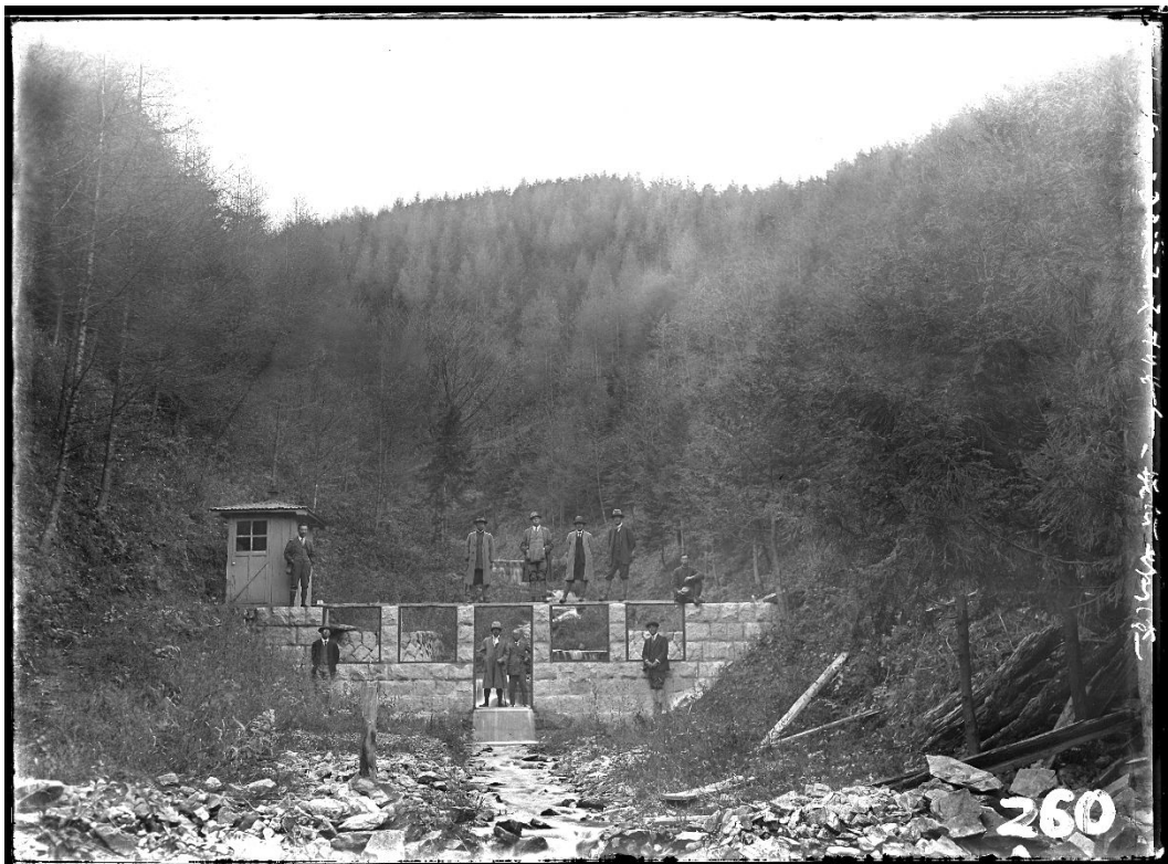
R036 ハビロ沢 量水堰堤(昭和5年2月)
