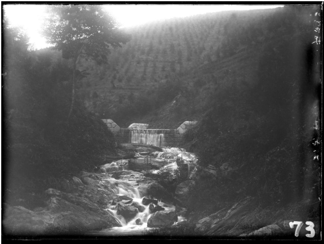
R050 ハビロ沢 石堰堤 砂防工事施工後 6 年目 (大正 9 年 8 月)
