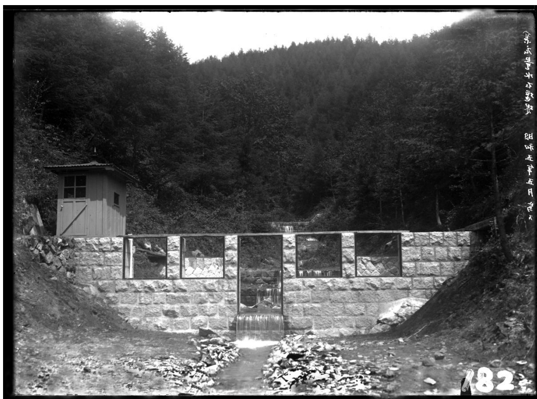
R037 ハビロ沢 量水堰堤(昭和 5 年 5 月)
