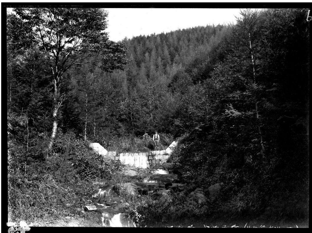
R054 ハビロ沢 石堰堤 砂防工事施工後 13 年目(昭和 2 年 8 月)
