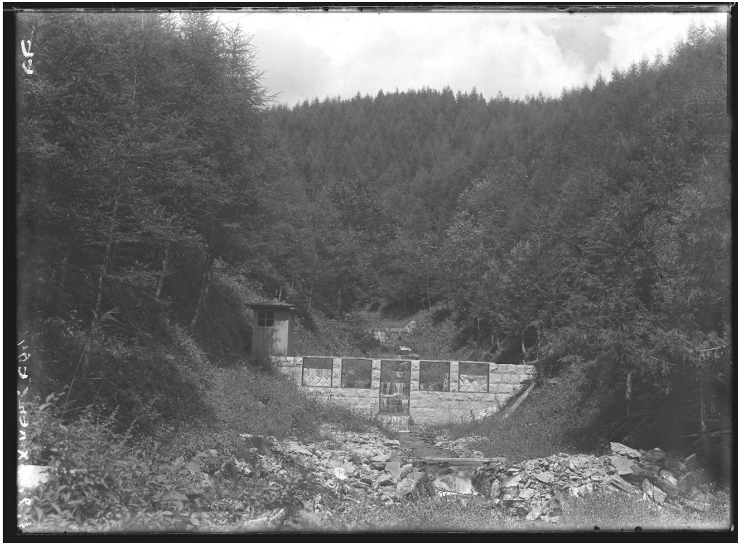
R039 ハビロ沢 量水堰堤(昭和 5 年 9 月)
