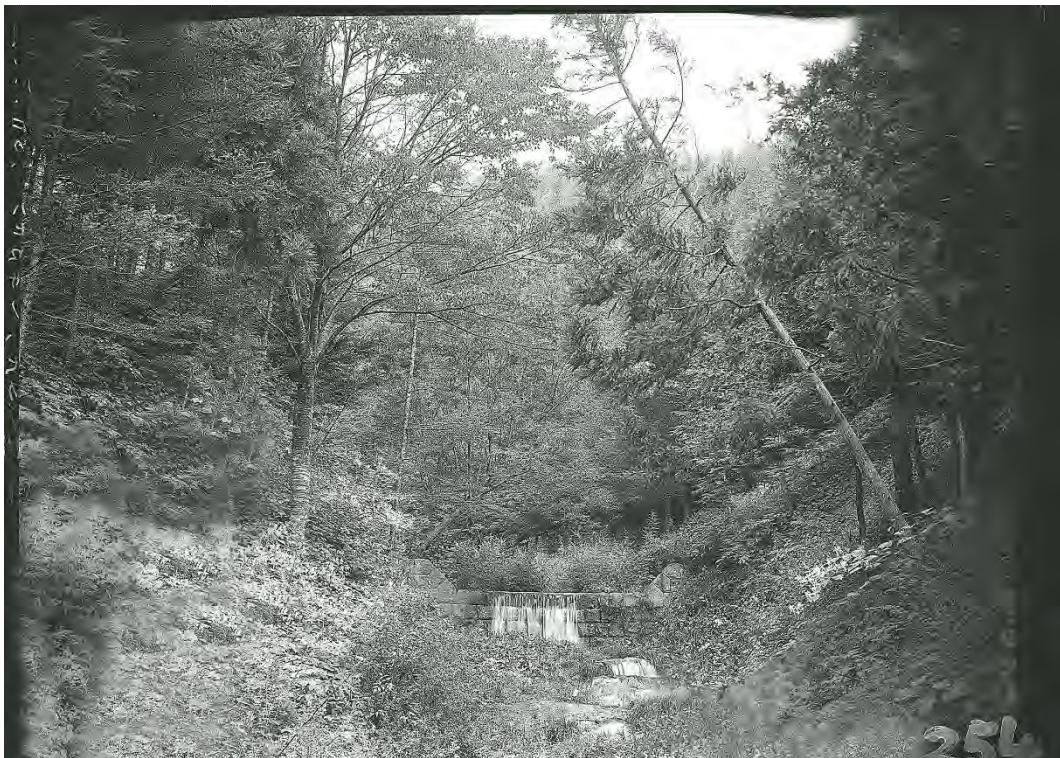
R056 ハビロ沢 石堰堤 砂防工事施工後 21 年目(昭和 10 年 8 月 20 日)
