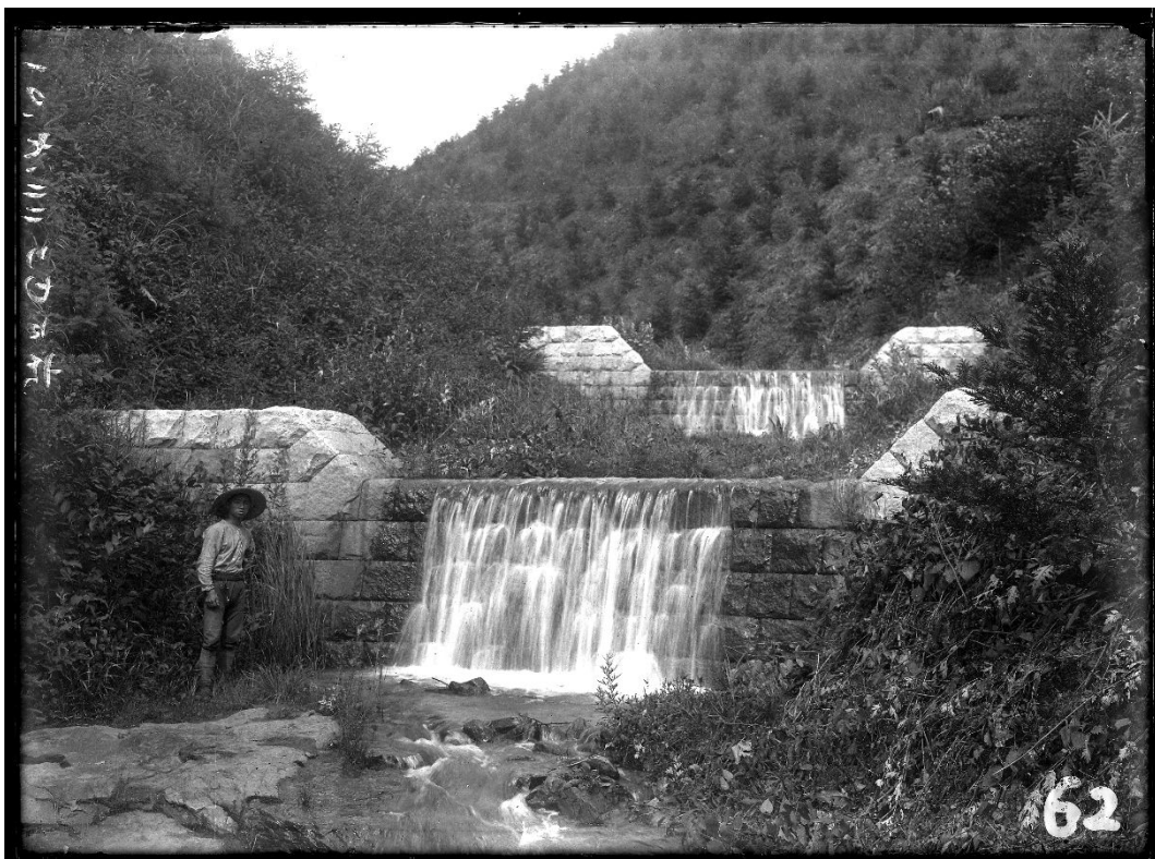
R051 ハビロ沢 石堰堤 砂防工事施工後 7 年目 (大正 10 年 7 月 22 日)
