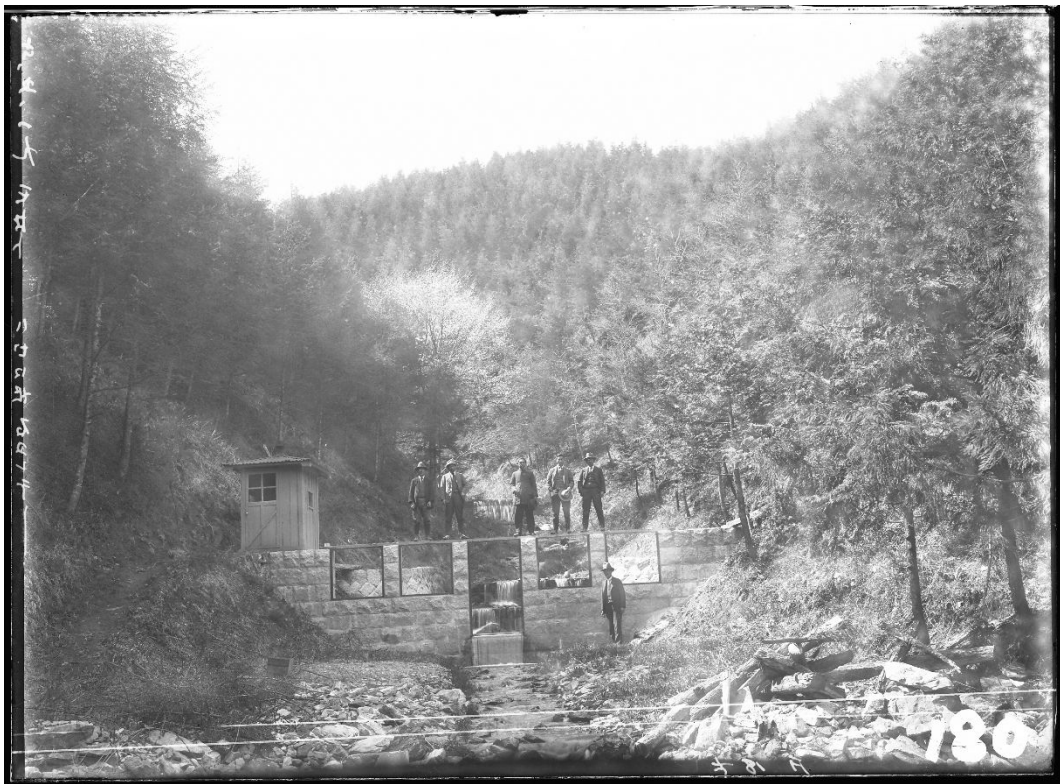
R040 ハビロ沢 量水堰堤(昭和 6 年 5 月 19 日)
