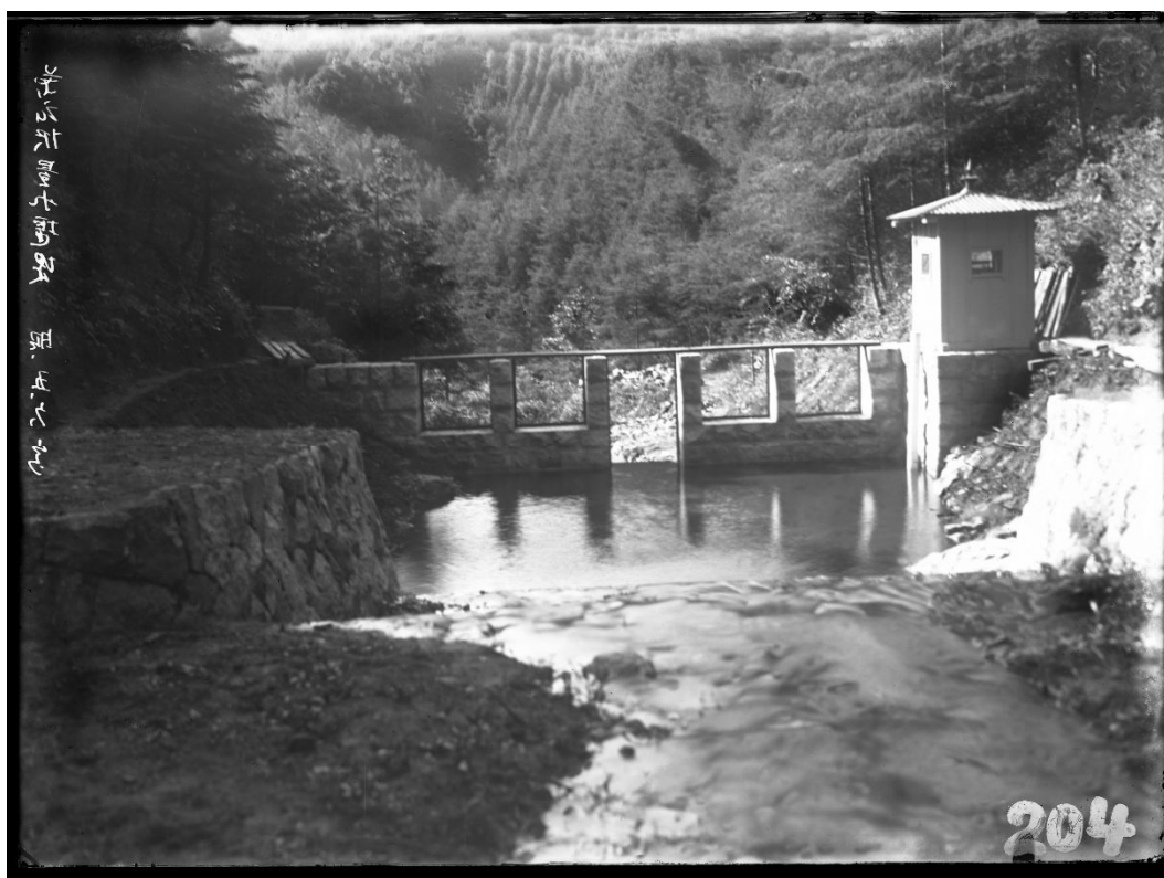
R038 ハビロ沢 量水堰堤(昭和 5 年 6 月)
