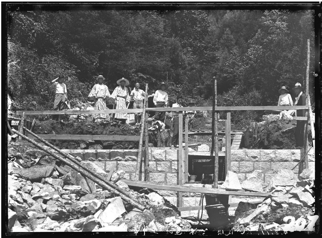
R035 ハビロ沢 量水堰堤(工事中)(昭和4年8月11日)
