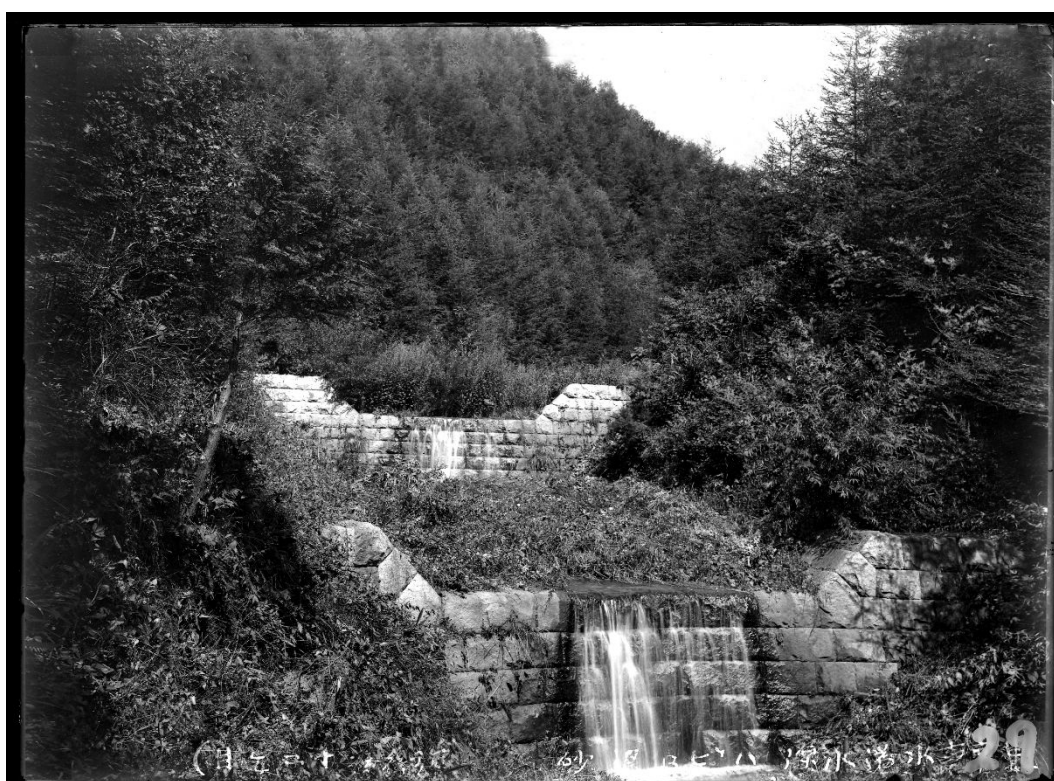
R053 ハビロ沢 石堰堤 (撮影時期不明, 写真に「10 年」の文字あり)
