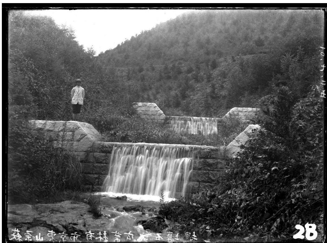
R052 ハビロ沢 石堰堤 砂防工事施工後 7 年目 (大正 10 年 7 月 25 日)
