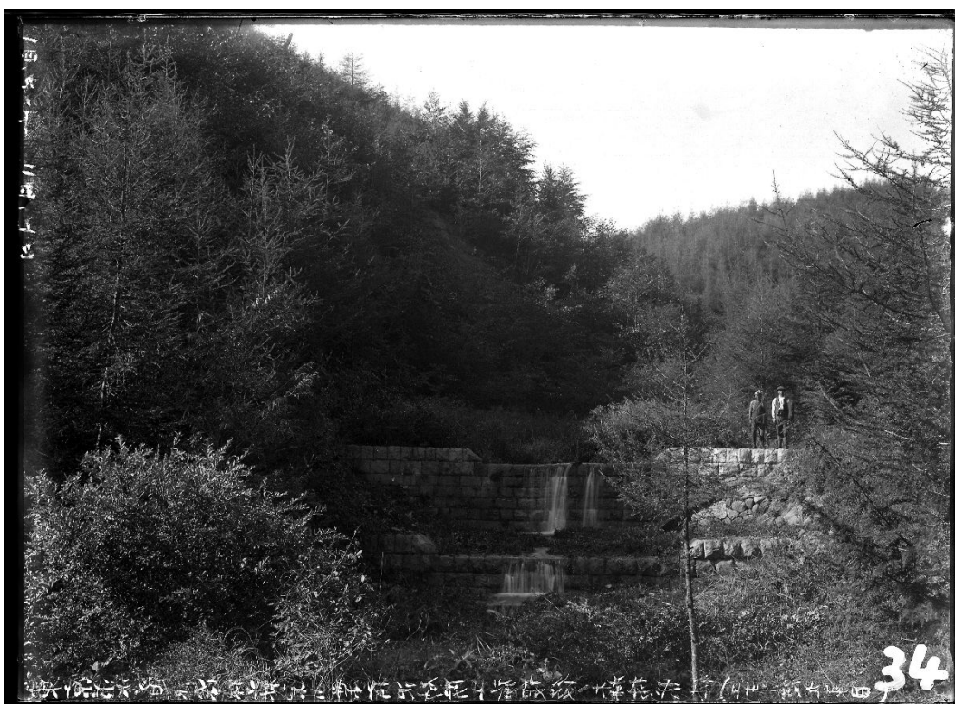
R044 ハビロ沢 石堰堤 復旧 10 年後(大正 14 年 9 月)
