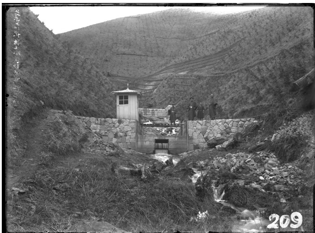
R033 ハビロ沢 量水堰堤 大正4年施工(大正5年1月)
