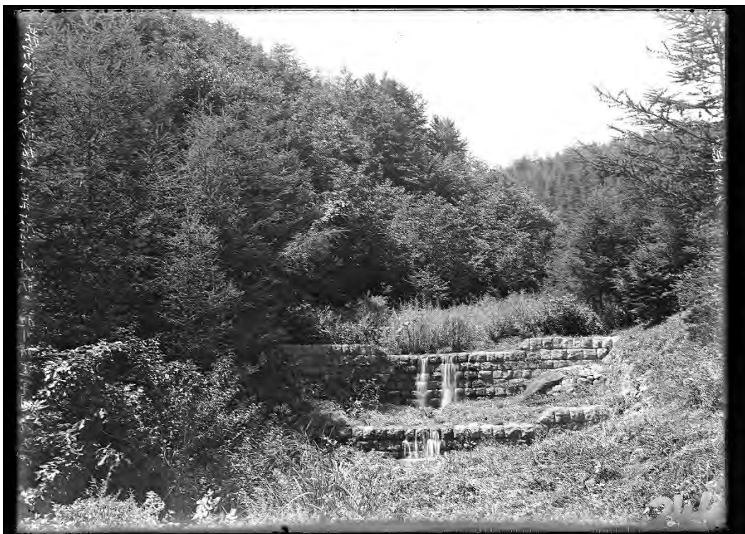
R043 ハビロ沢 石堰堤 復旧 10 年後(大正 14 年 8 月)
