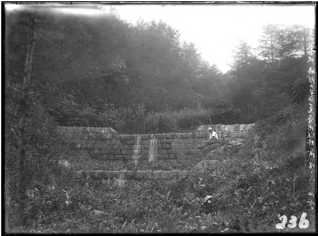
R045 ハビロ沢 石堰堤 復旧 12 年後(昭和 2 年 8 月)
