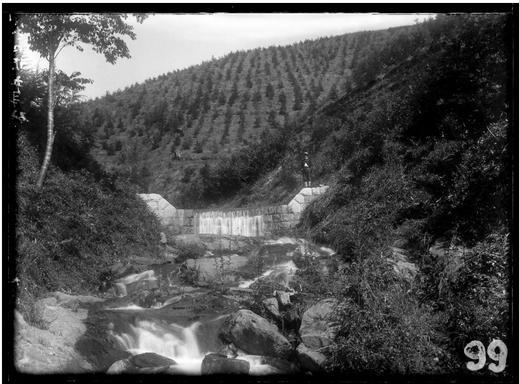
R049 ハビロ沢 石堰堤 砂防工事施工後6年目(大正9年8月) 【「砂防」口絵写真集 S39-2 と同一写真】
