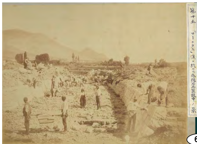
Dalmatien Wildbach "Mahnitas" bei Knin; Cünetten-Endstück im Bau 「マーニタス」溪ニ於ケル 底張石工築設中ノ景
