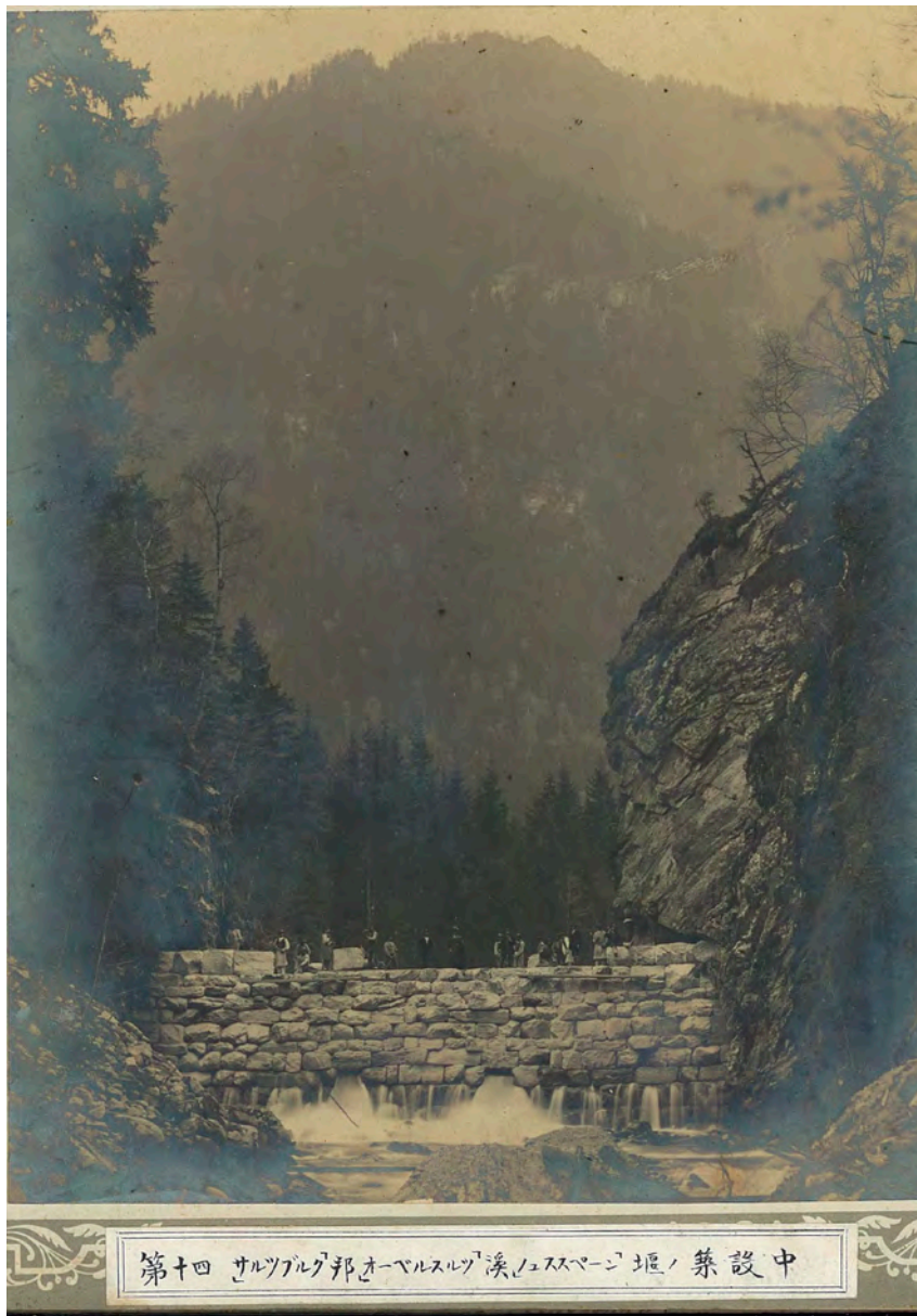
Obersulzbach 「ザルツブルク」邦「オーベルスルツ」溪 「ノユスペーン」堰の築造中
