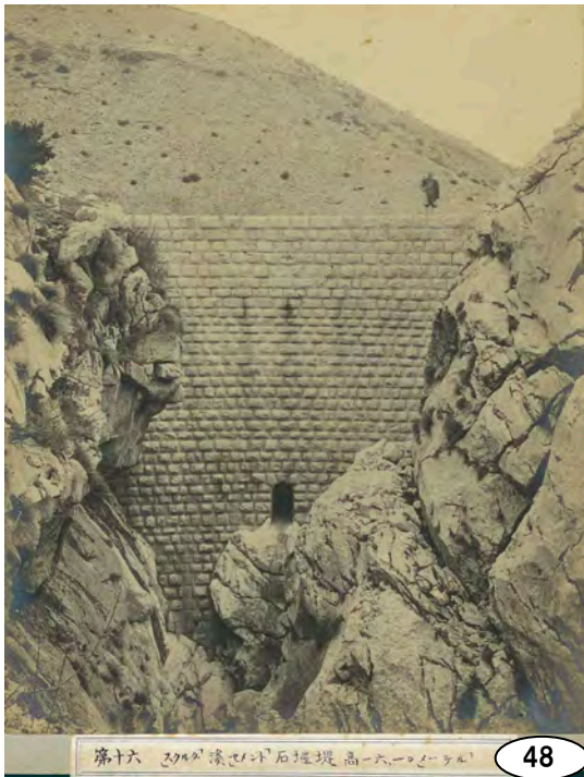
Wildbach "Škurda" in Montenegro/ Thalsperre Nr. 1 / 16,10 m hoch/ in Portland-Cementmauerung 「シュクルダ」溪「セメント」 石堰堤 高十六、一〇「メートル」
