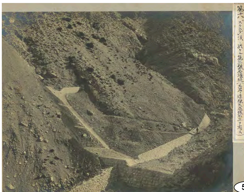
Škurda / Thalsperre Nr. 3, Leitwerk und Leitwerk und Künette auf dem rechtem Ufer 「シュクルダ」溪ニ於ケル第三号石堰 堤（右岸ニ導壁及底張石エヲ有ス）
