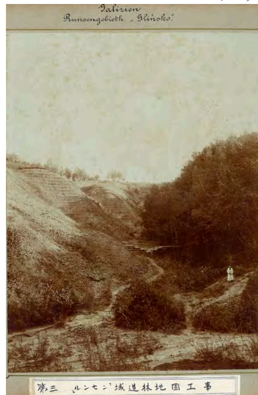
Galizien/ Runsengebieth "Glinsko" 「ルンセン」域造林地固工事
