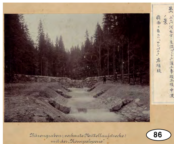
Bärengraben; verbaute Mittellaufstrecke; mit der "Rossipalsperre" 「エルベ」河左方ノ支流「ベーレン」溪工事竣工後 中流の景
