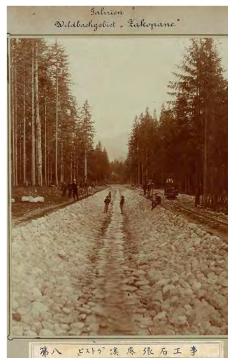
Galizien/ Wildbachgebiet "Zakopane" ガリツェン州・「ビストラ」溪 底張石工事
