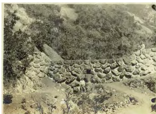
明神峠事業正峯坂澤 第一号堰堤 大正十五年春施行 大正十五年秋堰
