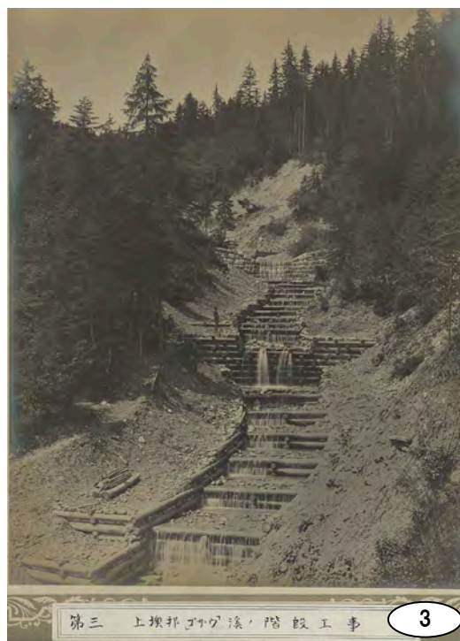
第三 上奥州「ゴザウ」溪ノ階段工事 3 Gosau Abtreppung im hinteren Glaselbach 上奥州「ゴザウ」溪ノ階段工事
