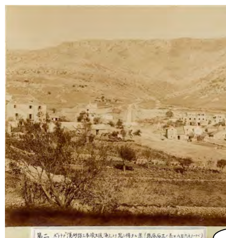
Dalmatien, Wildbach "Potocina" in Bol auf der Insel Brazza (kroatisch: Brac), nach der Verbauung 「ポトチナ」溪砂防工事竣工後海上ヨリ写シ得タル景 （張底石工ノ長サ八百六十「メートル」）
