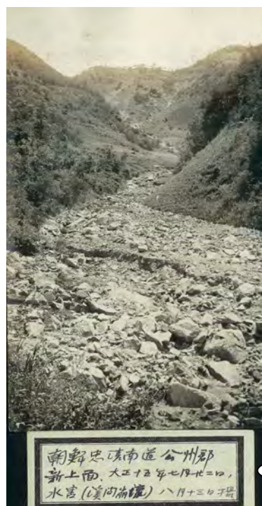
朝鮮 忠清南道 禮山郡 新陽面 大正十五年七月廿二日 水害 山腹崩壊死者一人 負傷者一人 崩壊した山腹は石が崩れ、谷に落ち、谷の底に石が堆積した。八月十四日に撮影
