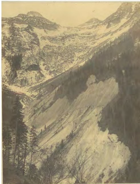
第四 上奥邦 ギム溪砂防設備以前ノ状態
