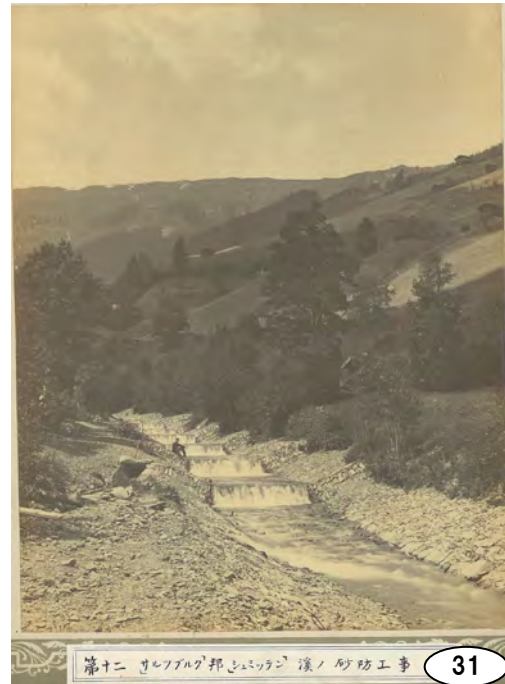
第二十二 サルツブルグ 邦「シュミッテン」溪ノ砂防工事 Schmittenbach 「サルツブルク」邦「シュミッテン」溪の砂防工
