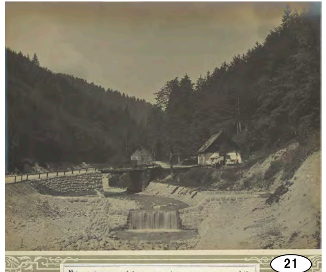
Langbahtbach 上奥州「ラングバード」溪千九百一年ニ 新造セシ「ウェーレルスツープン」橋
