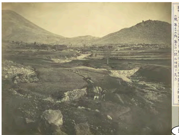
Dalmatien Wildbach "Mahnitas" bei Knin, Mittellauf nach der Verbauung / Thalsperre Nr. 35, 36, 37 und 38 「マーニタス」溪砂防工事竣工 後ノ景
