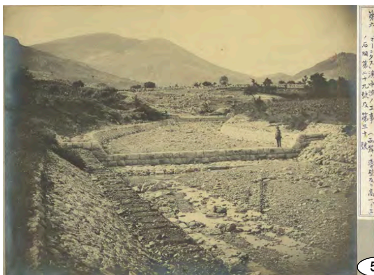
Dalmatien Wildbach "Mahnitas" bei Knin; Correction im Mittellaufe, Beiderseitige Leitwerke und 1.0 m hohe Traversen Nr. 29, 30 im Cementmauerwerk 「マーニタス」溪中流ノ工事
