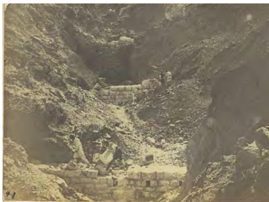
第九 クリマルジ溪モンテネグロ国内ニ於ケル部分ノ砂防工事竣工後ノ景
