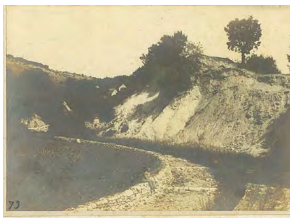
第二十 ベトリ子 7 域ニ於ケル草護岸工
