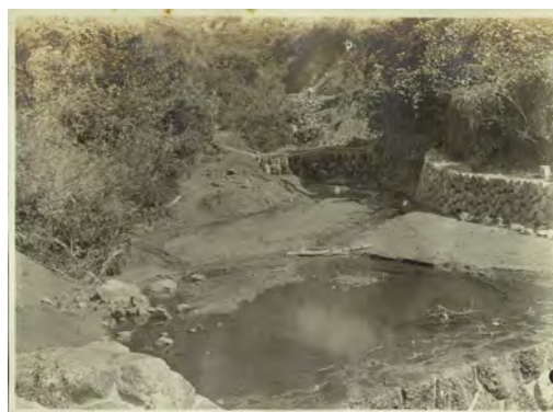
明神峠事業正峯坂澤 第三号堰堤護岸及谷山石積工 大正十五年施行 十五年秋堰
