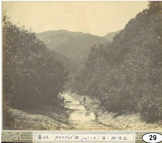
第十七 サルツブルグ 邦「シュミッテン」溪ノ砂防工 Schmittenbach 「サルツブルク」邦「シュミッテン」溪の砂防工
