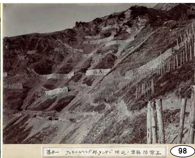
Lawinenverbauung bei Langen, Vorarlberg 「フォアールベルグ」邦「ランゲン」附近ノ雪崩防御工
