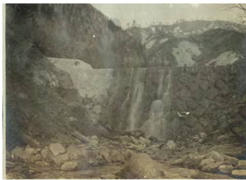
世附事業区 水ノ木沢 第三号 煉積石堰堤、高サ六米、昭和二年
