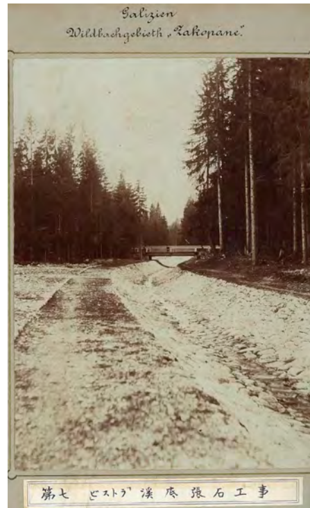
Galizien/ Wildbachgebiet "Zakopane" ガリツェン州・「ビストラ」溪 底張石工事
