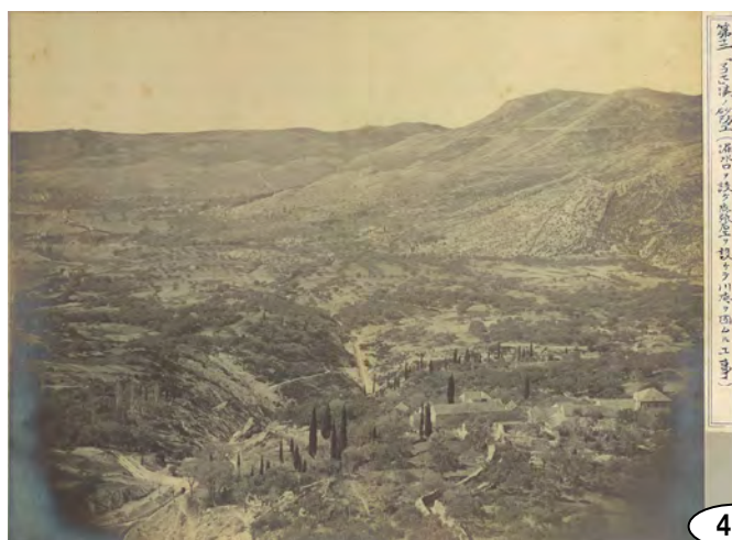
Dalmatien Wildbach "Makose" bei Ragusa / Consolidierung von Bruchterrain durch Sickerschlitzte und Künettenherstellungen 「マコセ」溪ノ砂防工（漏水ロヲ設ケ底張石工ヲ設ケテ河底ヲ固ムル工事）
