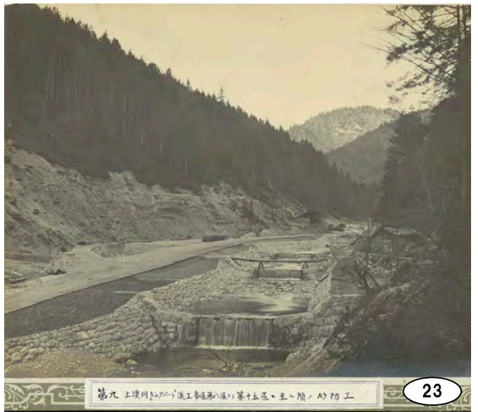
Langbahtbach 上奥州「ラングバード」溪工事区 第八区ヨリ第十五区ニ至ル間ノ砂防工
