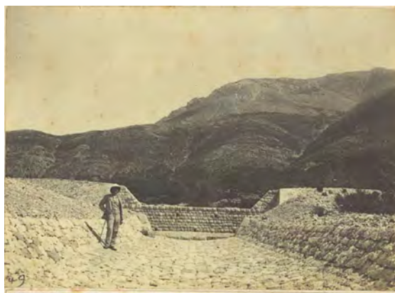
第十一 クリマルジ溪モンテネグロ国内ニ於ケル部分ノ砂防工事竣工後ノ景 (下流ニ於ケル七百五十二メートルノ底層石工)
