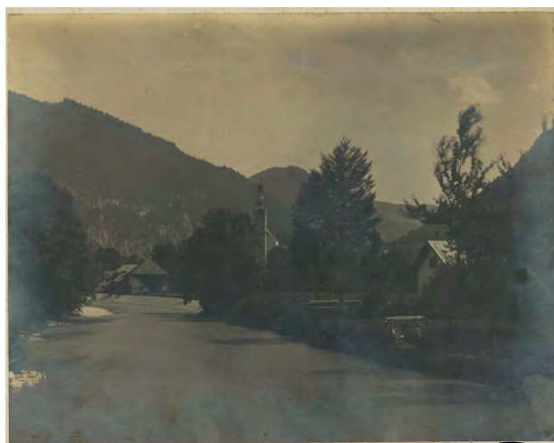
第一 上奥州「グリューネン」附近「アルム」溪ノ治水工事 15 Grünau Almbach 上奥州「グリューネン」附近「アルム」溪ノ治水工事
