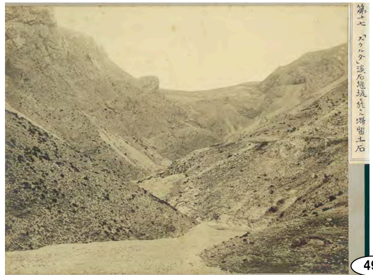
Wildbach "Škurda" in Montenegro / Verlandung der Thalsperre Nr. 1 「シュクルダ」溪石堰堤ニ於ケル滞留土石
