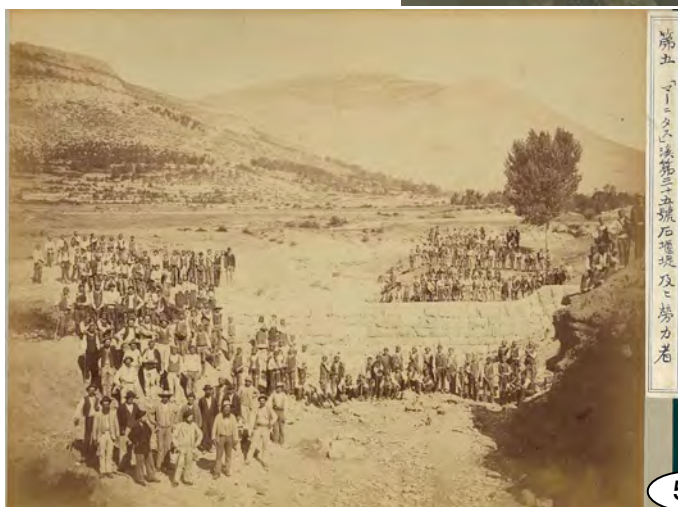
Dalmatien Wildbach "Mahnitas" bei Knin; Thalsperre Nr. 35 und Arbeiterschaft 「マーニタス」溪第三十五号 石堰堤及ヒ勞力者
