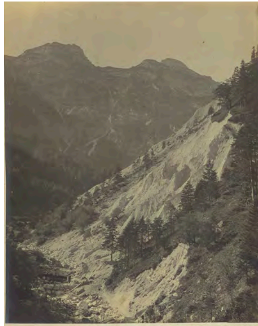
第五 上奥邦 ギム溪第十號石堰堤ノ築設中
