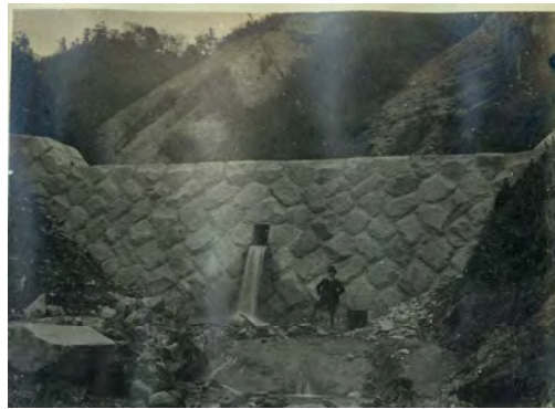
世附事業区 水ノ木沢 第二号 煉積石堰堤、高サ五米、昭和二年
