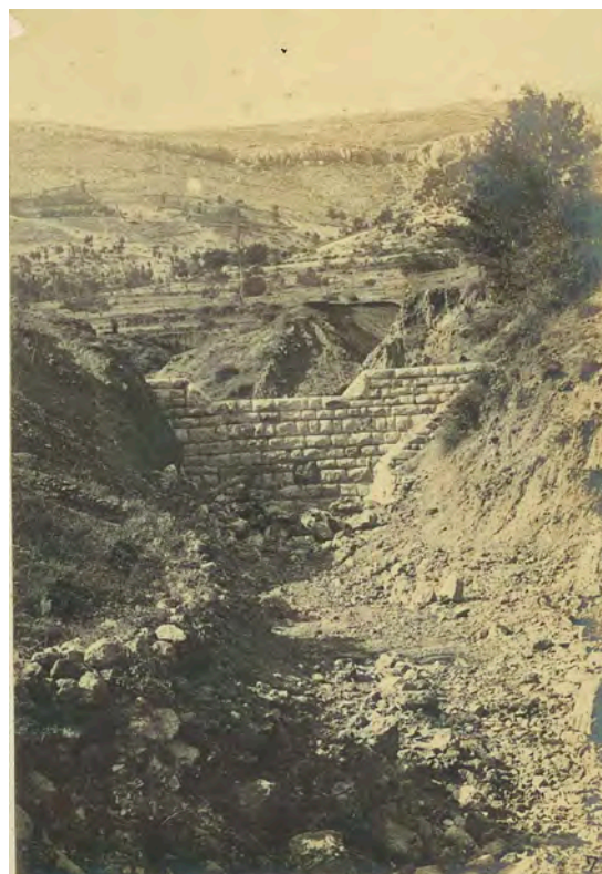
第十八 「マーニタス」溪上流砂防工事竣工後ノ景
