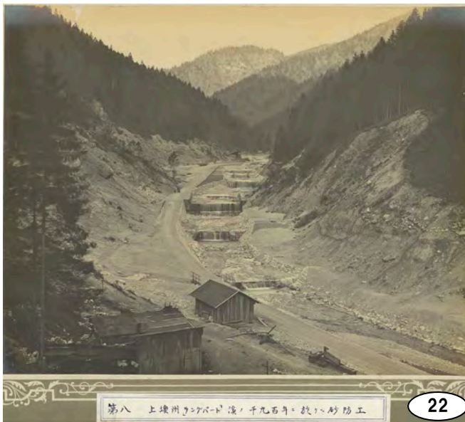
Langbahtbach 上奥州「ラングバード」溪ノ 千九百年ニ於ケル砂防工
