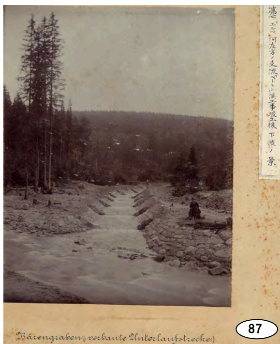
Bärengraben; verbaute Unterlaufstrecke 「エルベ」河左方ノ支流「ベーレン」溪 工事竣工後下流流の景
