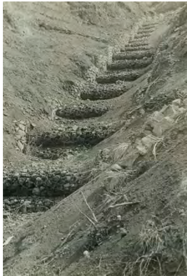
湯河原に於て、谷留土の 上部に鉄線蛇籠工 4.3.30. 内務省工務局
