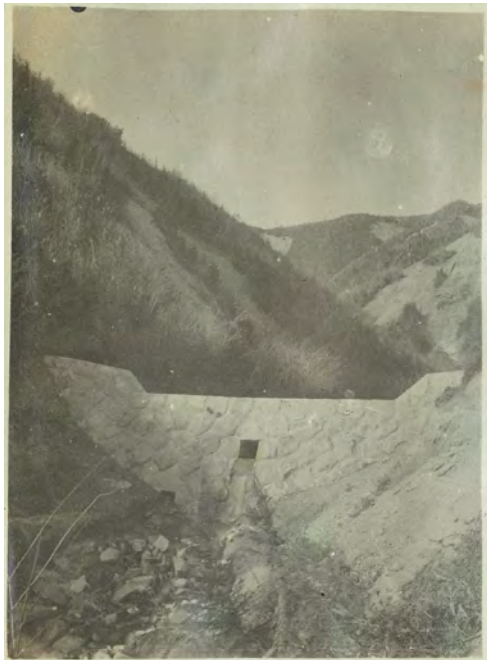
世附事業区 水ノ木沢 第一号 煉積石堰堤、高サ四米、昭和二年
