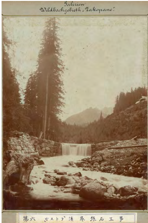
Galizien/ Wildbachgebiet "Zakopane" ガリツェン州・「ビストラ」溪 底張石工事
