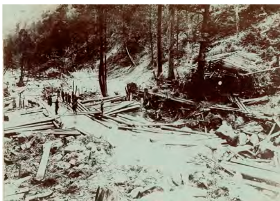
木曾阿寺御料林造材小谷出口及小屋 351
