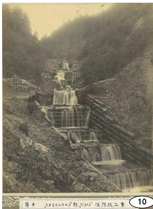
Steiermark, Lichtmezbach 「スタイエルマルク」邦 「リヒトメス」溪階段工事
