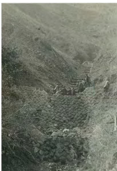
湯河原に於て、谷留土の 上部に鉄線蛇籠を用 いたもの。 4.3.30
