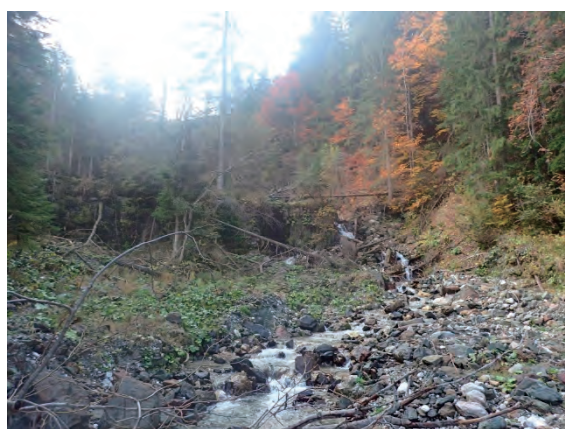
図 3-3-7 堰堤全景（下流から撮影）
