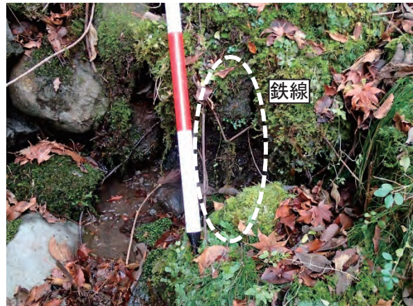
図 2-2-21 左写真の蛇籠の鉄線 (平成 29 年 11 月 30 日撮影)
