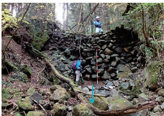
図 2-2-18 支溪堰堤 b-1 (平成 29 年 11 月 30 日撮影)
