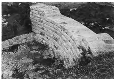
写真一 東京都水道水源林の大正5年施工堰堤（諸戸北郎博士アルバムより）
