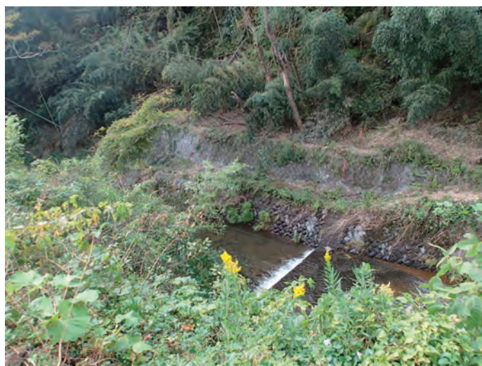
(陥没地と隆起地の間の流路工)
