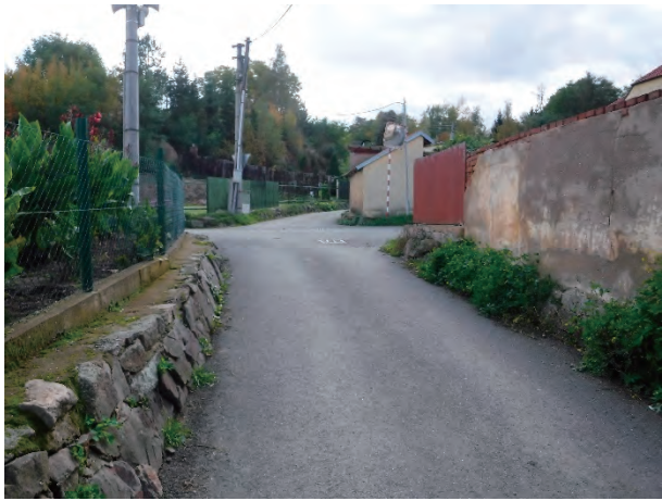
写真⑥ 下流状況
