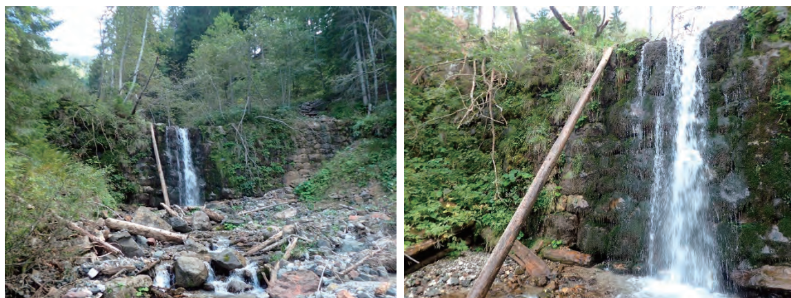
図 3-3-5 アメリゴ・ホフマン関わったルッサーリ溪の堰堤 (左：全景、右：近景)
