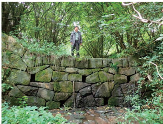
図 3-4-25 石積堰堤の正面（2016 年 9 月）
