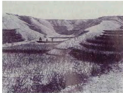
写真一四 チェコ西部（オーストリア帝国時代のパーメン（Böhmen）州）のラコヴニーク（Rakovnik）溪における柳編欄工工事施工後2年目の状況（諸戸北郎博士アルバムより）
