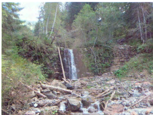
写真-2 ルサーリ溪の砂防堰堤 (2016年9月14日著者撮影) Photo 2 Check dam at Lussari torrent conducted by A. Hofmann (Sep. 14, 2016, taken by author)
