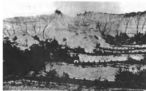
写真-2 1906(明治39)年施工当時のホフマン工事 (愛知県農林水産部, 2005より) 柳編柵工が施工されている様子がわかる
