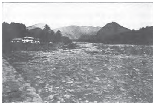
写真-7 大谷川に合流する稲荷川の荒廃状況 (Hofmann, 1936 より) Photo 7 Confluence of Daiya river and Inari torrent, Tochigi pref., Japan (From Hofmann, 1936)
