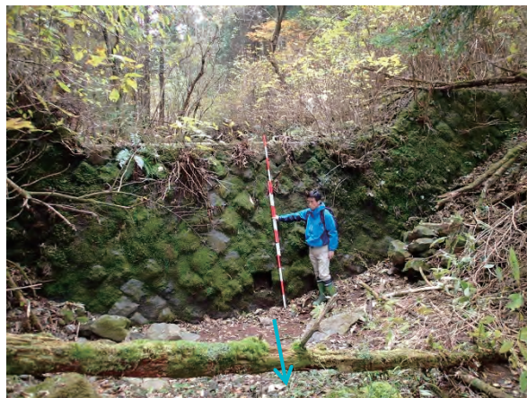
図 2-2-10 堰堤② (平成 29 年 11 月 30 日撮影)
