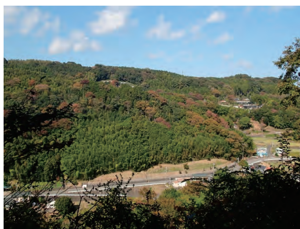
図 2-3-24 地すべり発生地(推定)斜面の現況 (平成 29 年 11 月 14 日撮影)
