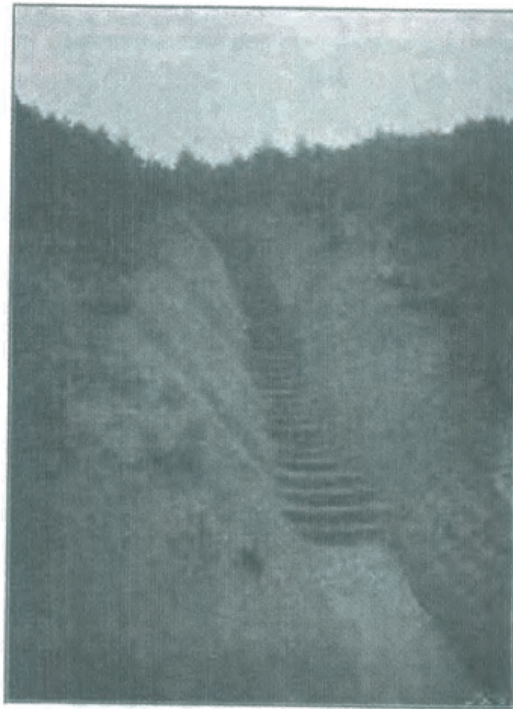
Abbildung Nr. 61. Böschungsversicherung mit Rasenbelag. Sohlenstaffelung mit Flechtwerken. Litavkagebiet, Böhmen.
