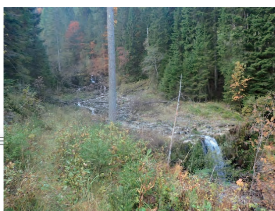
図 3-3-10 堰堤付近全景
