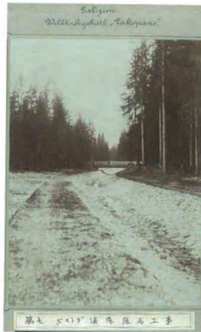
Galizien/ Wildbachgebiet "Zakopane" I 「ビストラ」溪底張石工事
