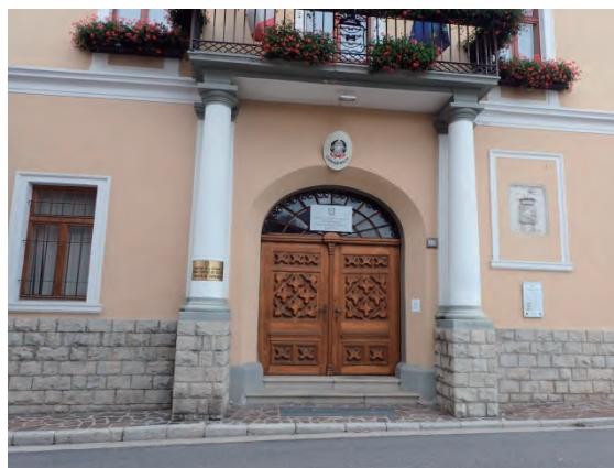
図 3-3-24 事務所正面入口
