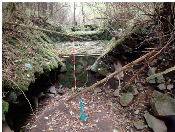
図 2-2-11 堰堤④及び副堰堤 (平成 29 年 11 月 30 日撮影)
