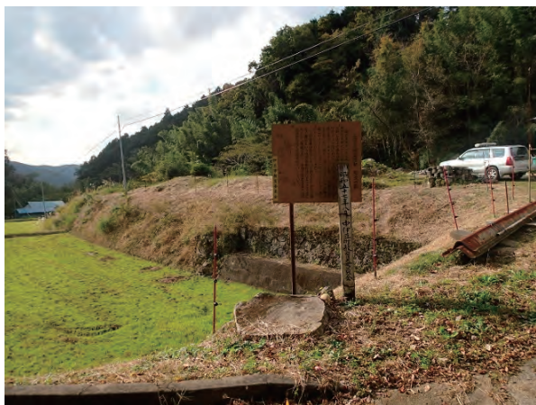
(下流側の隆起地と説明板)
