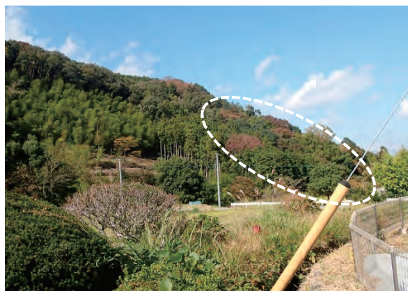
図 2-3-27 山腹崩壊発生地(推定)斜面の現況 (平成29年11月10日撮影)
