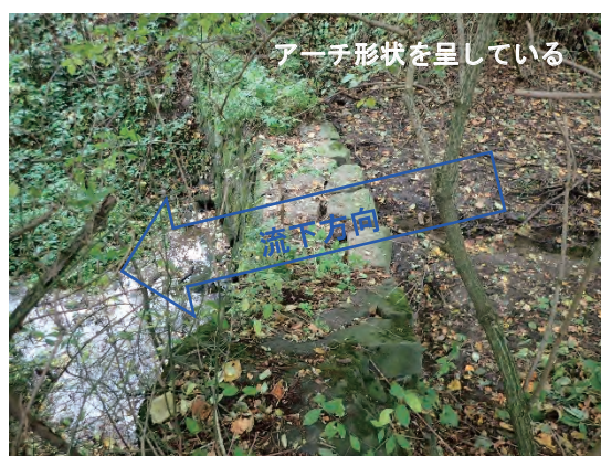
図 3-4-21 堰堤天端状況
