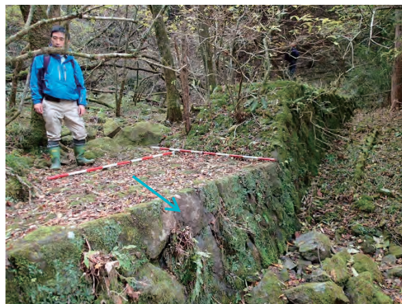
図 2-2-14 左写真の水通し天端 (平成 29 年 11 月 30 日撮影)
