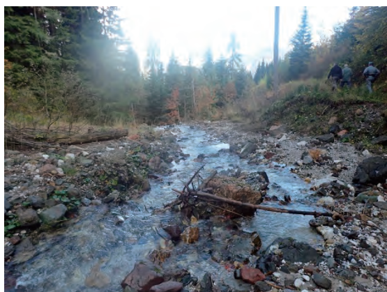
図 3-3-9 堰堤下流部の状況
