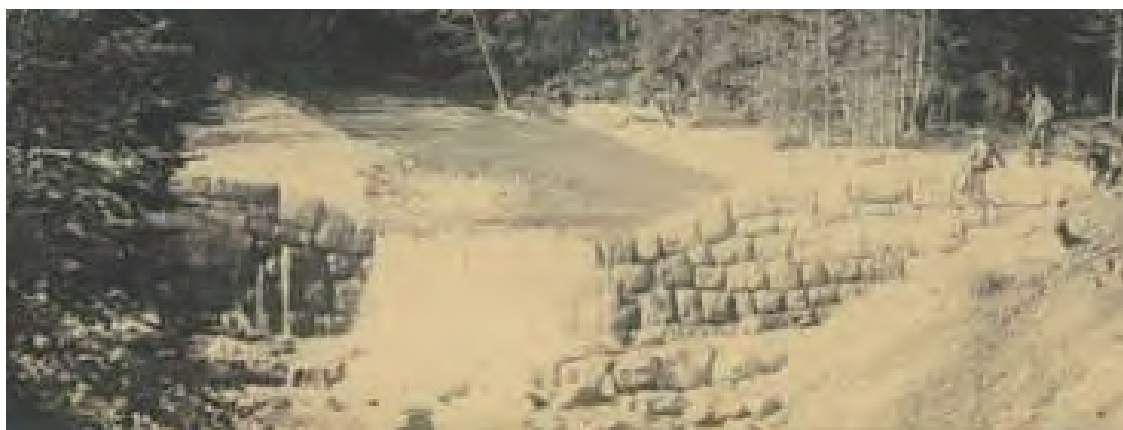
図 3-5-9 1910 年頃施工の現オーストリア・ザルツブルグ州の Gosaubach（ゴザウ溪）の堰堤 （諸戸北郎博士写真アルバムより）
