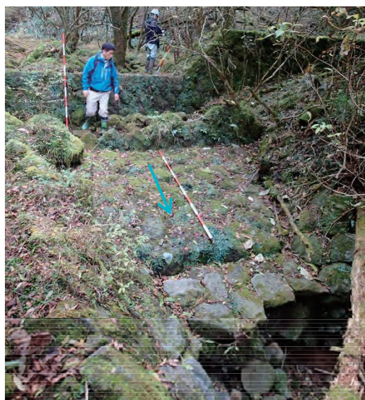
図 2-2-13 堰堤⑥及び副堰堤 (平成 29 年 11 月 30 日撮影)
