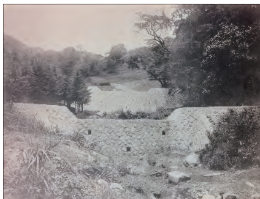
図 2-3-28 混合積堰堤(前方)及び練積堰堤(後方) 度山(1934)口絵写真
