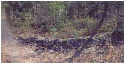
写真一三 萩御殿の石積堰堤（2016年2月24日著者撮影） 土（粘土）を突き固めた堤体の上下流と天端を巻くように割石を張っている。水通部の形状は中央を低くした弧状である
