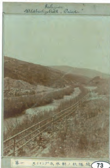
Galizien/ Wildbachgebieth "Dniester" 「セイリング」氏水制ノ杭堰堤
