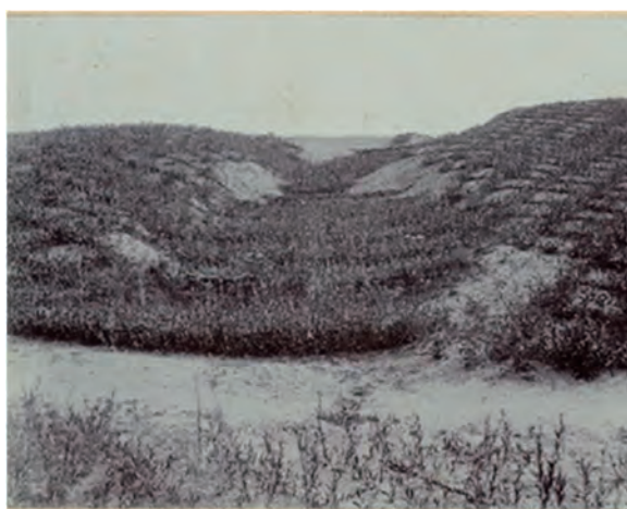
Rechtseitiger Arm der Runse Nr. 1 bei Senomat mit beidseitiger Lehnverflechtung 2. Baujahr 「ラコニツェル」溪域「セノマート」 第一号支溪右方分派三年目の景
