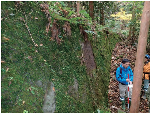
図 2-2-33 堰堤①の左岸袖部と堤銘板位置 (平成 29 年 11 月 30 日撮影)
