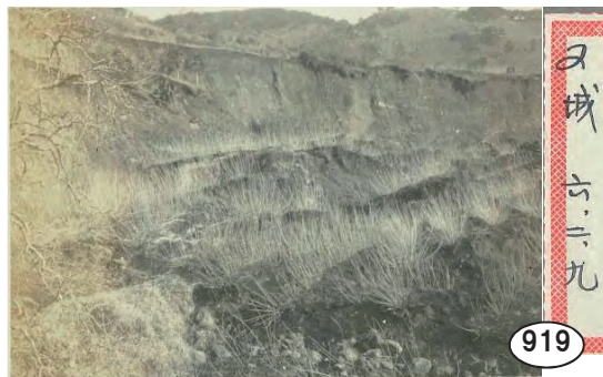
城の陥没地（昭和6年2月9日撮影） [諸戸北郎博士アルバム]
