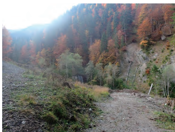
図 3-3-14 堰堤下流周辺状況
