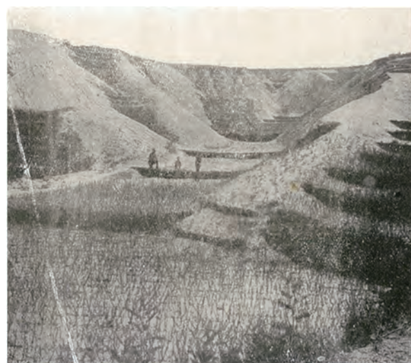
村トーマノセ郡ツニコウ州シメーベ 景ノ日年二後施實工事溪蝕浸
