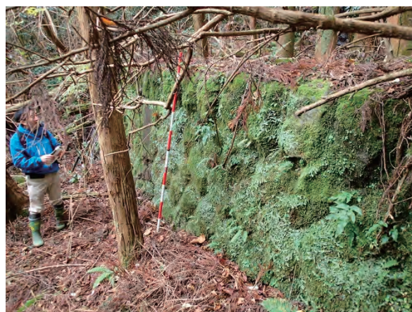
図 2-2-38 堰堤③(平成 29 年 11 月 30 日撮影)
