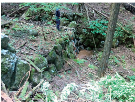
堰堤の下流法
