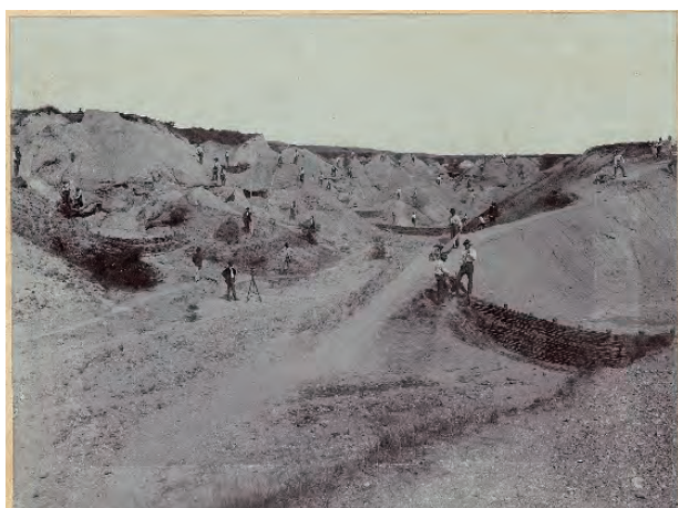
Runse Nr. 1 bei Senomat (Gebiet des Rakonitzer Baches) 1. Baujahr 「ラコニツェル」溪域「セノマート」 第一号支溪工事竣工後一年目の景
