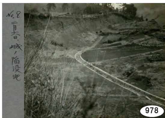
城の復旧工事 (2月6日撮影 撮影年不明) [諸戸北郎博士アルバム]
