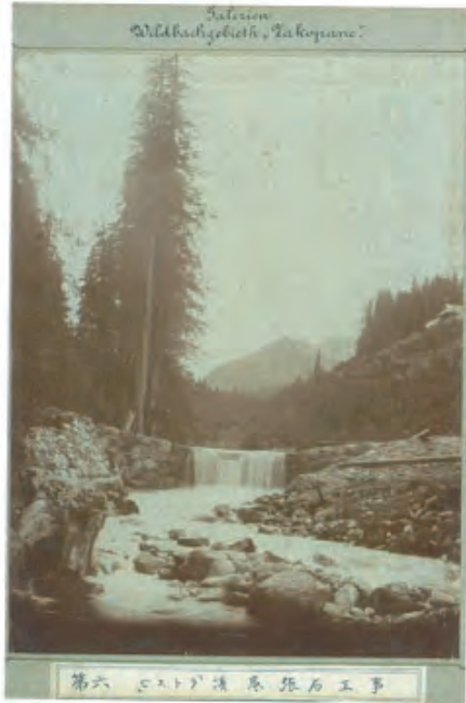
Galizien/ Wildbachgebiet "Zakopane" 「ビストラ」溪底張石工事
