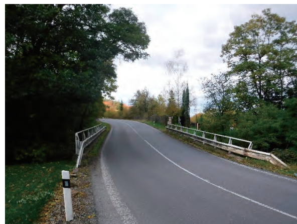
図 3-4-19 石積堰堤直近の道路橋
