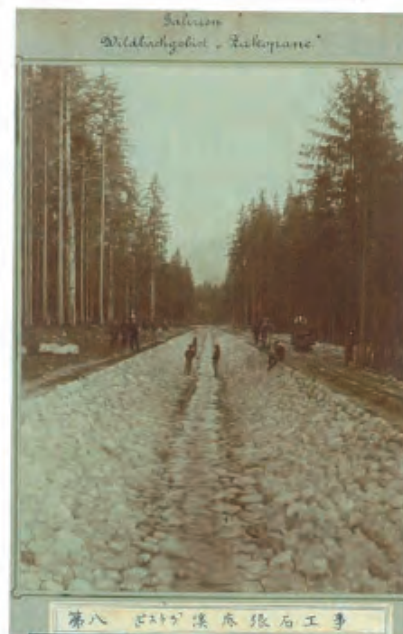
Galizien/ Wildbachgebiet "Zakopane" 「ビストラ」溪底張石工事
