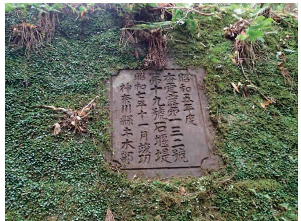
図 2-2-34 堰堤①の堤銘板の文字 (平成 29 年 11 月 30 日撮影)
