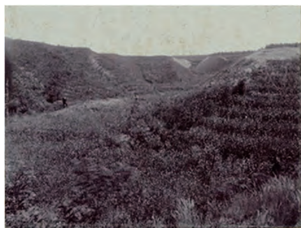
Runse Nr. 1 Bei Senomat 4. Baujahr 「ラコニツェル」溪域「セノマート」 第一号支溪右方分派四年目の景
