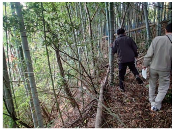
(陥没地上方の竹藪)
