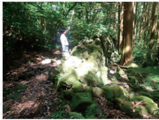
図 2-2-25 集落跡地の擁壁跡
