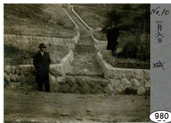
城の復旧工事 (2月6日撮影 撮影年不明) [諸戸北郎博士アルバム]
