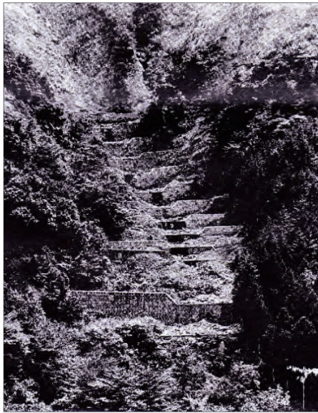
図 2-2-26 直営施工による練積谷止工 (昭和 13~15 年撮影) 神奈川県農政部林務課 (1984) : 神奈川県林政史より
