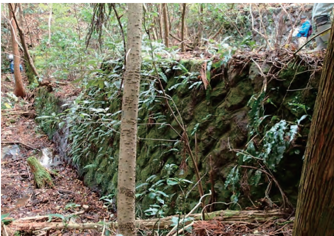
图 2-2-41 堰堤⑥ (平成 29 年 11 月 30 日撮影)
