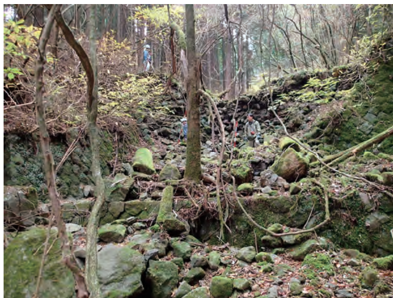
図 2-2-15 堰堤⑨及び副堰堤(平成 29 年 11 月 30 日撮影)
