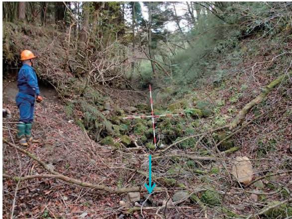
図 2-2-20 蛇籠の堰堤⑮ (平成 29 年 11 月 30 日撮影)
