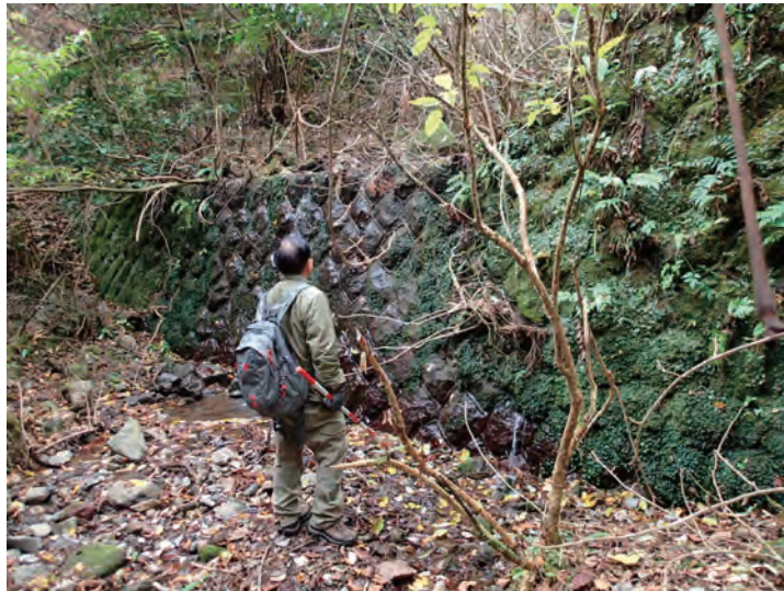
图 2-2-40 堰堤⑤(平成 29 年 11 月 30 日撮影)
