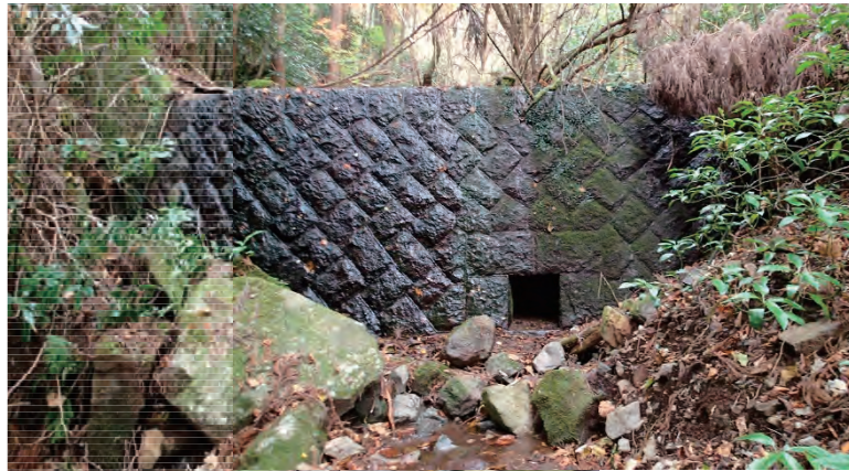
図 2-2-32 堰堤①(平成 29 年 11 月 30 日撮影)
