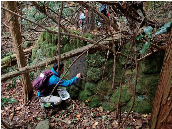
図 2-2-36 堰堤②の左岸袖部と堤銘板位置 (平成 29 年 11 月 30 日撮影)
