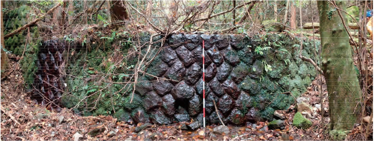
図 2-2-35 堰堤②(平成 29 年 11 月 30 日撮影)
