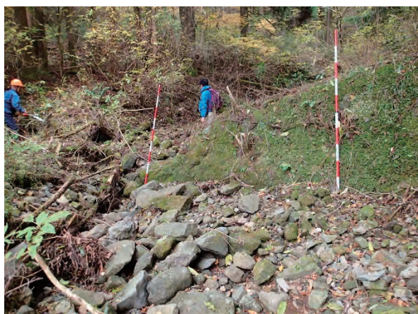
図 2-2-9 堰堤① (平成 29 年 11 月 30 日撮影)
