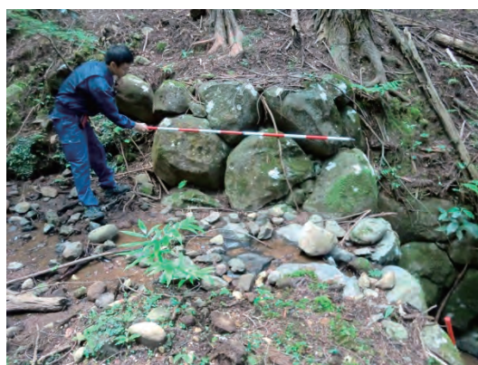
堰堤の左岸袖
