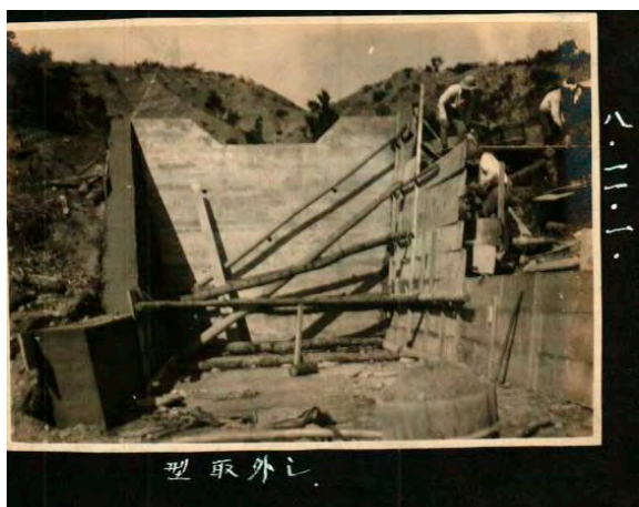
放水路 コンクリート張土堰堤竣工
