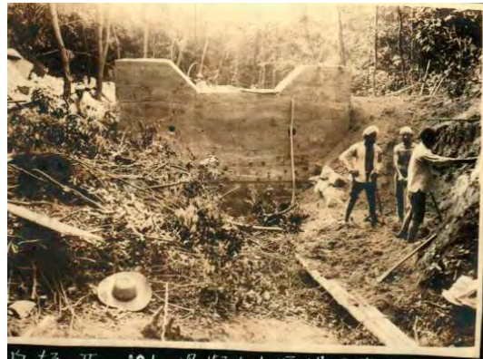
白坂Ⅱ-124 混凝土土堰堤工事中 (上流より観る)
