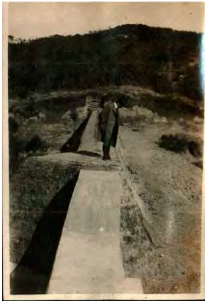
釜ノ洞堰堤 大正十五年十一月十三日
