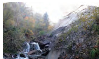
隧道呑口から上流側を望む
