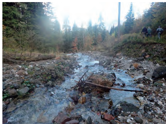
図 3.2-9 堰堤下流部の状況
