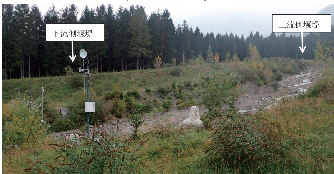
図 4.3-17 センサー設置状況
