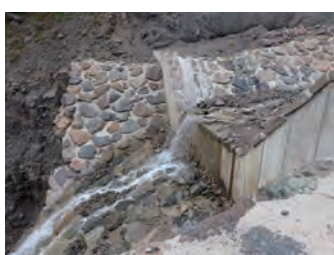
最上流の堰堤 地すべり土塊の脚部固定をしている
