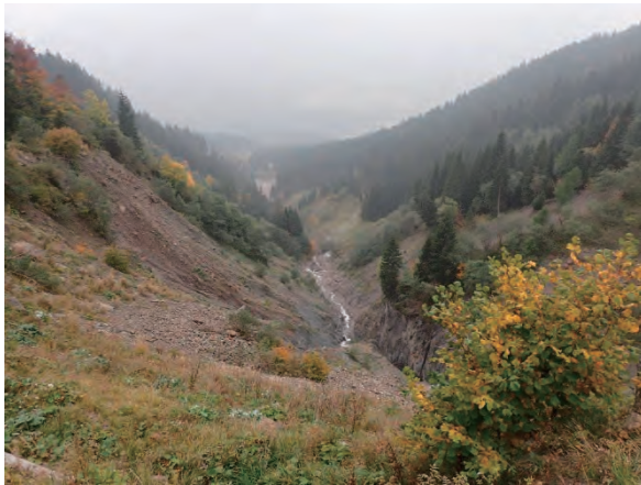
図 4.3-5 堰堤下流方向を臨む
