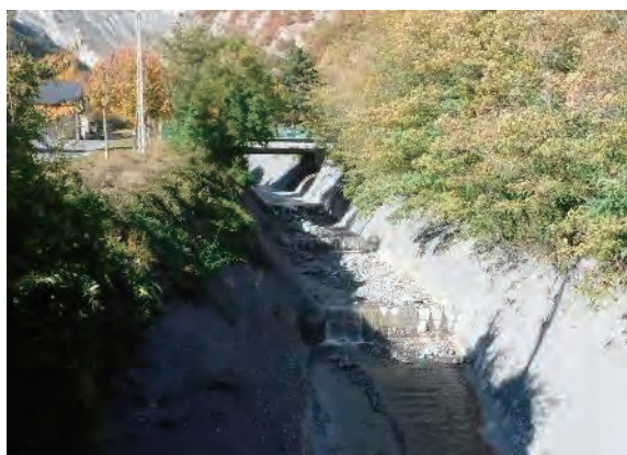
図 7.5-4 流路工に整備された床固工
