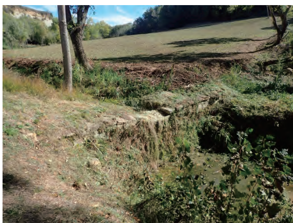
図 5.2-40 溪流分岐箇所の堰堤
