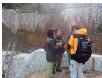
施行中の堰堤 鉄筋を使用している
