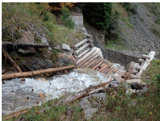
図 4.3-12 木製堰堤の流末
