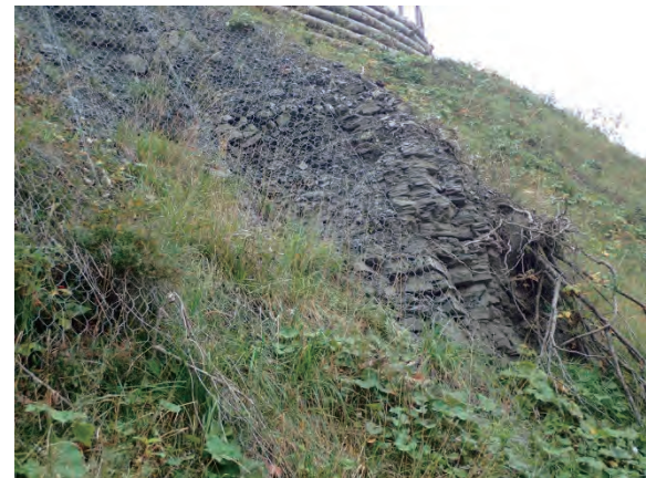
図 4.3-8 破碎された泥岩の露頭
