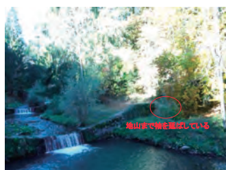
床固工(地山まで貫入されている)
