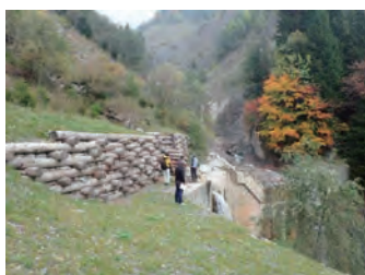
中流の堰堤 支川は木製の堰堤になっている
