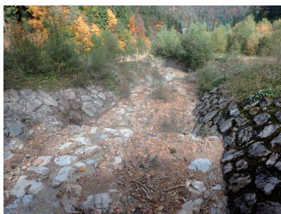
図 3.2-24 下流側の状況
