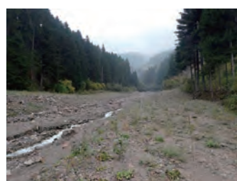
堰堤の上流堆積状況 既に満砂
