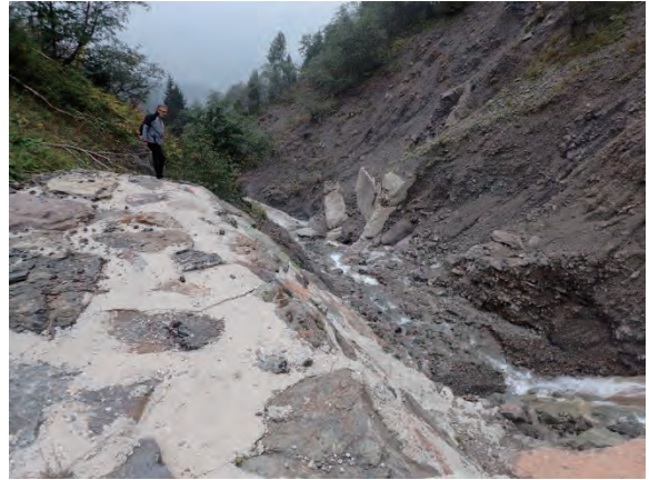
図 4.3-4 堰堤下流方向を臨む
