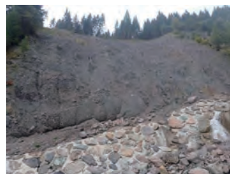
ブロックは破碎された泥岩で 構成されておりアンカーが効かない
