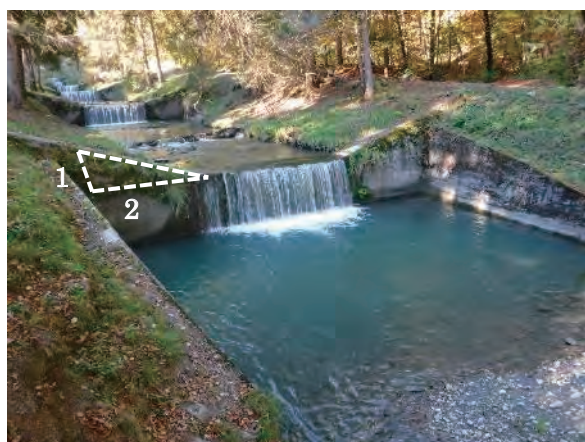
図 7.4-4 下流の床固工（袖小口の勾配 1 : 2）
