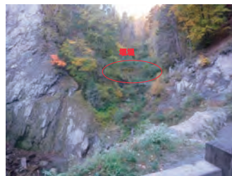
旧流路(19世紀築造の堰堤を確認)
