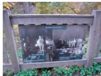
隧道工事の様子
