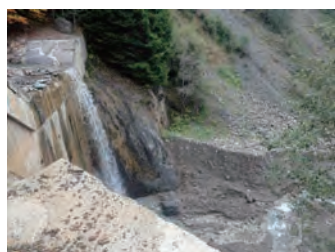
本川の堰堤 地すべりの脚部固定の役割を持つ
