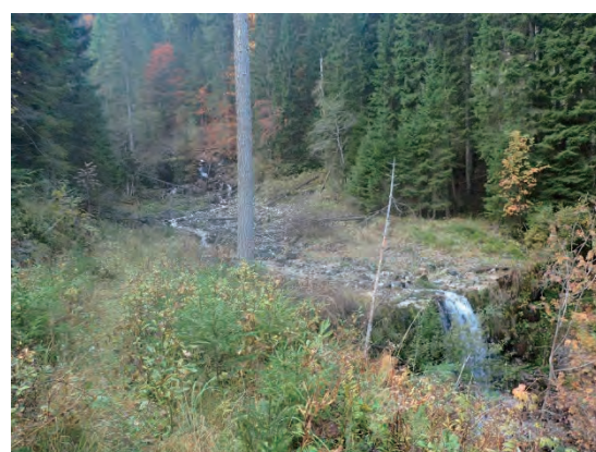
図 3.2-10 堰堤付近全景
