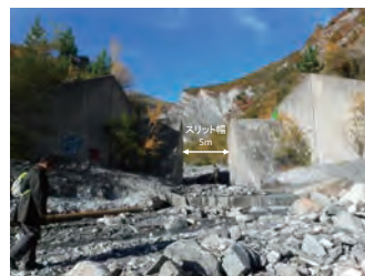
透過型堰堤(スリット幅5m) 下流から撮影
