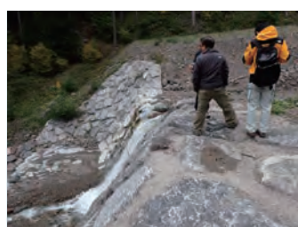
10年前に施工された堰堤 流路が直線区間となっている箇所に 施工され、土石流を減速させる 効果を持つ
