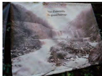
左岸側散策路で確認した説明板 (工事の様子)
