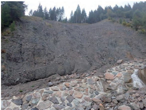
図 4.3-7 地すべり土塊 (岩盤が土砂状になっている)
