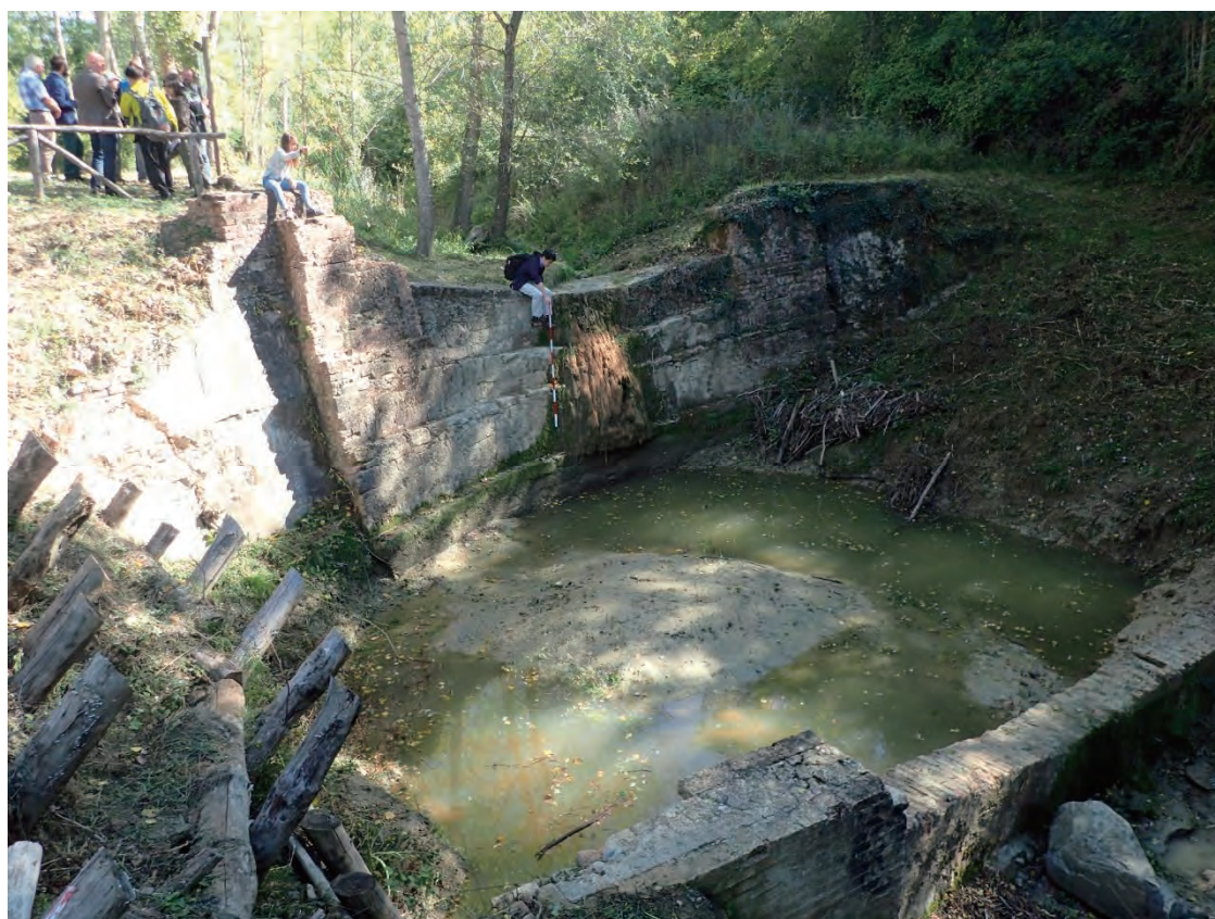
図 5. 2-31 副堰堤が設置されている
