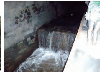
トンネル内の床固工
