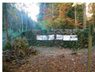
左岸側散策路で確認した説明板 (堰堤袖部に吊られている)
