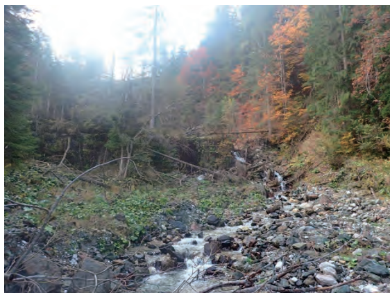
図 3.2-7 堰堤全景（下流から撮影）
