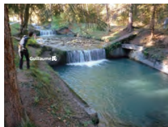
床固工(下流部)
