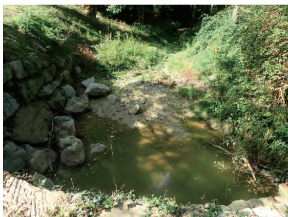
図 5.2-11 下流側の状況
