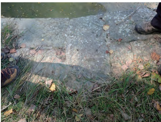
図 5. 2-37 溝がある天端の石 (街の道の敷石を使用)
