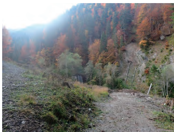
図 3.2-14 堰堤下流周辺状況
