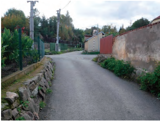
写真⑥ 下流状況
