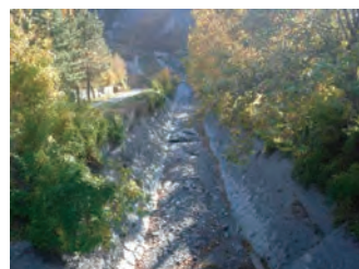
溪流保全工(下流を望む)
