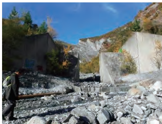
図 7.5-7 透過型堰堤（下流から撮影）
