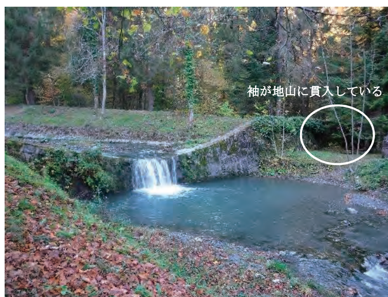
図 7.4-8 袖が地山に貫入した床固工
