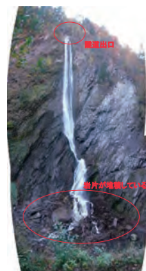
隧道出口全景
