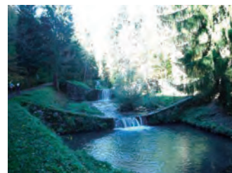
床固工(湾曲部)
