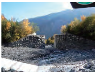
透過型堰堤(スリット幅5m) 上流から撮影
