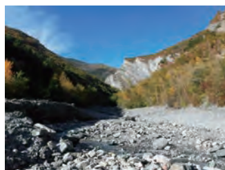
透過型堰堤上流の様子
