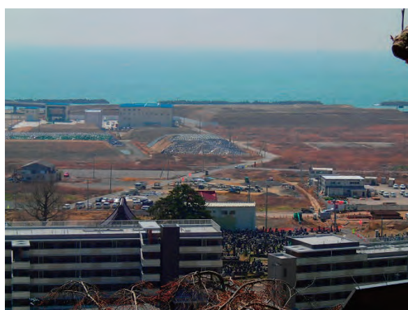
津波被災地と高盛土工事
