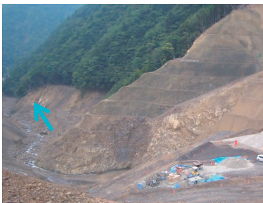
写真 6.10 堰堤右岸袖部貫入予定箇所 (平成 25 年度実践実習報告より)
