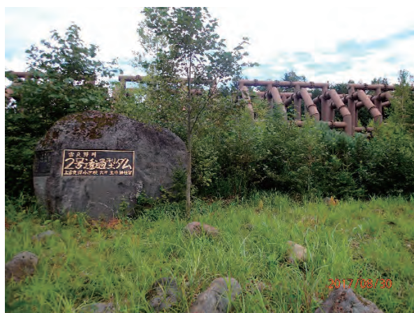
富良野川 2号透過ダム下流面
