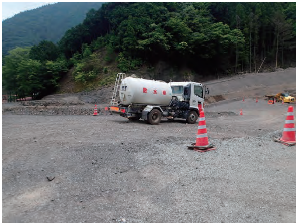
写真 5.32 散水状況
