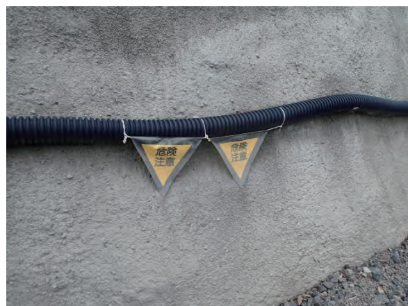
写真 5.24 配管の明示
