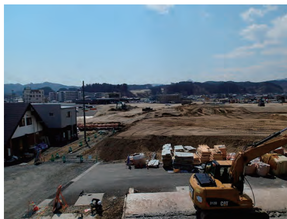
盛土による嵩上げ工事状況
