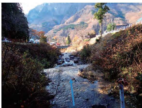
図 2.1.15 小赤沢砂防堰堤群を上流から望む
