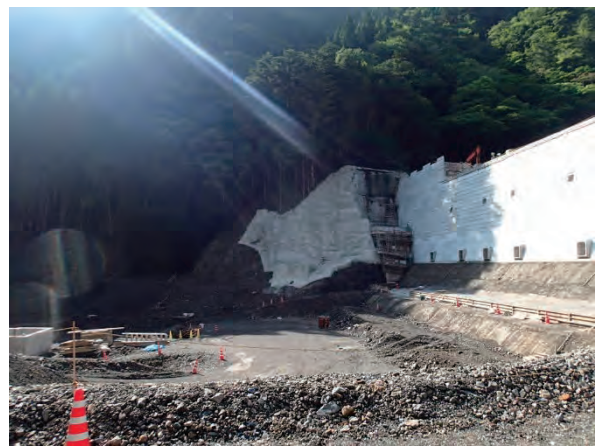
写真 6. 25 右岸袖部モルタル吹付状況 (平成 28 年度実践実習報告より)
