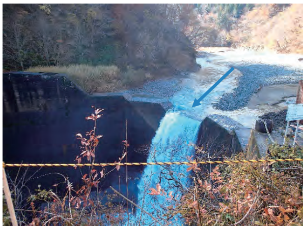
図 2.1.9 上結東砂防堰堤を下流から望む
