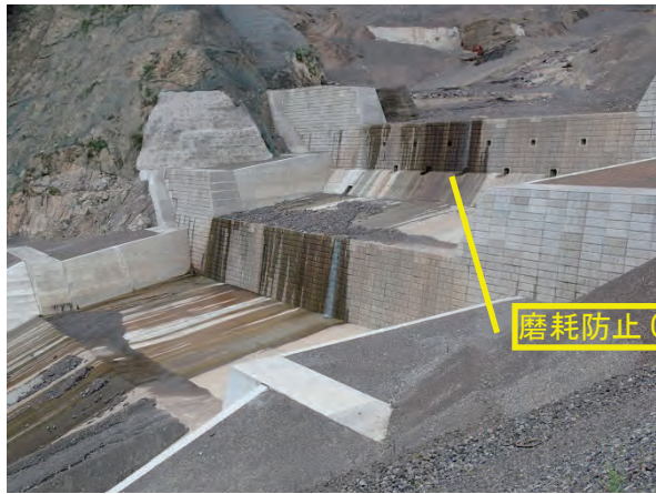
写真 4.1 2号砂防堰堤全景
