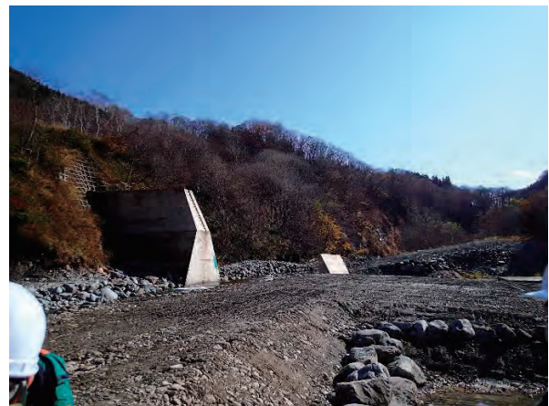
図 2.1.2 中津川上流1号砂防堰堤（右岸側）
