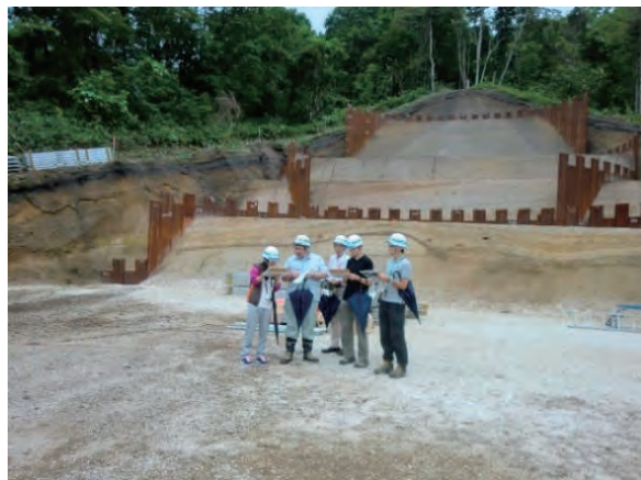
樽前山覚生川 鋼製セル型堰堤 (2013)
