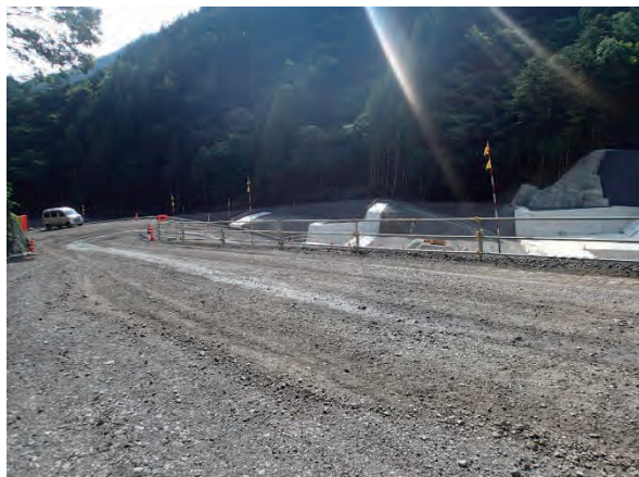
写真 5.15 安全柵の設置
