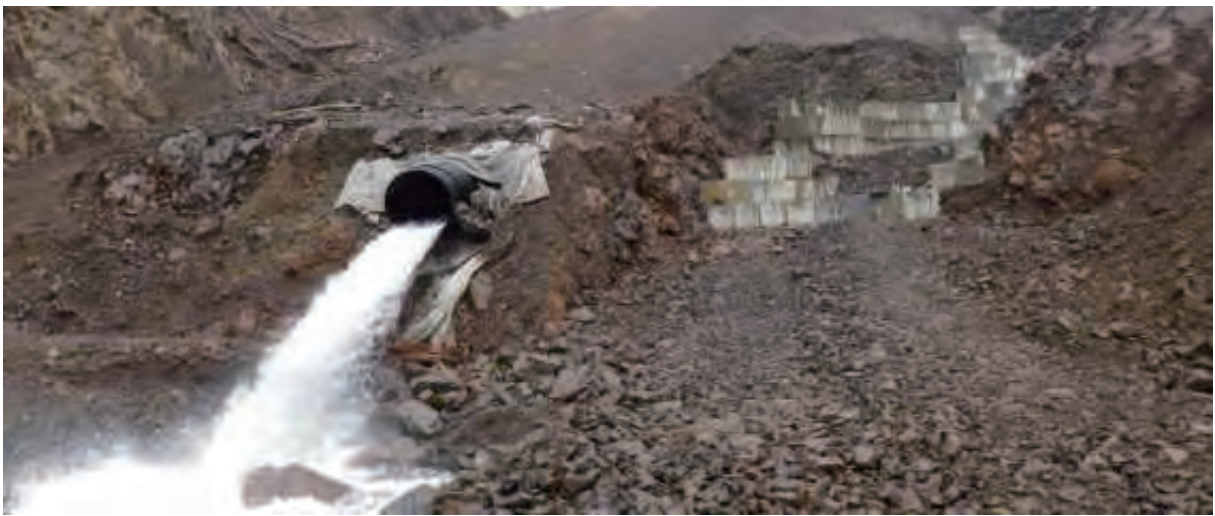
写真 3.4 ダム堤体下流側の暗渠工吐口部(平成 25 年度実践実習報告書より)
