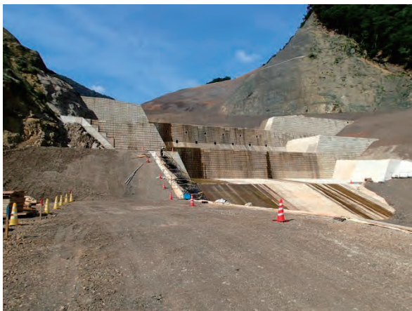
写真 6.20 平成 28 年度実習中 2 堰堤状況 (平成 28 年度実践実習報告より)
