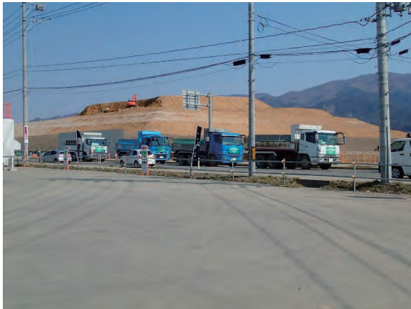
地盤の嵩上げ状況①
