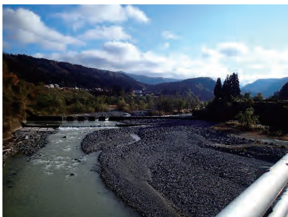
図 2.1.5 中津川第 3 号床固工を下流から望む
