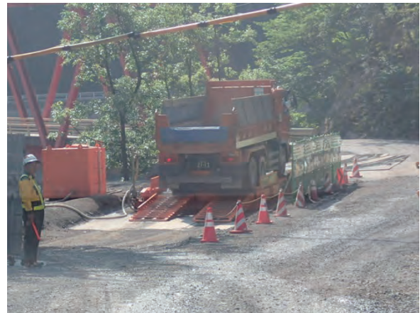
写真 5.33 タイヤ洗浄状況
