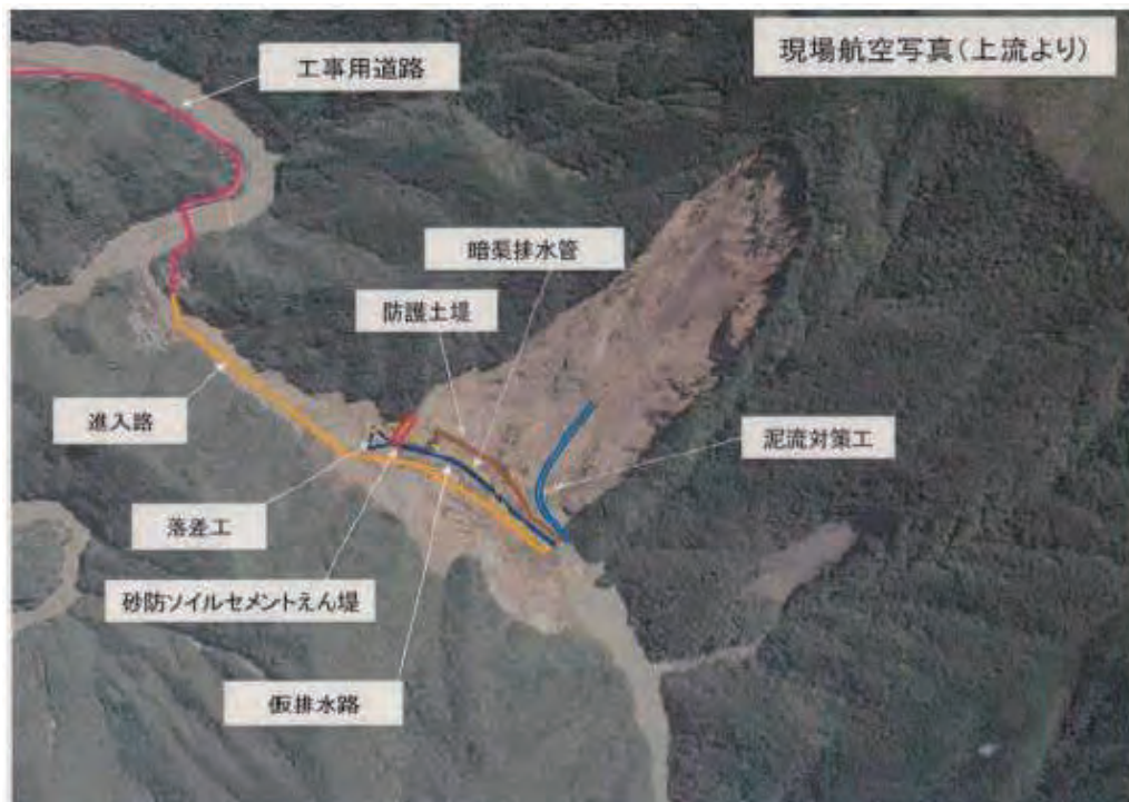
写真 3.1 緊急対策工事計画全景(鹿島建設提供資料より)
