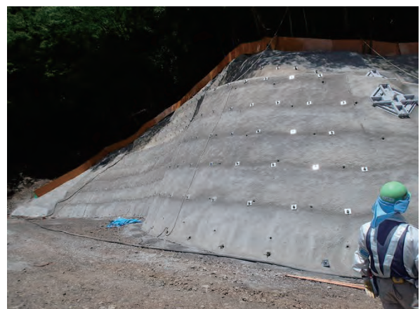
写真 4.17 鉄筋挿入工全景
