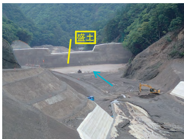
写真 4.8 本堤の背面の盛土
