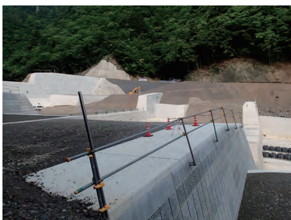
写真 5.17 床固工袖部の安全柵
