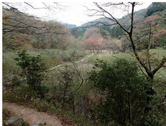
写真 2.2.8 五助堰堤堆砂敷（1）
