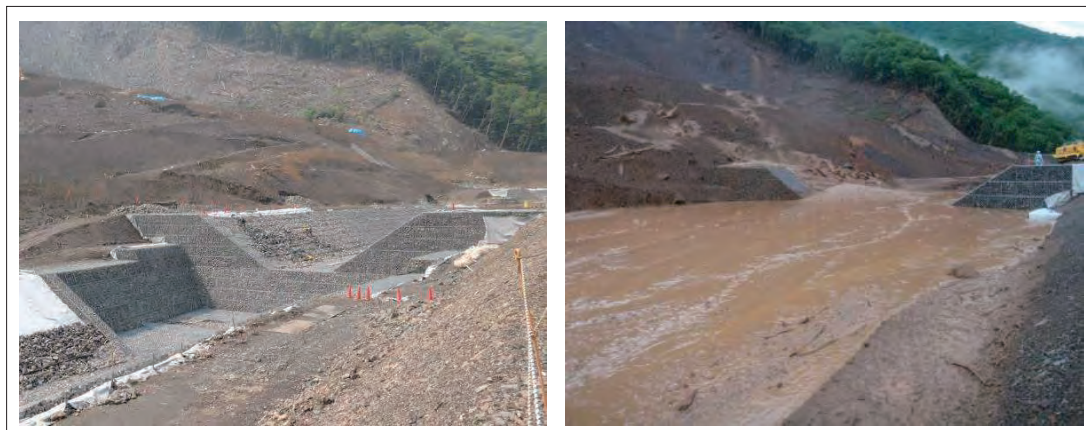
写真 3.8 出水前後状況比較②(鹿島建設提供資料より)
