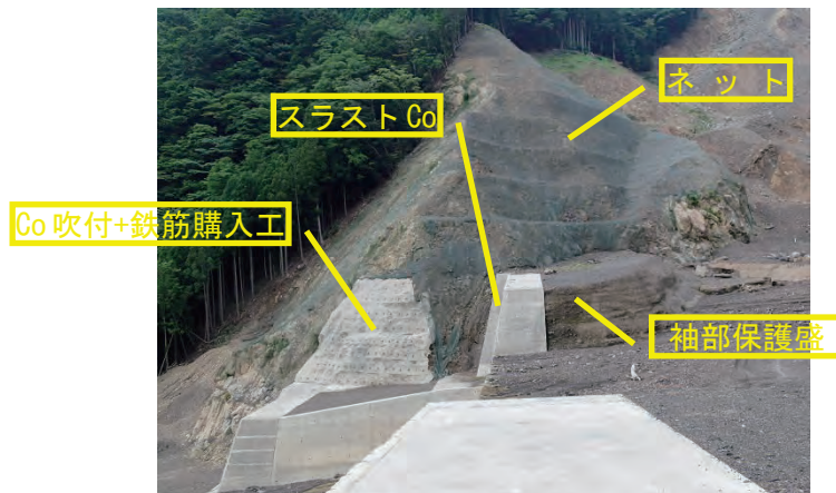
写真 4.3 右岸斜面对策
