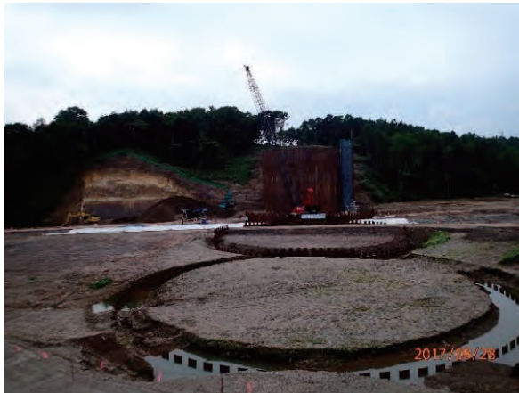
鋼製セル型堰堤施工の様子
