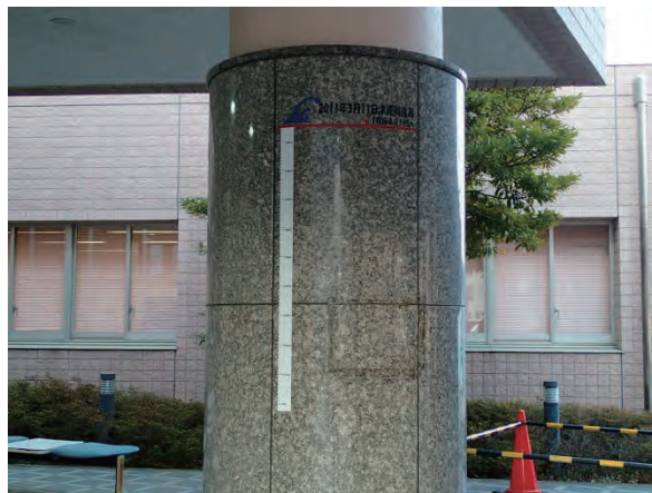
同左の柱の津波到達高さの表示
