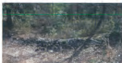
写真-3 萩御殿の石積堰堤(2016年2月24日著者撮影) 土(粘土)を突き固めた堤体の上下流と天端を巻くように割石を張っている。水通部の形状は中央を低くした虹状である
