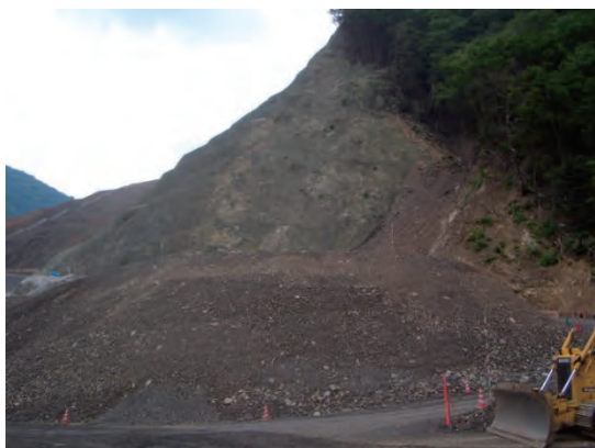
写真 6.9 堰堤左岸袖部貫入予定箇所 (平成 25 年度実践実習報告より)
