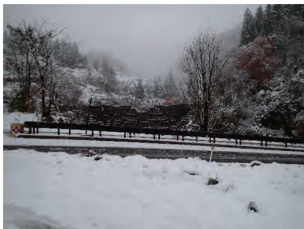
図 2.3.16 東川砂防堰堤を下流から望む
