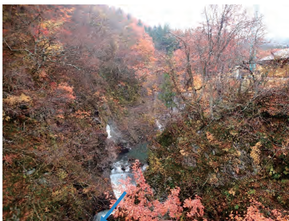
図 2.3.1 大源太川第 1 号砂防堰堤を下流から望む
