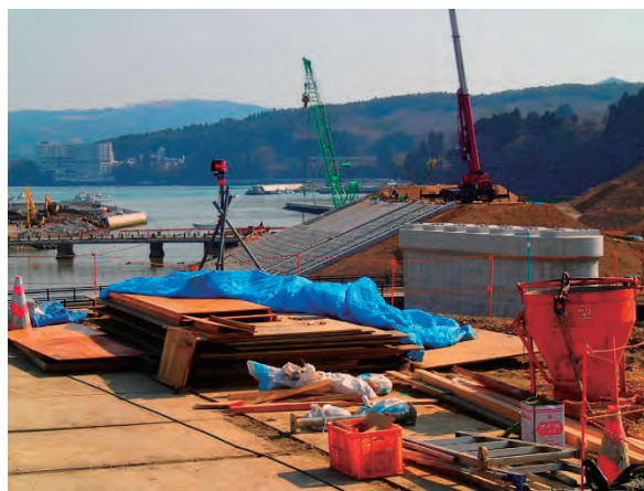
地盤の嵩上げ及び堤防設置状況②
