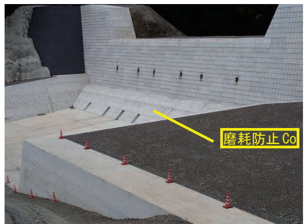
写真 4.5 磨耗防止コンクリート
