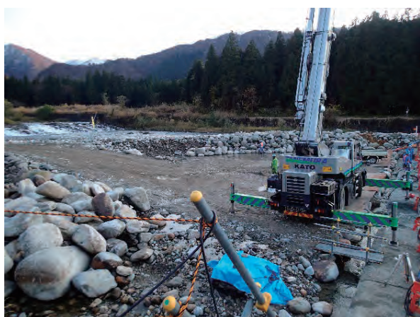
図 2.3.8 現地発生材を利用した仮締切
