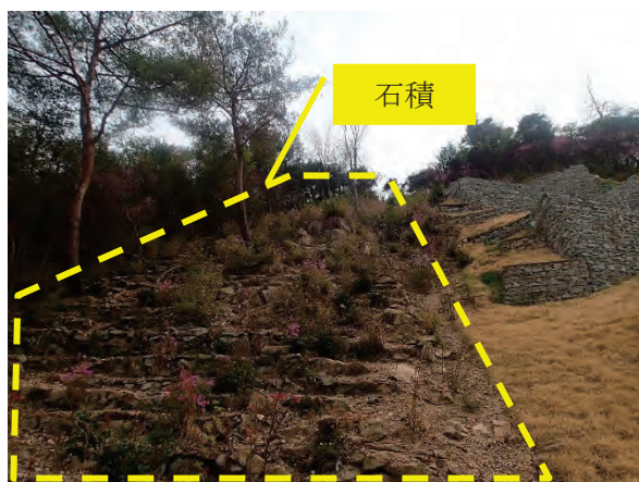
写真 2.2.16 堰堤下流右岸の石積
