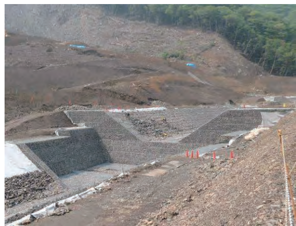
写真 3.5 仮排水路工 (鹿島建設提供資料より)
