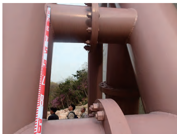
写真 2.2.17 鋼製スリット部
