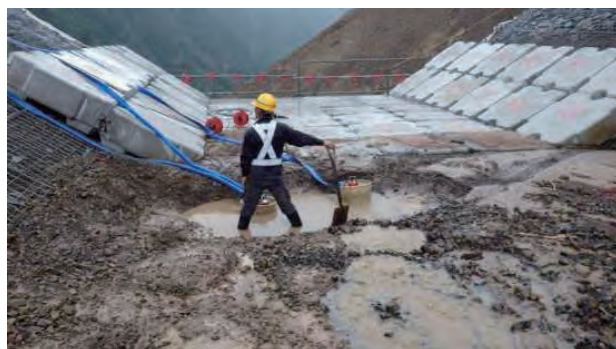
写真 6.1 ポンプによる排水状況 (平成 24 年度実践実習報告より)
