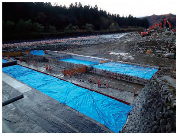
図 2.3.7 水叩き工施工状況
