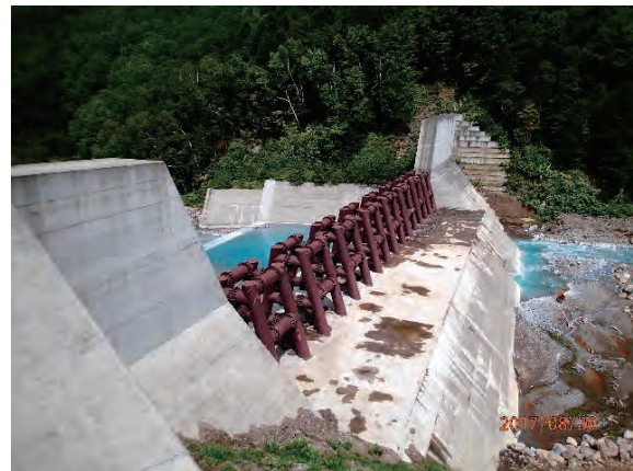
十勝岳美瑛川第 1 号堰堤を左岸から望む
