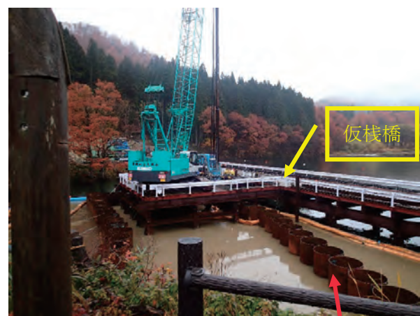
図 2.3.2 仮締切工と仮棧橋
