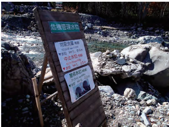
図 2.1.3 施工時の危機管理水位
