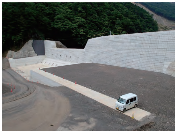
写真 4.4 1号砂防堰堤全景
