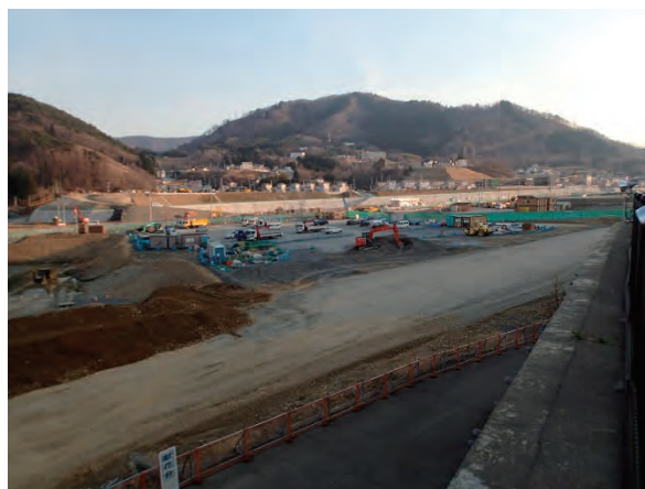
高盛土工事の状況
