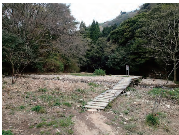
写真 2.2.9 五助堰堤堆砂敷（2）
