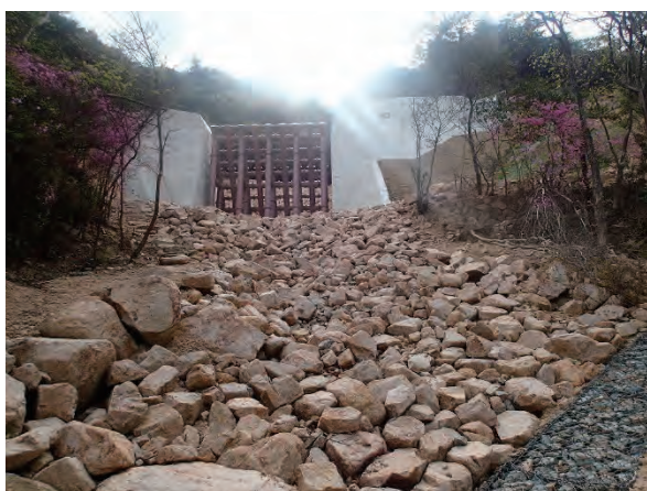
写真 2.2.14 剣谷第四堰堤
