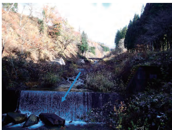
図 2.1.13 赤沢川砂防堰堤群を下流から望む
