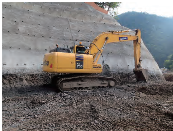
写真 4.12 法面整形状況
