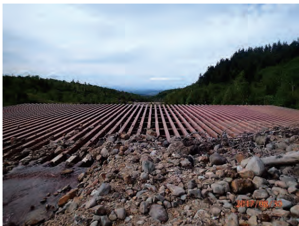
富良野川4号底面スクリーンダム全景
