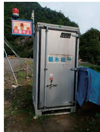
写真 5.13 製氷機の設置
