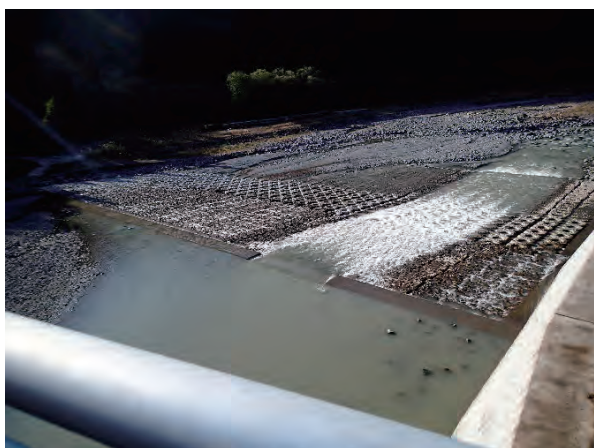
図 2.1.7 復旧された石坂頭首工
