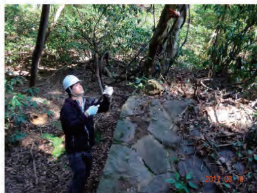
写真2 堰堤の撮影状況
