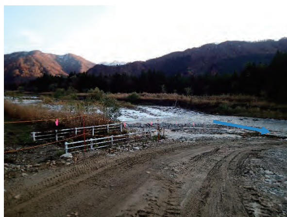
図 2.3.9 上流の全断面魚道
