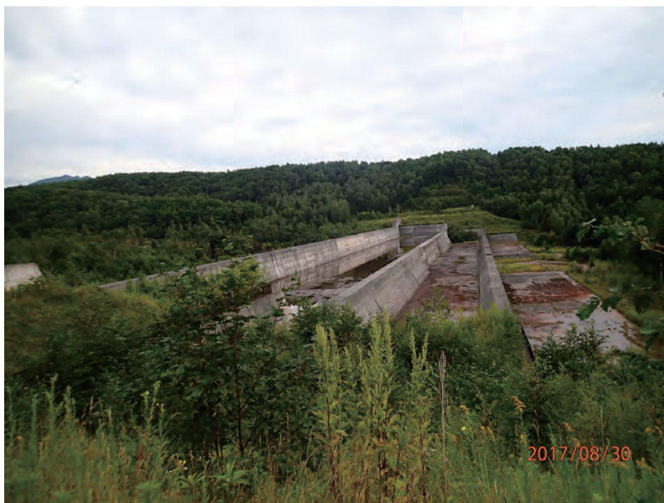
富良野川 3号砂防ダム全景
