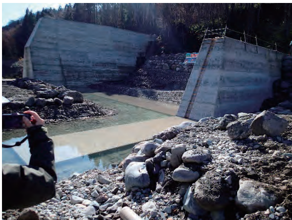
図 2.1.1 中津川上流1号砂防堰堤（左岸側）
