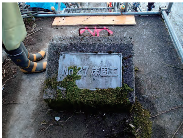
図 2.3.6 No. 27 床固工堤銘板
