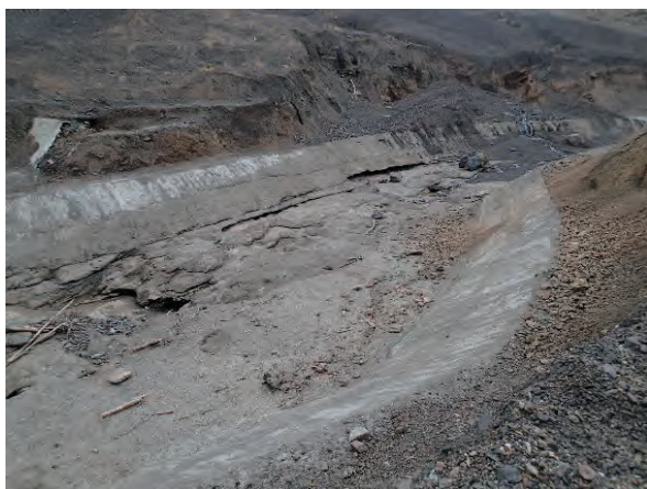
写真 6.15 出水後の仮排水路工全景 (平成 27 年度実践実習報告より)
