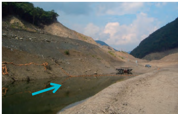
写真 6.8 掘削土砂による盛土(平成 25 年度実践実習報告より)
