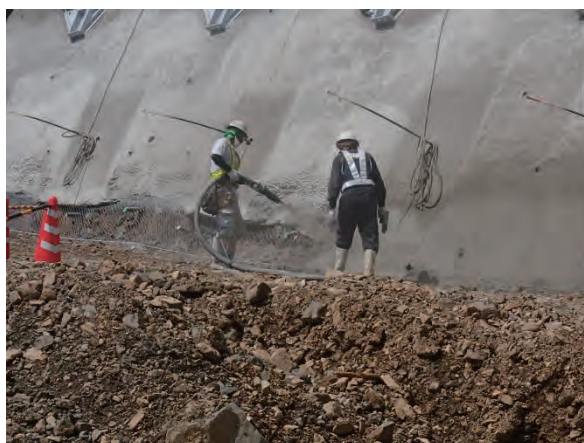
写真 4.13 コンクリート吹付状況
