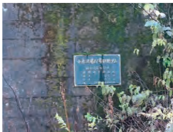
図 2.1.14 小赤沢川第 11 号砂防ダム堤銘板
