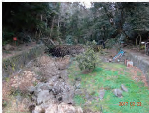
写真3 ①下流側堰堤の全景 (堰堤から約28m下流で撮影)
