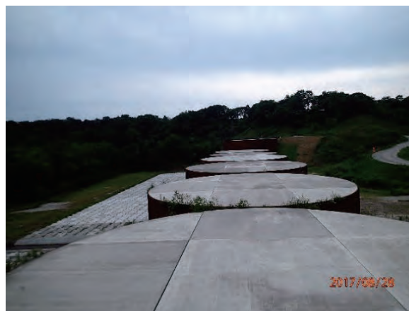
樽前山覚生川 鋼製セル型堰堤 (2017)
