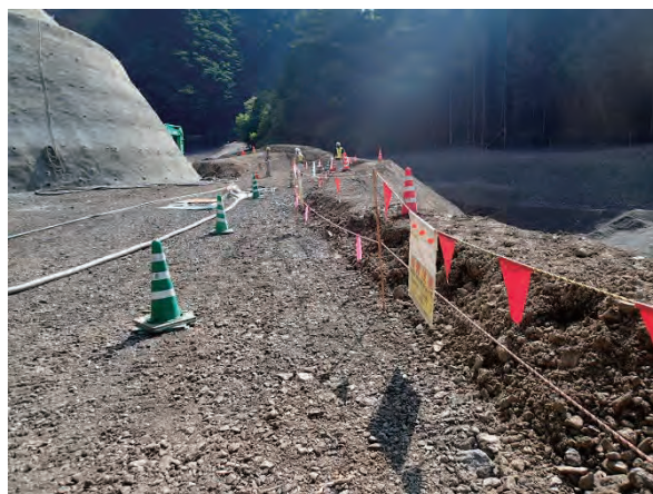
写真 5.25 車道と歩道の区分状況
