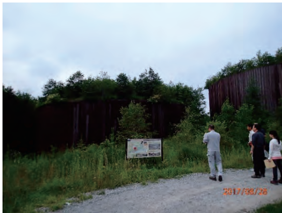
鋼製セル型堰堤
