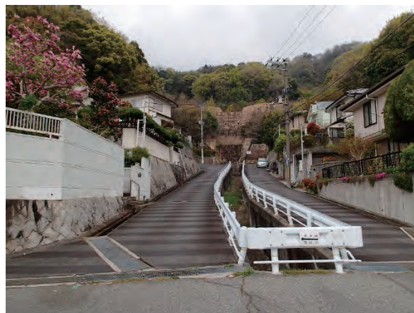
写真 2.2.6 焼ヶ原堰堤と保全対象
