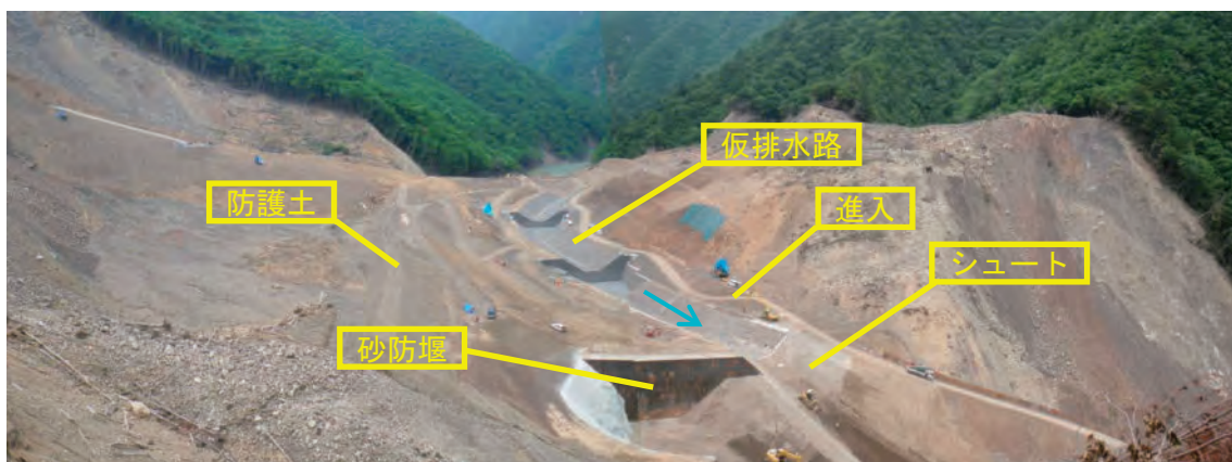
写真 3.2 緊急対策工事全景(鹿島建設提供資料に加筆)
