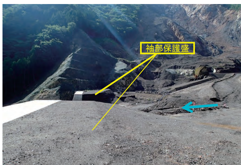
写真 6.14 袖部保護盛土状況(平成 28 年実践実習報告より)
