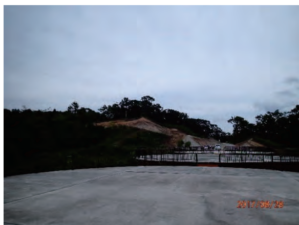
樽前山覚生川 鋼製セル型堰堤 (2017)
