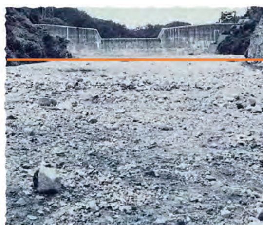
災害後（12万 \text{m}^3 の土石流を貯留）
