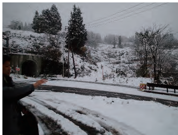
図 2.3.17 東川砂防堰堤下流の県道
