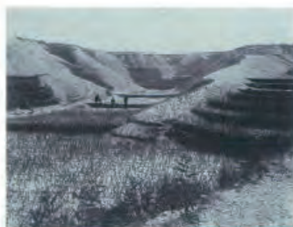
写真-4 チェコ西部(オーストリア帝国時代のベーメン(Böhmen)州)のラコヴニーク(Rakovník)溪における柳編欄工事施工後2年目の状況(諸戸北郎博士アルバムより)
