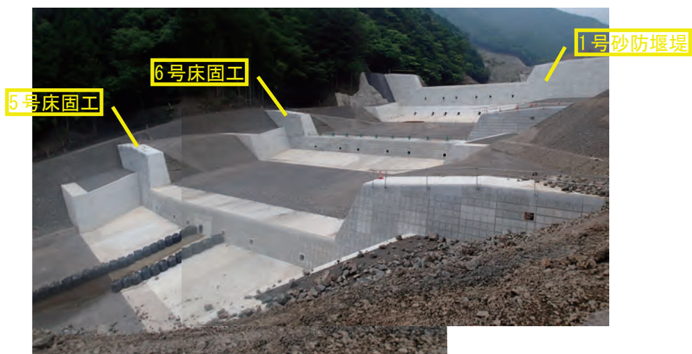
写真 4.9 5号床固工及び6号床固工全景
