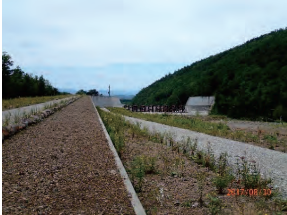
十勝岳美瑛川第 1 号堰堤 (2013)
