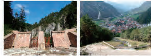
写真3 ウッカ溪(C)の透過型堰堤と保全対象となる扇状地
