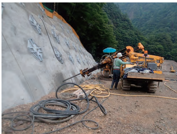
写真 4.15 鋼材挿入状況
