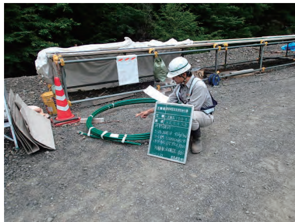
写真 5.35 アンカー工鋼材材料検査状況
