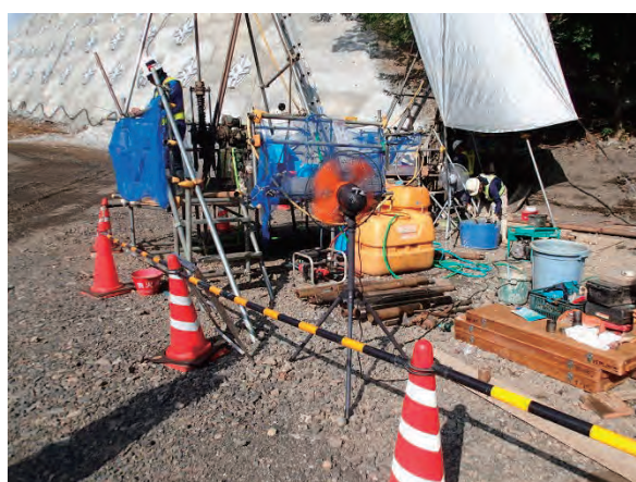
写真 5.12 扇風機の設置
