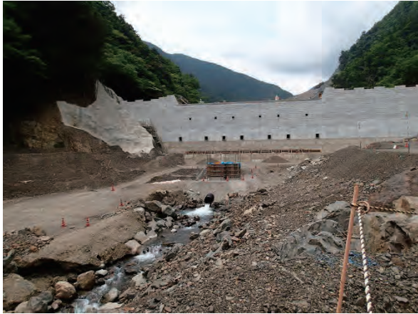
写真 6. 22 1号堰堤全景 (平成 28 年度実践実習報告より)
