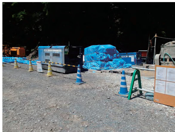
写真 5.26 作業スペースの出入り口
