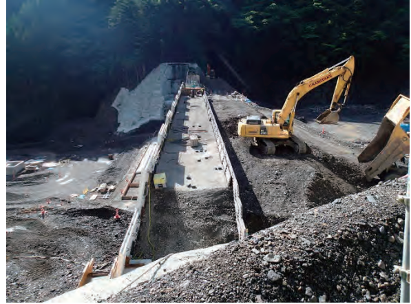
写真 6. 23 本堤施工状況 (平成 28 年度実践実習報告より)
