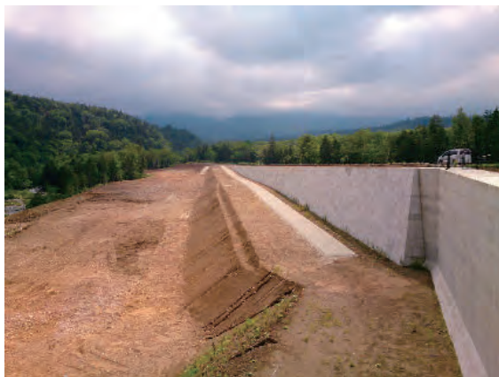
十勝岳美瑛川 INSEM 工法による袖部 (2015)
