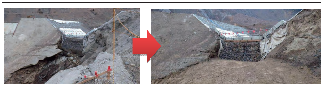
写真 6.3 シュート工復旧状況(平成 24 年度実践実習報告より)
