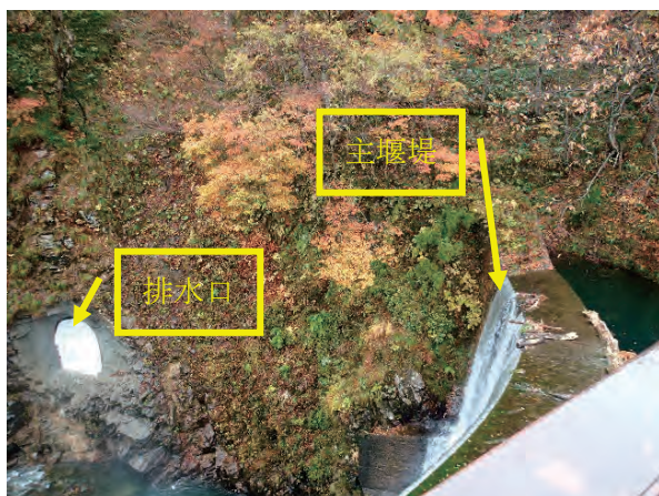
図 2.3.3 主堰堤と仮排水トンネル排水口
