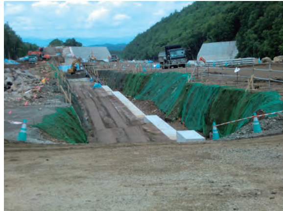
十勝岳美瑛川第 1 号堰堤 (2017)
