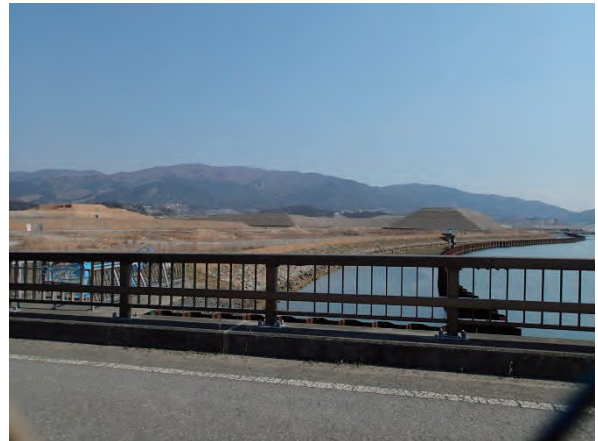
地盤の嵩上げ状況②
