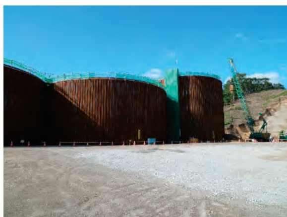
樽前山覚生川 鋼製セル型堰堤 (2014)
