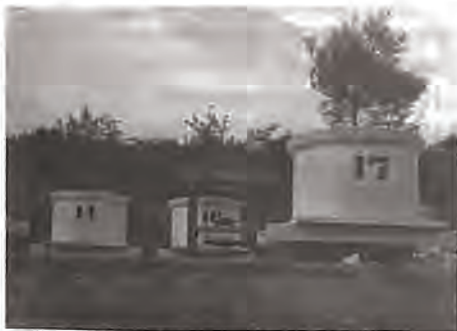
写真-2 穴の宮試験地の浸透試験装置 （東京大学生態水文学研究所蔵） Photo 2 Equipment measuring infiltration at Ananomiya experimental site （Owned by the University of Tokyo）
