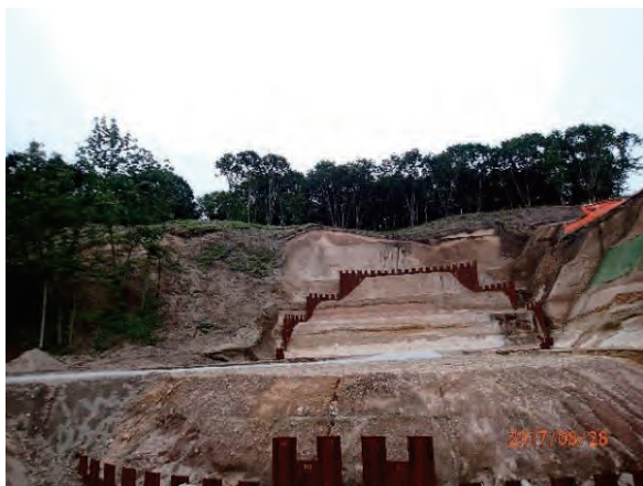
鋼製セル型堰堤施工の様子
