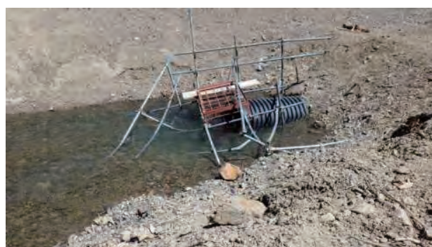
写真 6.5 暗渠工呑み口の保護 (平成 24 年度実践実習報告より)
