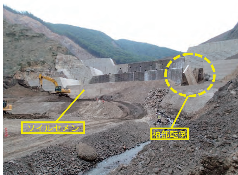
写真 6.19 2 号砂防堰堤復旧状況 (平成 27 年実践実習報告より)
