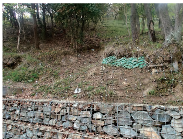
写真 2.2.13 ノンフレーム工法 (2)
