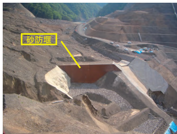
写真 3.6 仮排水路工全景 (平成 25 年度実践実習報告書に加筆)
