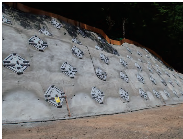
写真 4.14 アンカー工全景
