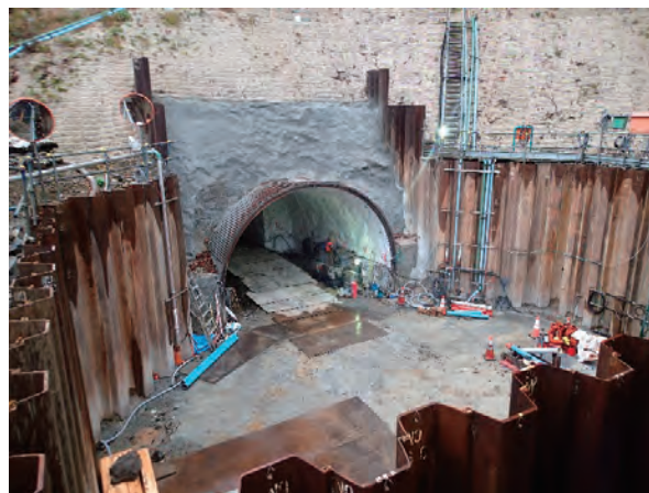
図 2.3.4 仮排水トンネル呑口
