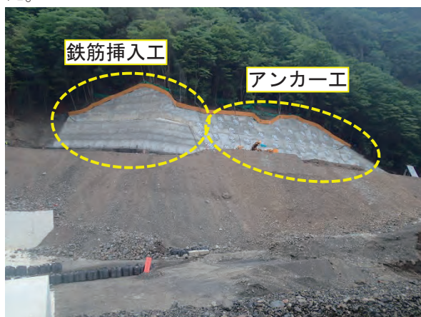
写真 4.11 アンカー工及び鉄筋挿入工全景
