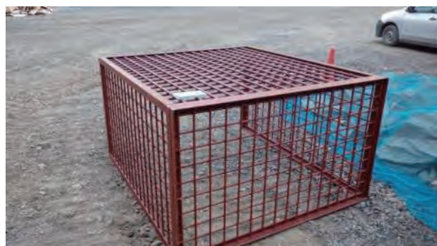
写真 6.4 流木進入防止用の鋼製の籠 (平成 24 年度実践実習報告より)
