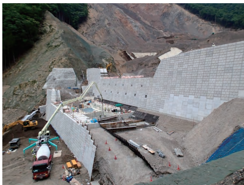
写真 6.12 2 号堰堤施工状況 (平成 26 年実践実習報告より)
