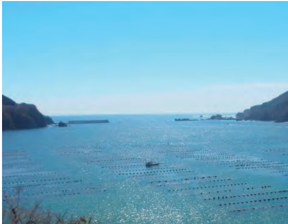
平成 28 年時の防波堤の状況
