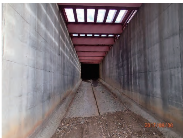
富良野川4号底面スクリーンダム内部
