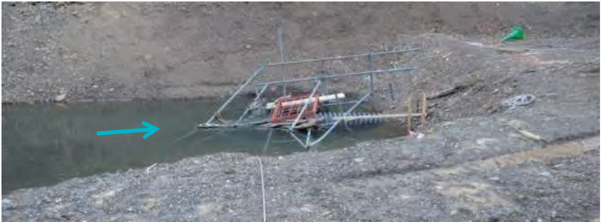
写真 3.3 ダム堤体上流側の暗渠工呑口部(平成 24 年度実践実習報告書に加筆)
