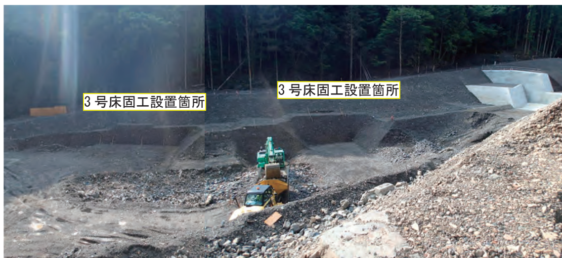
写真 4.10 床掘状況
