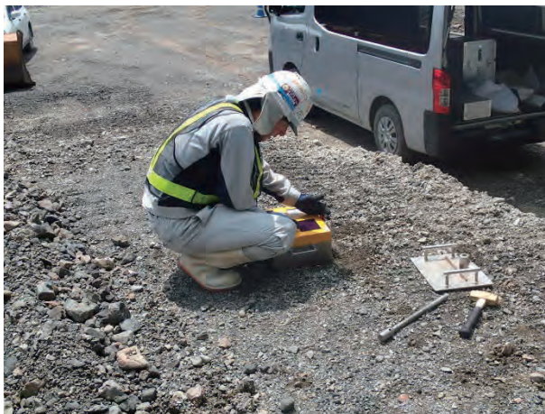
写真 5. 39 締固め試験状況
