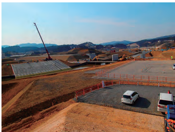
地盤の嵩上げ及び堤防設置状況①
