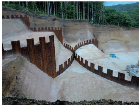
樽前山覚生川 鋼製セル型堰堤 (2013)
