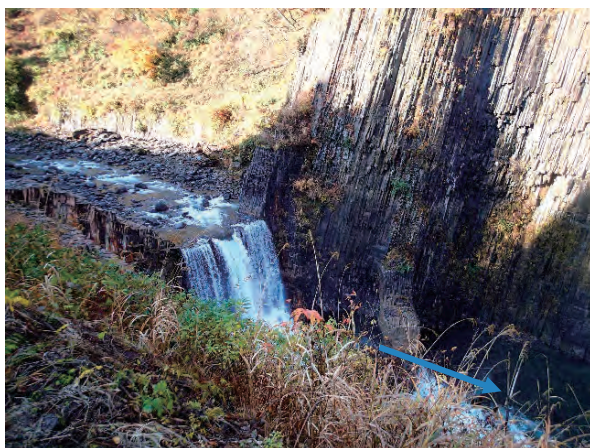
図 2.2.1 七ツ釜砂防堰堤を下流から望む
