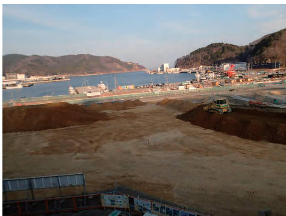
港の復旧状況
