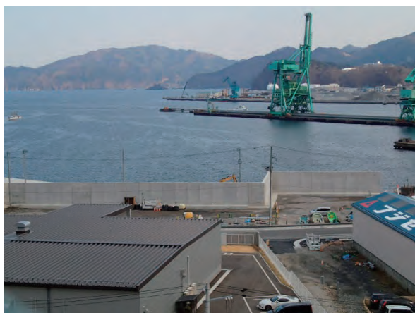
設置中の堤防
