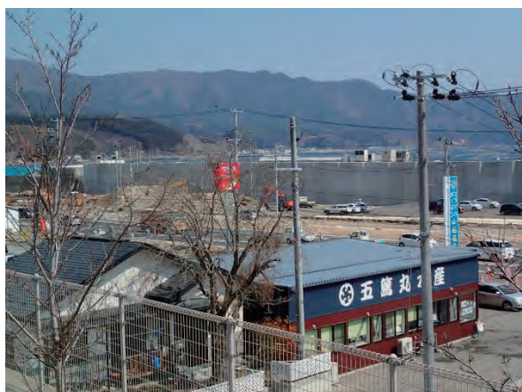
設置された堤防①
