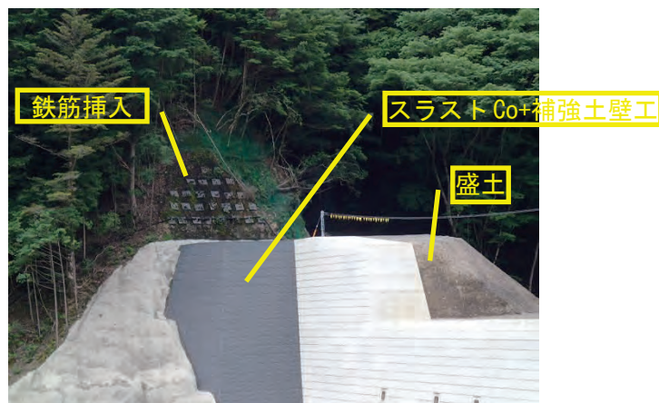
写真 4.7 左岸袖部対策
