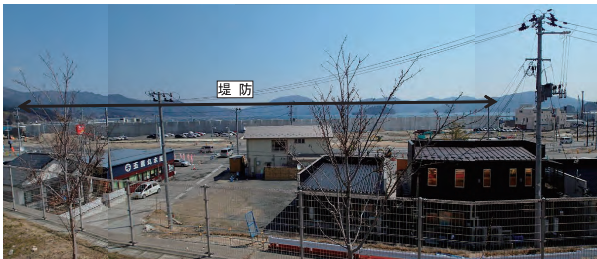
堤防施工状況
