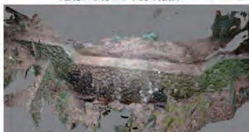
図2 ①下流側堰堤の三次元画像
