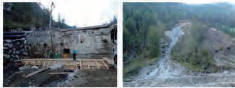
写真2 (B)区間での堰堤補修の状況と右岸崩壊の状況
