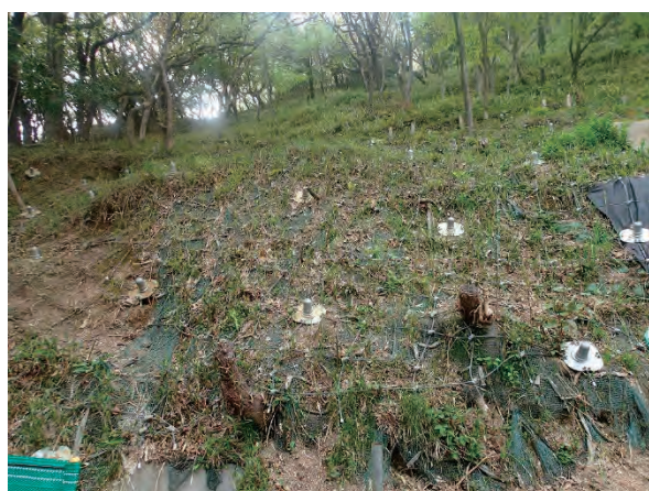
写真 2.2.12 ノンフレーム工法 (1)
