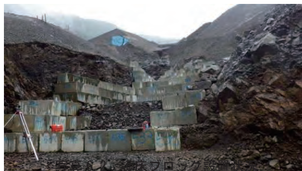
写真 6.2 護床ブロック設置状況 (平成 24 年度実践実習報告より)
