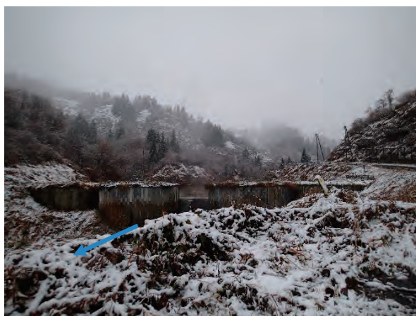
図 2.3.10 神沢川砂防堰堤を下流側から望む
