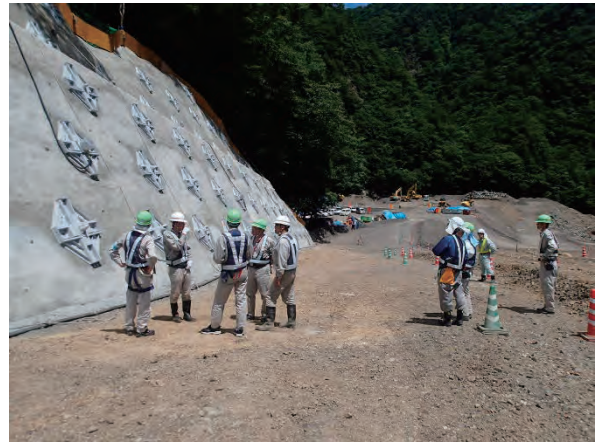
写真 5.7 安全パトロール実施状況
