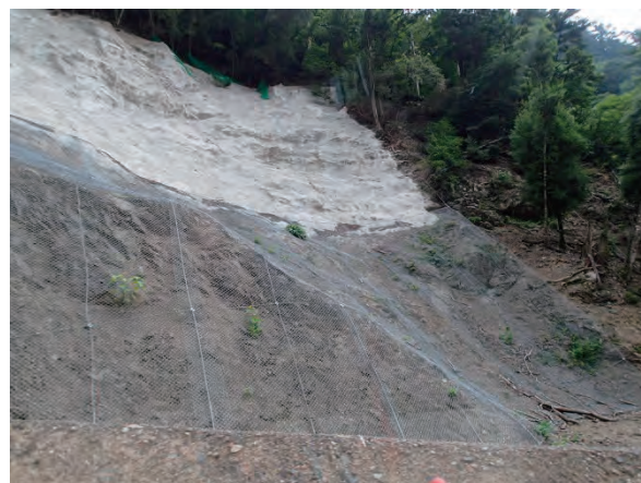
写真 5.20 ネット工及びモルタル吹付
