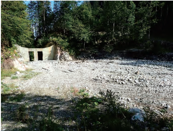
堰堤及び堆砂状況
