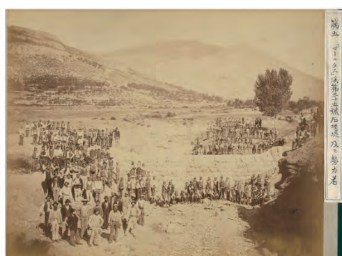
Dalmatien Wildbach "Mahnitas" bei Knin; Thalsperre Nr. 35 und Arbeiterschaft 「マーニタス」溪第三十五号石堰堤及ヒ労力者
