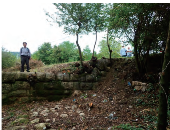
左支溪最下流の石積堰堤の状況
