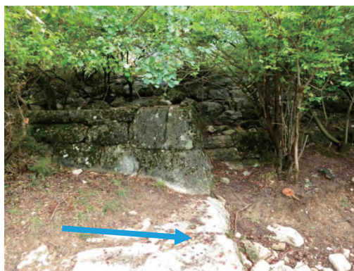
鉄道橋上流側における石積堰堤の状況
