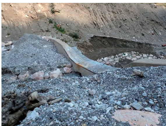
堰堤④堆砂状況
