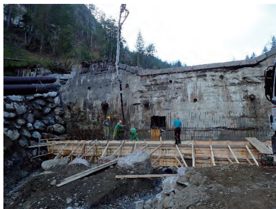
コンクリートの打設状況
