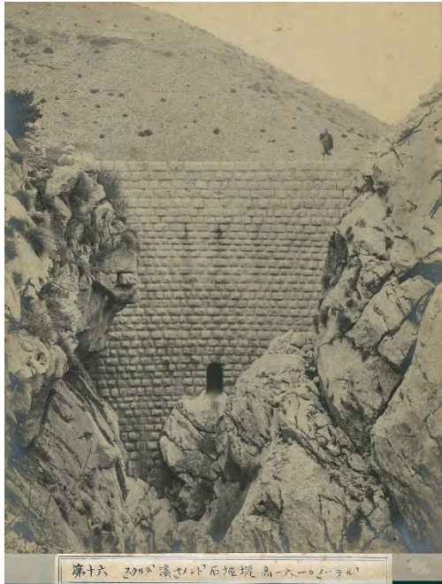
第十六 野川溪谷の「セメント」石堰堤 高十六、一〇「メートル」 Wildbach Skurda" in Montenegro/ Thalsperre Nr. 1 / 16,10 m hoch/ in Portland-Cementmauerung 「スクルダ」溪「セメント」石堰堤 高十六、一〇「メートル」
