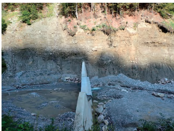
堰堤⑤右岸から望む
