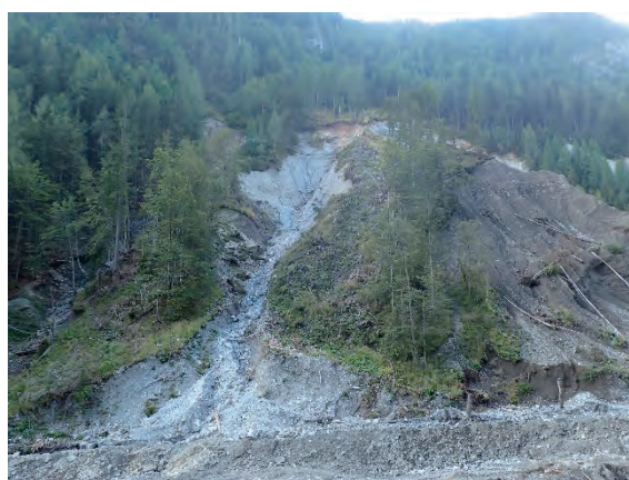
右岸の崩壊状況
