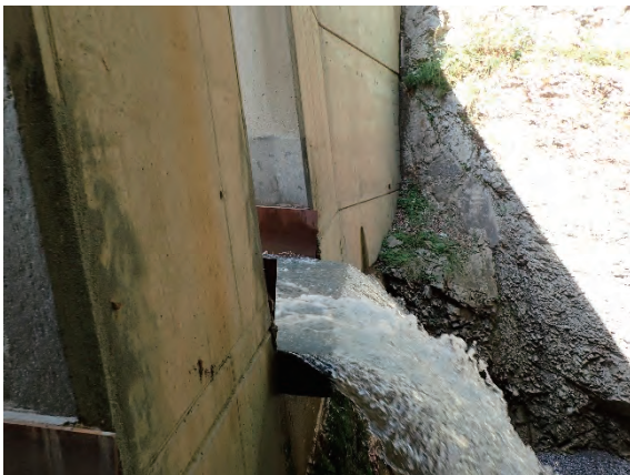
スリットを通過する流水の状況
