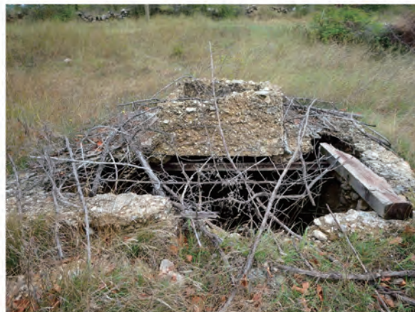
砂防堰堤堆砂地内にある 炭鉱の縦坑
