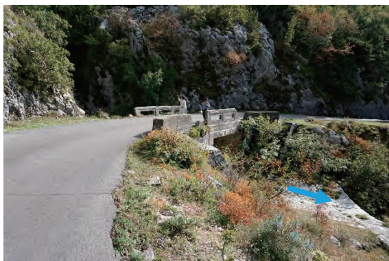
石積堰堤の状況
