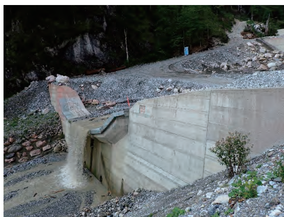
堰堤③（2012 年竣工）
