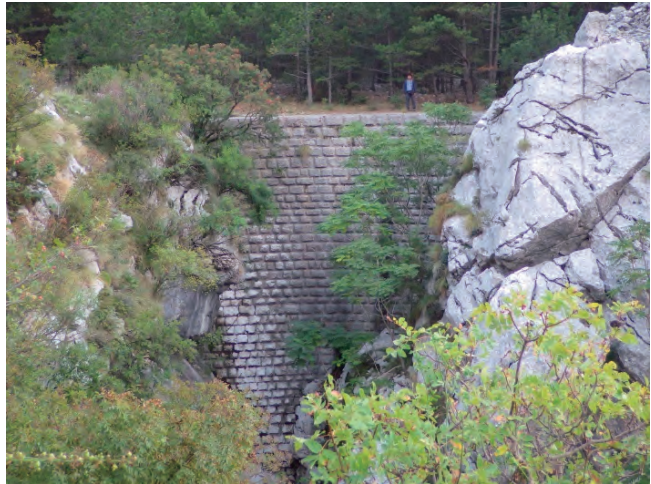
石積堰堤の現況（2016 年 9 月）
