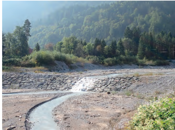
合流部から約 1.4km 上流の落差工
