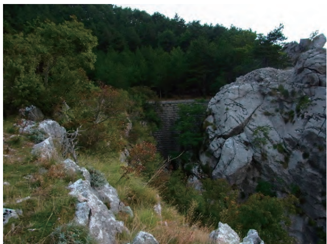
堰堤背後の樹木の状況
