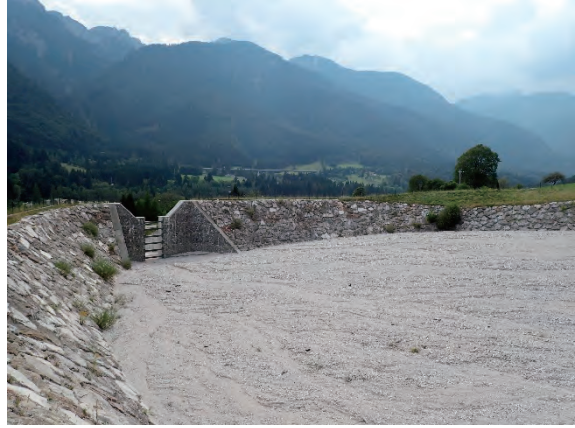
土石流堆積工および堆砂敷
