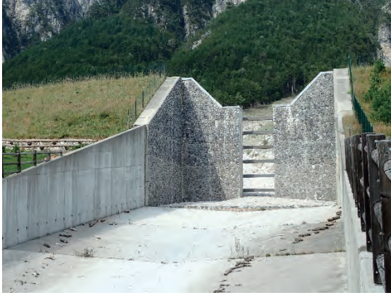
横棧の備わったスリット部
