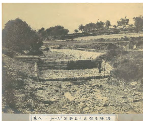
Dalmatien Wildbach "Mahnitas" bei Knin, Fertige Thalsperre Nr. 33, sammt bergseitigem linksufrigem Leitwerke 「マーニタス」溪第三十三号石堰堤
