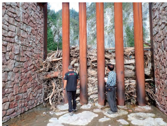
鋼管スリット，流木堆積状況
