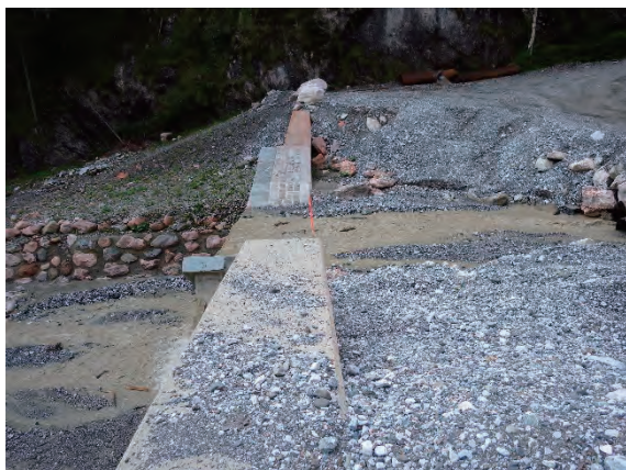
堰堤③水通し部
