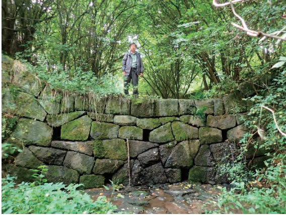
石積堰堤の状況
