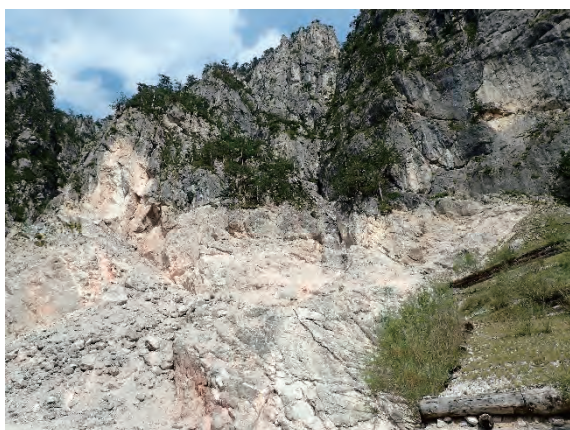
上流堰堤より上流側の状況
