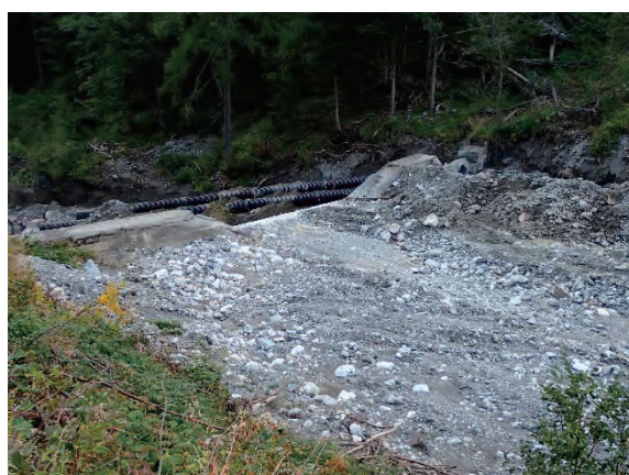
既設堰堤の堆砂状況
