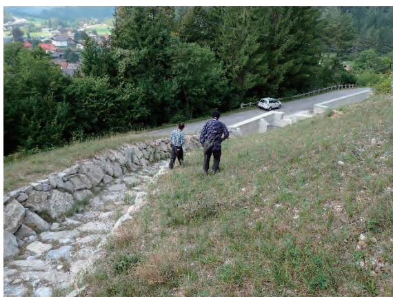
流末付近は石積の溪流保全工
