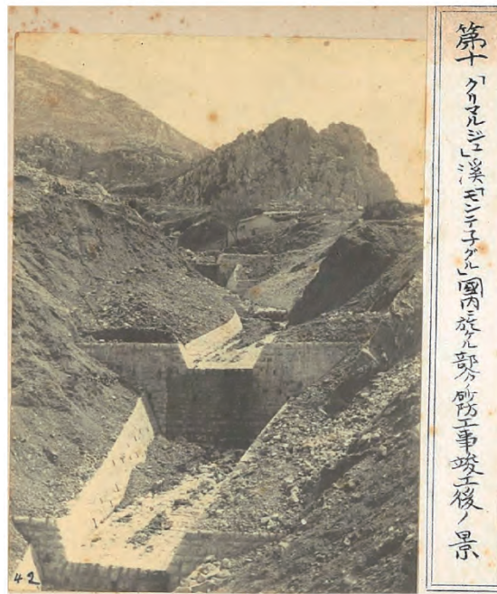
Kriminalj / Montenegro 「クリマルジュ」溪「モンテ子グル」国内 ニ於ケル部分ノ砂防工事竣工後ノ景
