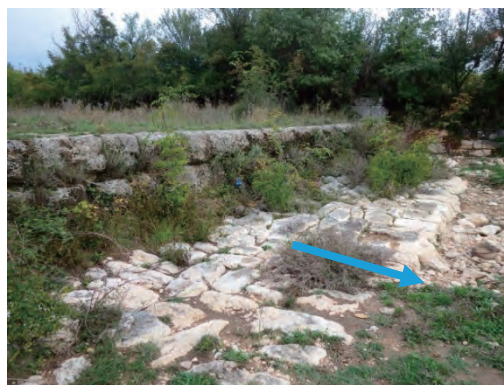
道路橋上流側における石積堰堤の状況
