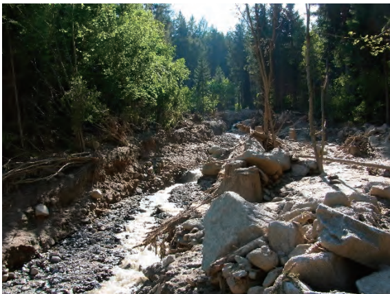
土石流発生後の溪流の状況
