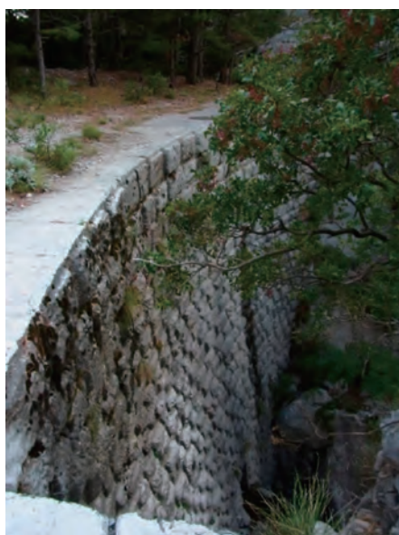
アーチ型状の構造 （右岸から左岸を望む）
