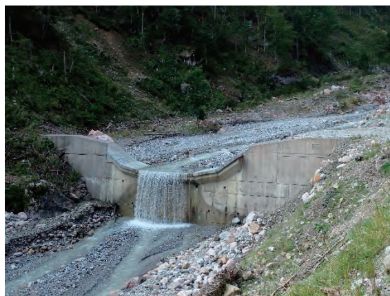
堰堤②（2009 年竣工）
