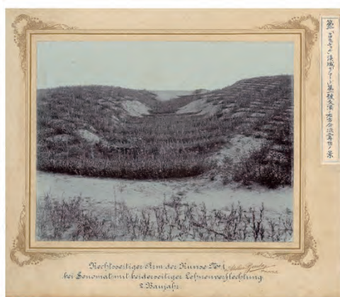
Rechtseitiger Arm der Runse Nr. 1 bei Senomat mit beidseitiger Lehnenverflechtung 2. Baujahr 「ラコニツチェル」溪域「セノマート」 第一号支溪右方分派二年目の景
