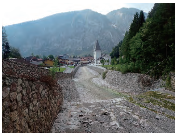
堰堤より下流を望む
