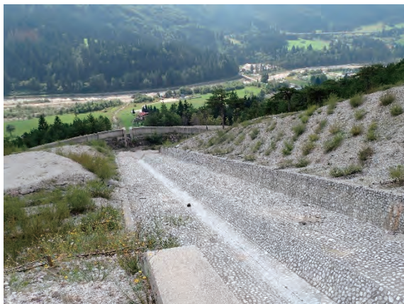
上流堰堤から流路工を望む
