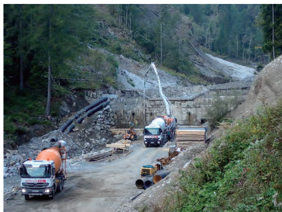
施工状況（遠景）
