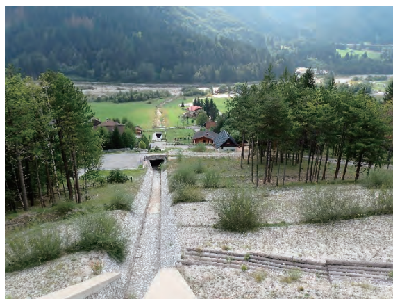
土石流堆積工から下流を望む
