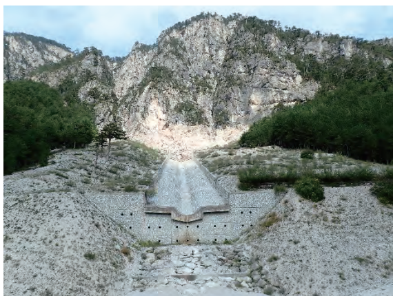
土石流堆積工から流路工を望む
