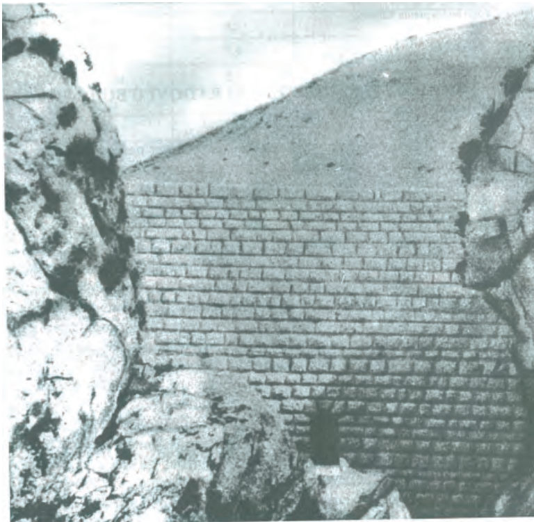
Slika 15. Lučna deponijska pregrada visoka 17m u koritu bujice Škurda, iznad Kotora. (Foto: A. Hofman)
