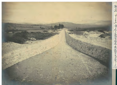
Dalmatien Wildbach "Mahnitas" bei Knin; 1300 m Thallaufcünette 「マーニタス」溪ニ於ケル底張石工 竣工後ノ景 (底張石工ノ長千三百「メートル」)
