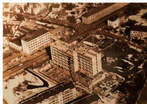
フィラハ合同庁舎の建設状況 (事務所展示の写真)
