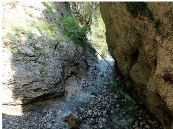
堰堤下流の狭窄部
