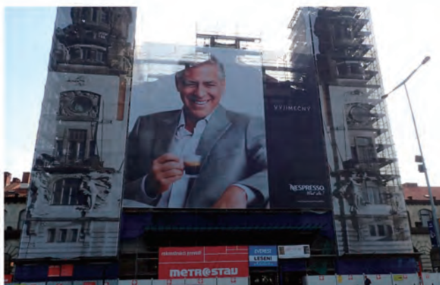
プラハ本駅 改修工事のため仮囲い
