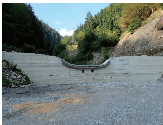
堰堤⑤（2016 年竣工）
