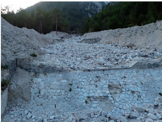
Sàisera 溪支溪の堰堤の状況
