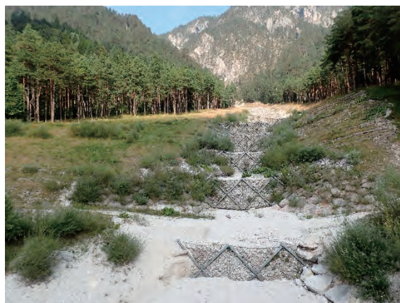
ネットによる階段式床固工群
