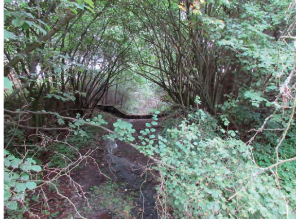
上流側の堆砂状況
