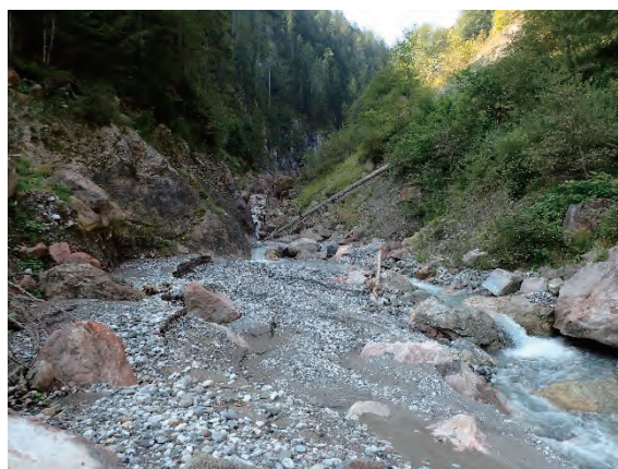
堰堤⑤より上流の状況
