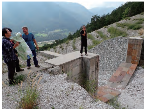
上流堰堤の水通し部
