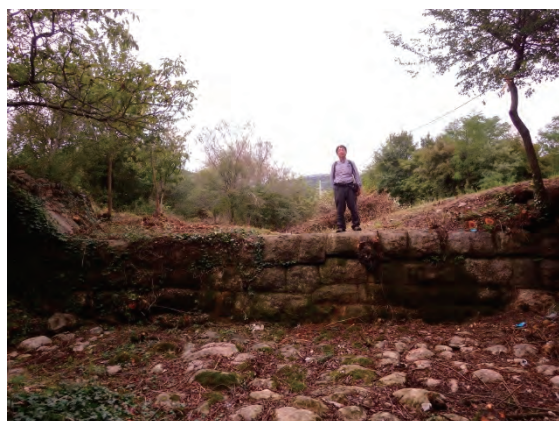
左支溪最下流の石積堰堤の状況
