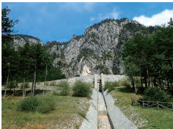
下流より堰堤を望む
