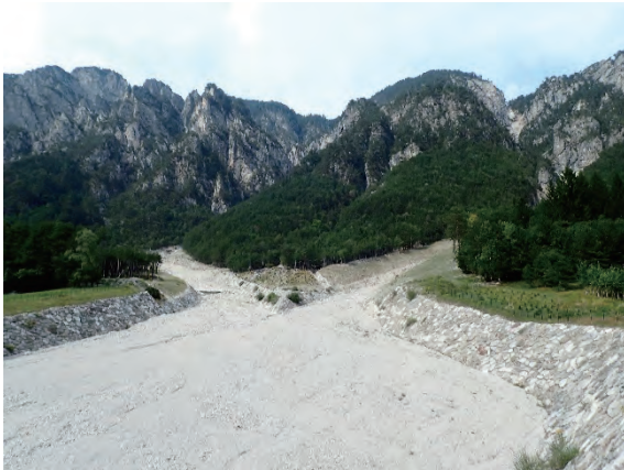
土石流堆積工の上流側
