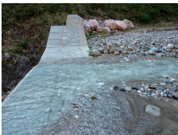
堰堤②水通し部
