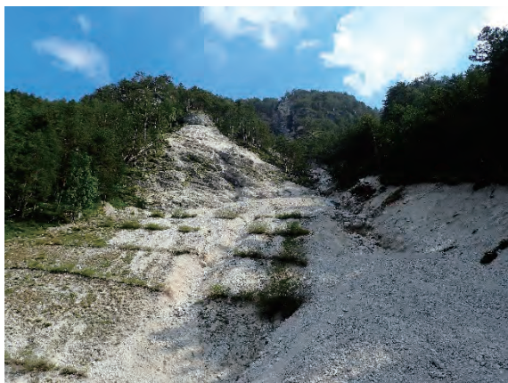
小支溪の上流で行われている山腹工
