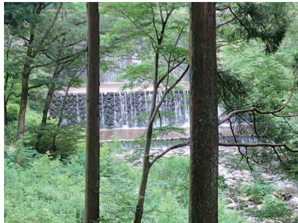
写真 2.1.5 副堰堤と第二副堰堤(既設堰堤) (平成 28 年 7 月 12 日撮影)
