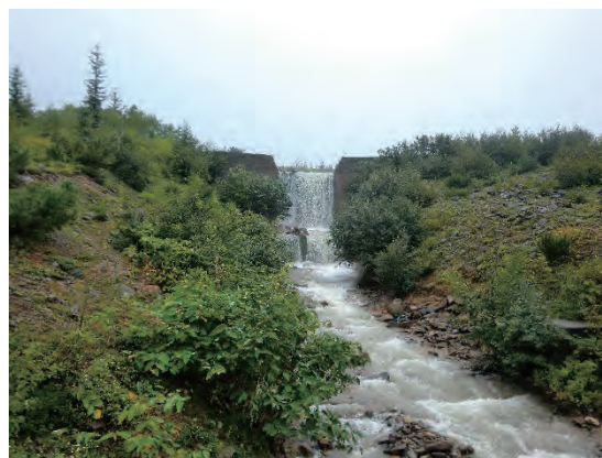
橋より上流部分の富良野川床固工
