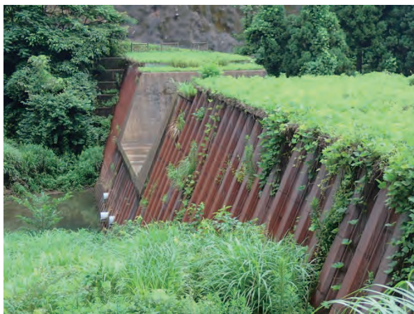
写真 2.5.1 上流側鋼製矢板
