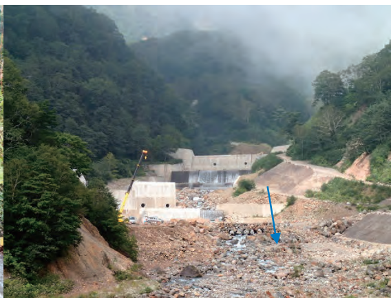
湯川 12 号堰堤より上流を望む
