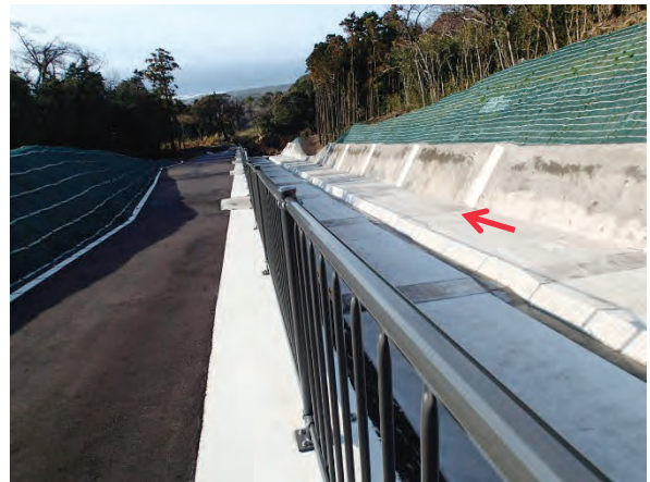
中流導流工と管理用道路
