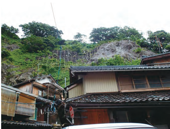
写真 2. 15. 3 吹付法砕工、モルタル吹付＋鉄筋挿入工
