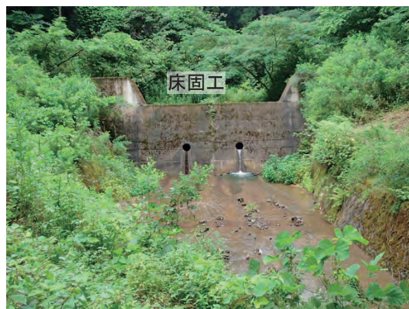
写真 2. 6. 1 金谷川床固工全景 (平成 28 年 7 月 13 日撮影)
