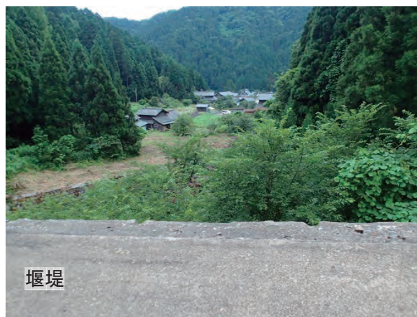
写真 2.8.2 下流域の家屋(保全対象)
