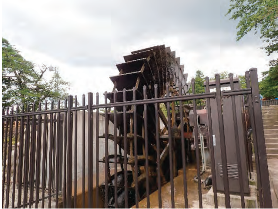
常西公園小水力発電
