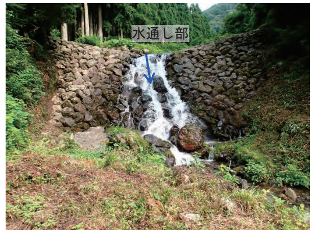
写真 2. 12. 6 高倉谷川砂防(立成 1 号堰堤) (平成 28 年 7 月 14 日撮影)
