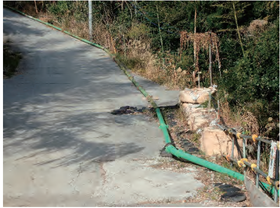
コンクリート配管
