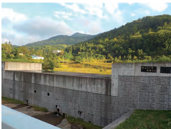
西山川 7 号砂防ダム
