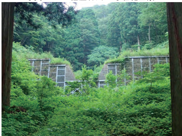
写真 2. 4. 3 経座谷川 2 号堰堤全景
