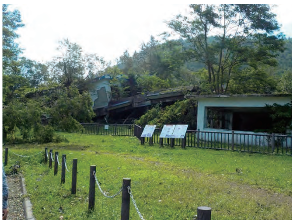
三恵病院の倒壊状況
