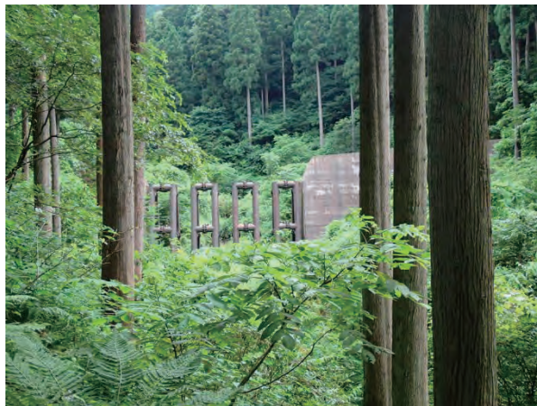
写真 2.6.6 三ツ俣川第 2 砂防堰堤
