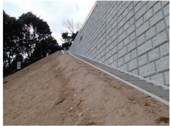
304 溪流の砂防堰堤前面右岸の管理用階段
