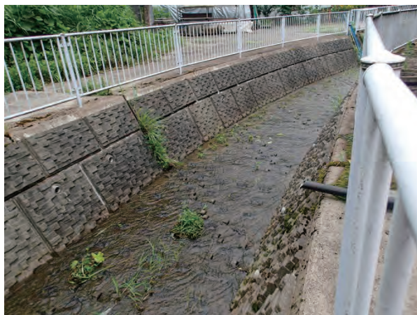
写真 2. 10. 3 流路工開渠部 (平成 28 年 7 月 14 日撮影)
