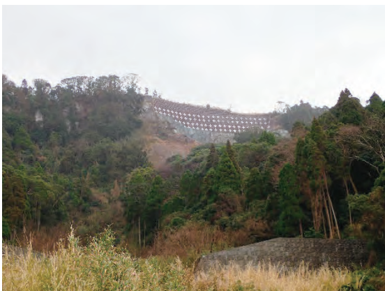
山腹工（法枠+アンカー工）
