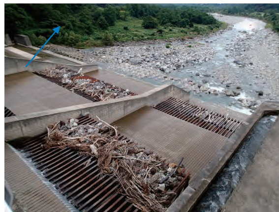
横江堰堤（流木捕捉状況）
