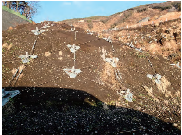
斜面安定化工(ワイヤロープ+鉄筋挿入)
