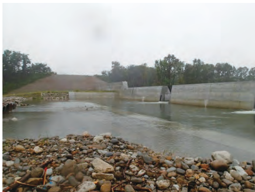
下流側より堰堤右岸部を望む
