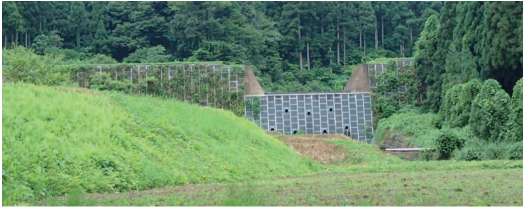
写真 2.5.2 蔵作川 1 号砂防堰堤全景
