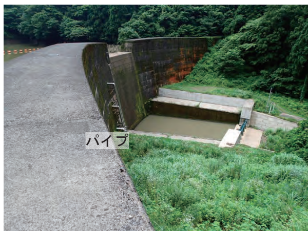
写真 2.9.2 岡本砂防堰堤全景
