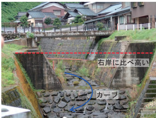
写真 2.5.5 蔵作川溪流保全工②
