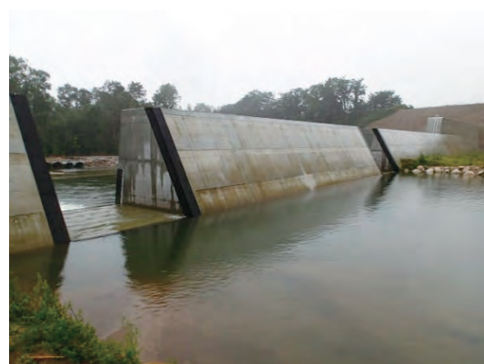
上流側より堰堤右岸部を望む
