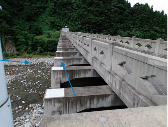
常願寺川沿岸用水左岸連絡水路橋
