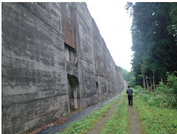
写真 2.3.1 雪崩防護壁全景(南側より望む)
