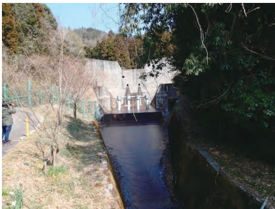
堂ヶ原川 1 号砂防堰堤
