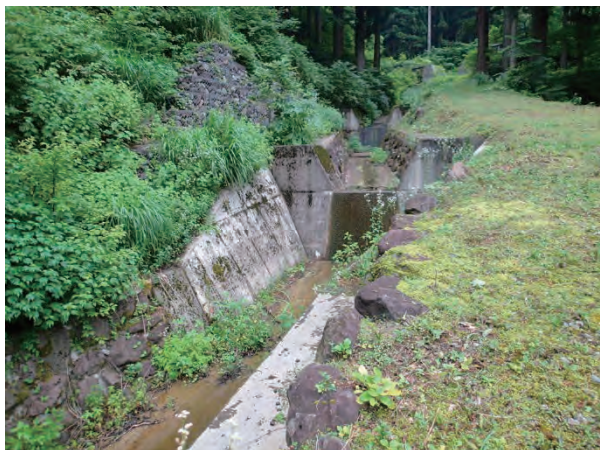
写真 2. 4. 5 座禅谷川 1 号堰堤下流の溪流保全工
