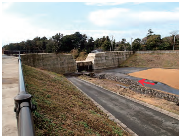
大金沢本川堆積工(下流方向を望む)
