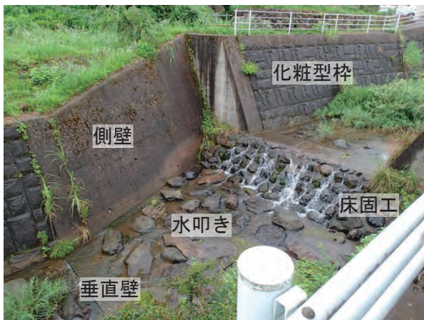
写真 2.5.3 蔵作川溪流保全工
