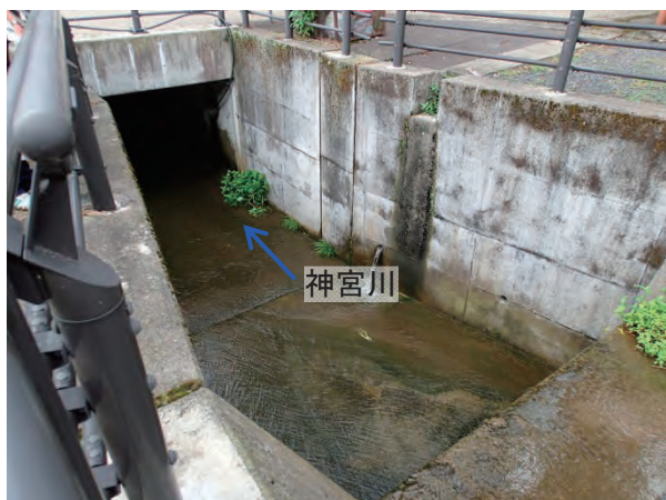
写真 2. 10. 4 函渠部呑口部
