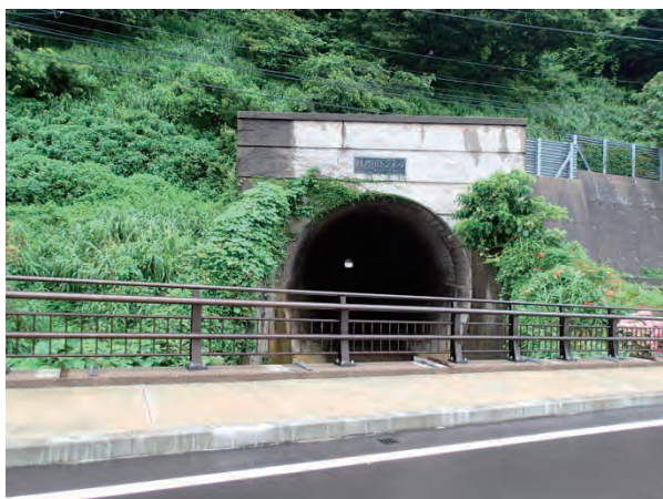
写真 2. 14. 3 河川トンネル吐口部 (平成 28 年 7 月 15 日撮影)
