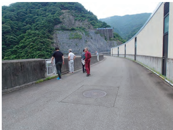
写真 2.2.2 真名川ダム全景②
