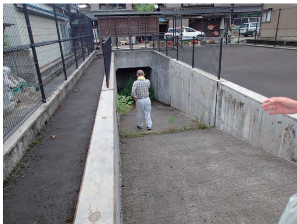
写真 2. 10. 5 維持管理のための進入通路 (平成 28 年 7 月 14 日撮影)
