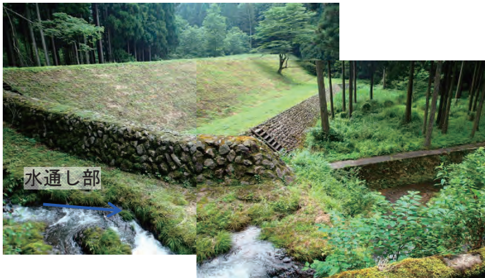
写真 2. 12. 5 アカタン砂防(九号堰堤)
