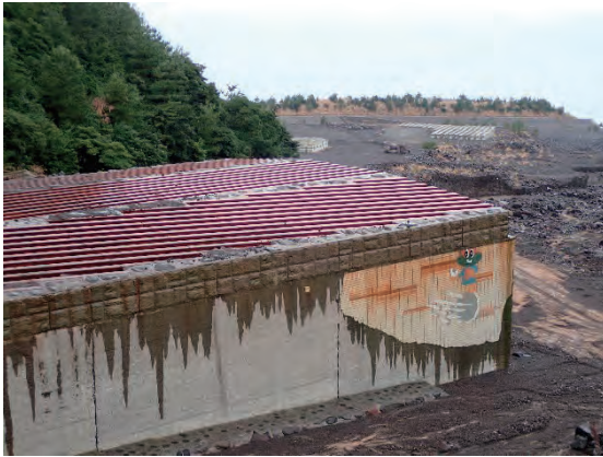
野尻川4号スクリーン堰堤
