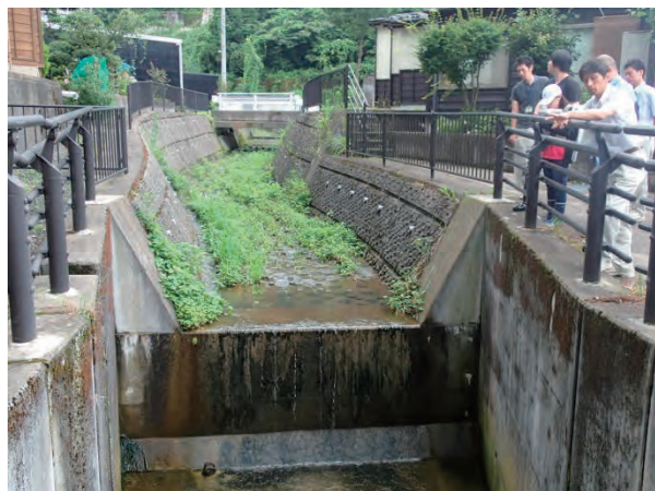
写真 2. 10. 2 床固工
