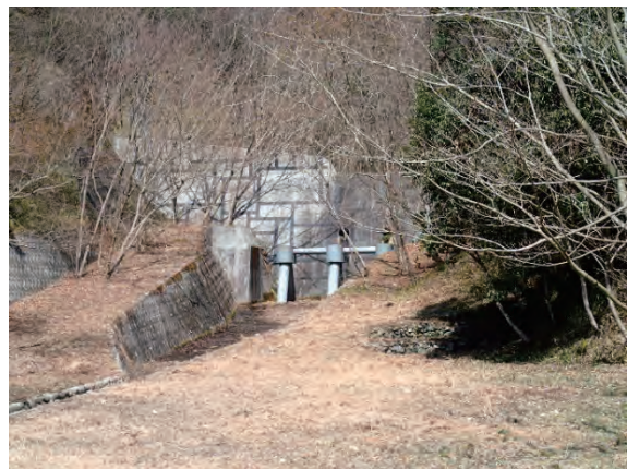
安川左支川砂防堰堤
