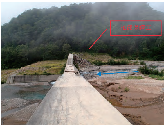
左岸側より右岸側袖部保護工を望む
