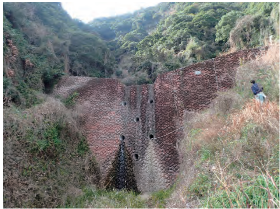
竜ヶ水谷（第二工区）砂防堰堤
