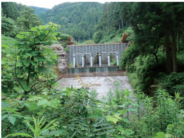
写真 2.6.5 三ツ俣川第 1 砂防堰堤
