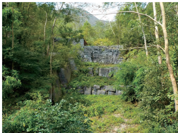
昭和川砂防ダム
