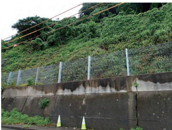
写真 2. 15. 1 落石防護柵＋重力式擁壁工
