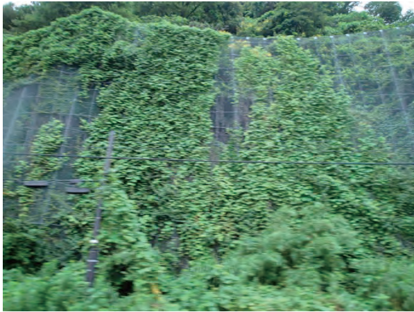
写真 2. 15. 5 ポケット式落石防護網
