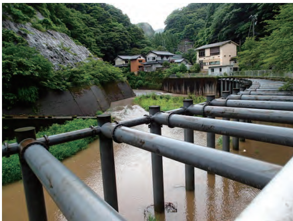
写真 2. 14. 1 鋼管製の流木止め
