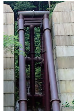
写真 2.11.2 併設されたリングネット
