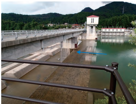
横江堰堤（固定部）
