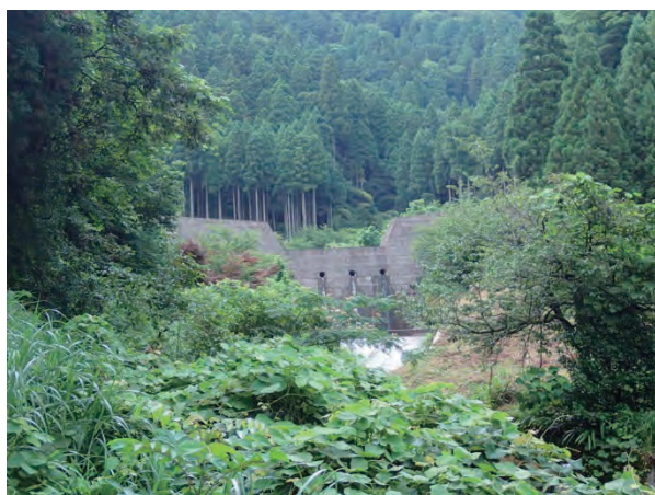
写真 2.8.1 岩窟谷川砂防堰堤全景
