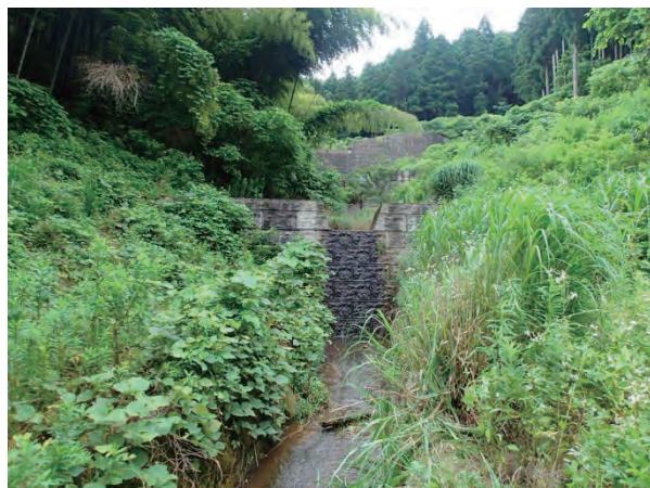
写真 2. 6. 2 須別当川堰堤全景
