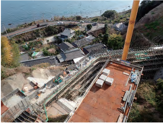
花倉第三谷砂防堰堤の施工状況と保全対象
