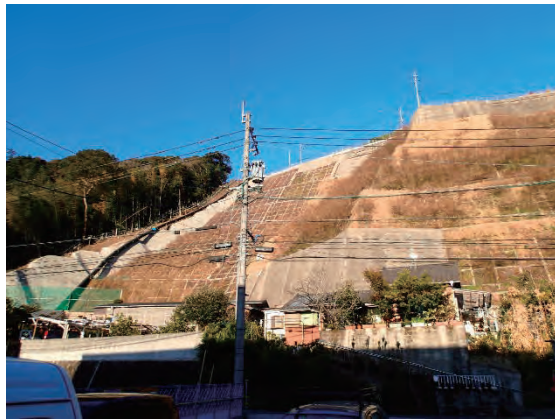
田上地区の急傾斜地対策の実施状況
