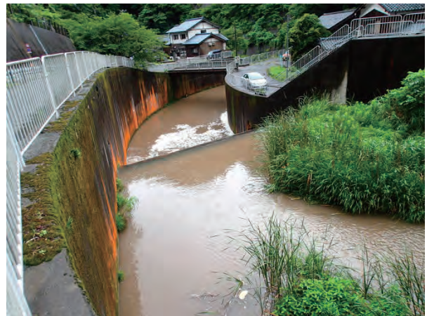
写真 2. 14. 2 沈砂池 (平成 28 年 7 月 15 日撮影)
