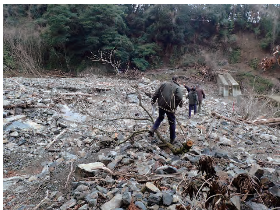
磯脇川砂防堰堤（満砂）
