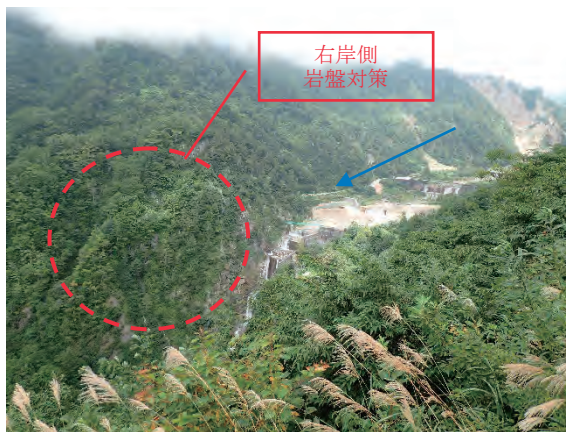
白岩堰堤右岸側
