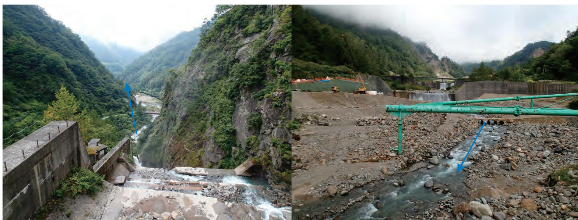
白岩堰堤より下流側を望む
