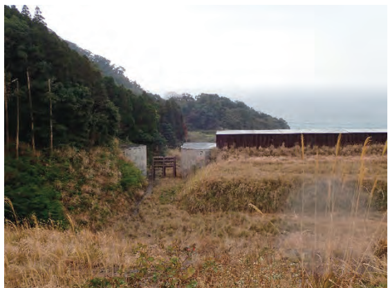
嵩上げを実施した 1 号堰堤 (鋼製セル+鋼製スリット)
