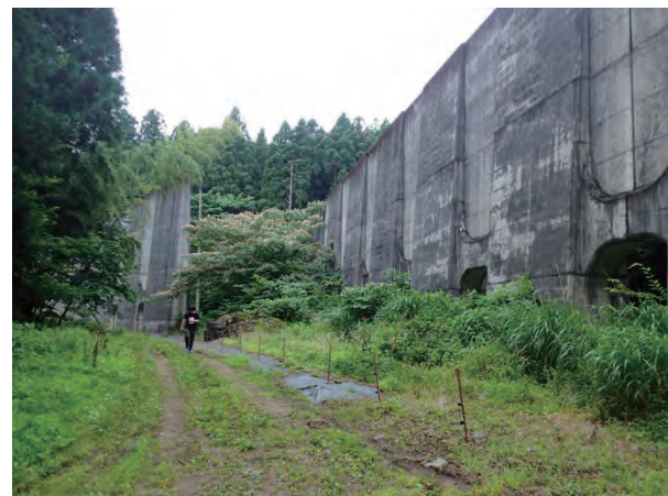
写真 2.3.2 雪崩防護壁全景(北側より望む)
