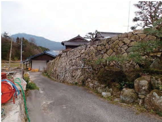
土石流防護壁外面部
