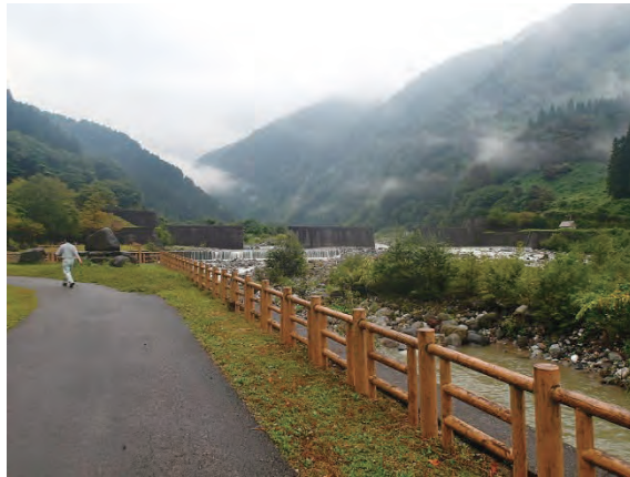
津之浦下流砂防堰堤
