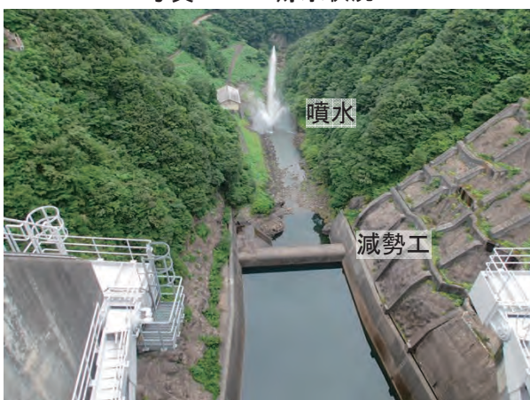
写真 2.2.5 下流への放流状況
