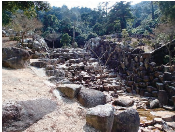
白糸川 2 号砂防堰堤
