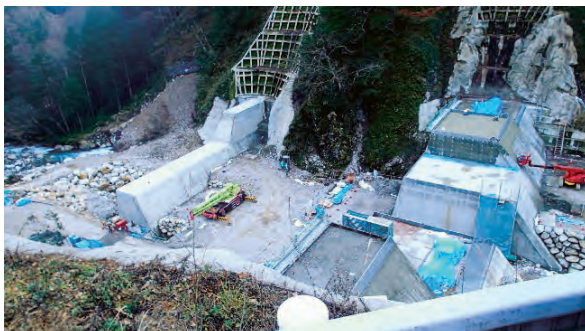
黒川第 4 砂防堰堤施工状況
