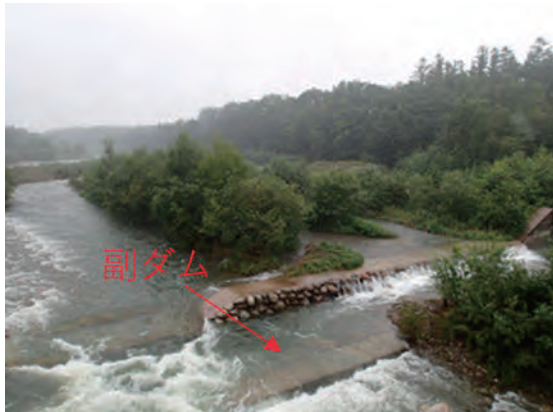
戸蔦別川第 6 床固工
