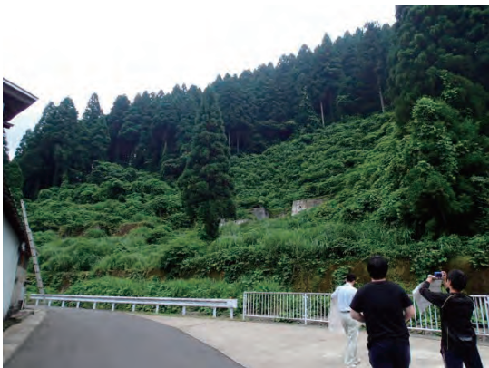
写真 2. 10. 9 地すべり対策箇所全景
