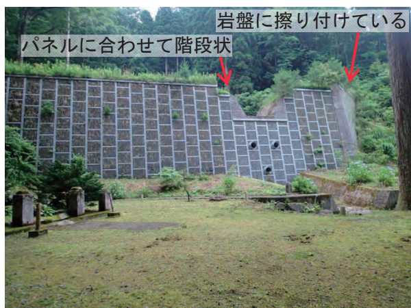
写真 2. 4. 1 経座谷川 1 号堰堤全景
