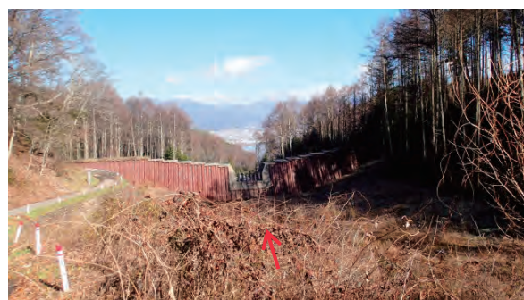
小田井沢3号堰堤
