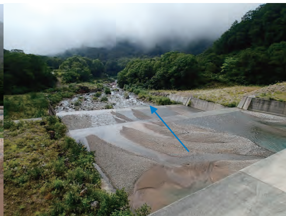
湯川 12 号堰堤より下流を望む
