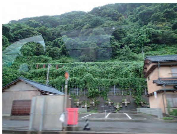
写真 2. 15. 4 アンカー工
