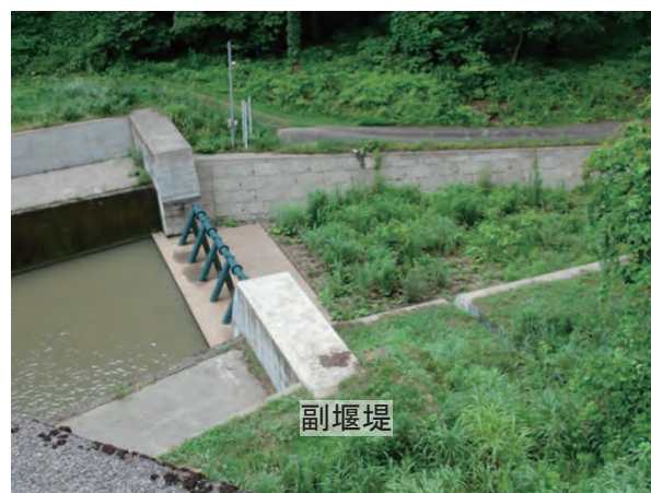
写真 2.9.3 副堰堤全景 (平成 28 年 7 月 14 日撮影)
