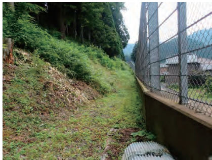
写真 2.7.1 落石防護柵と重力式擁壁工
