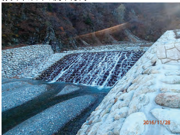
小武川下流第1床固工
