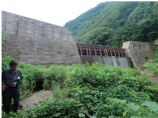
写真 2.1.4 鬼谷川堰堤上流の部分透過型堰堤
