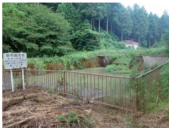
写真 2. 10. 1 上流側砂溜め工全景 (平成 28 年 7 月 14 日撮影)
