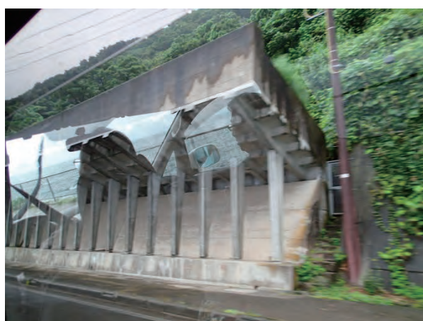
写真 2. 15. 2 落石防護棚
