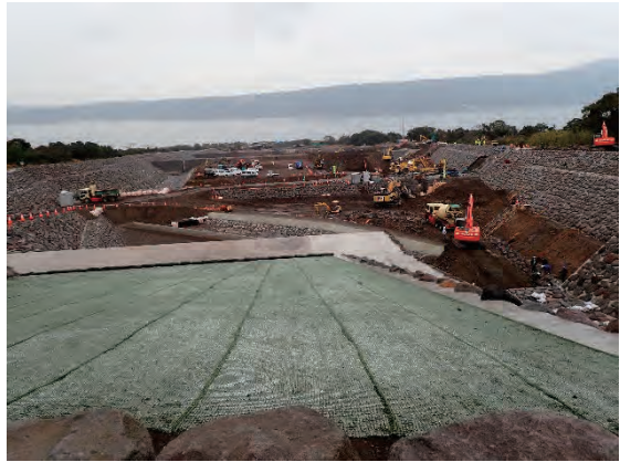
長谷川遊砂地の施工状況
