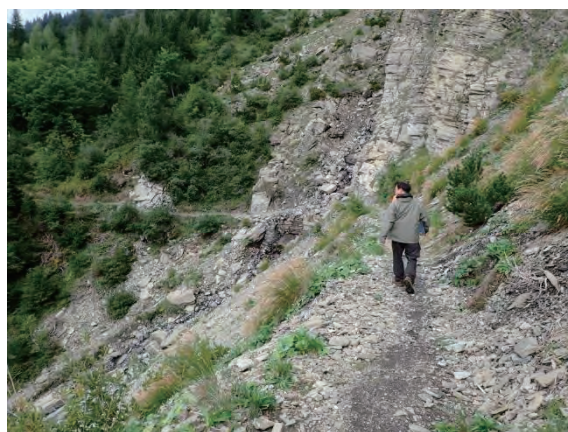
砂防用作業道の状況
