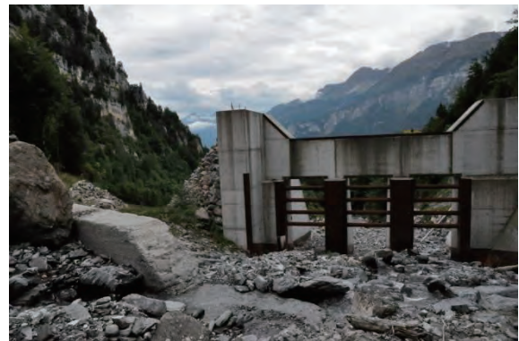
C ゾーンにおける堰堤（上流より撮影）
