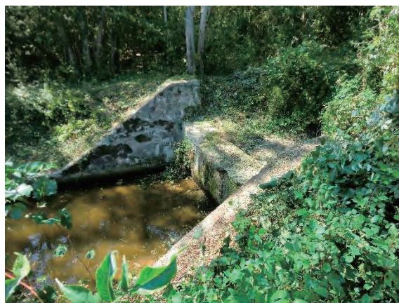
堰堤①全景 (2)
