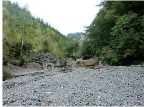
中流部の 1A 堰堤
