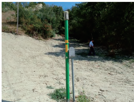
パイプラインルートを示す標柱
