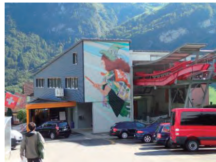
ロープウェイ山麓駅の外観
