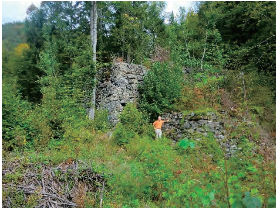
導流堤の状況
