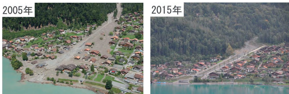
Glyssibach 下流部（左：2005 年当時の被災状況／右：改修後の 2015 年時点の状況）
