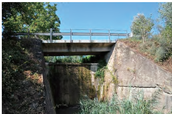
堰堤②全景
