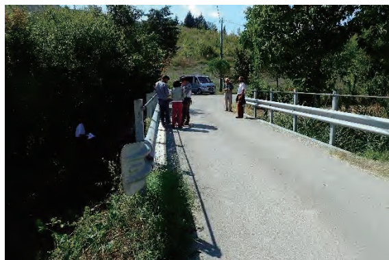
堰堤②真上の橋梁（左岸より撮影）
