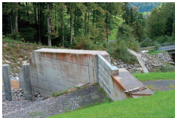
アーチ型堰堤右岸に設置されたシャッター
