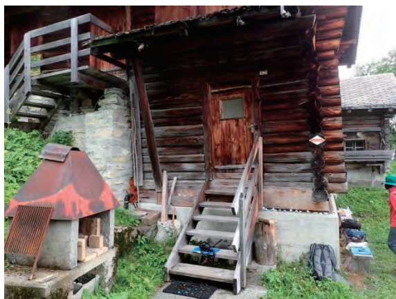
Lammbach の上流に設置された山小屋
