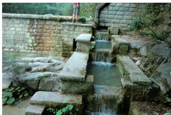
堰堤左岸の魚道
