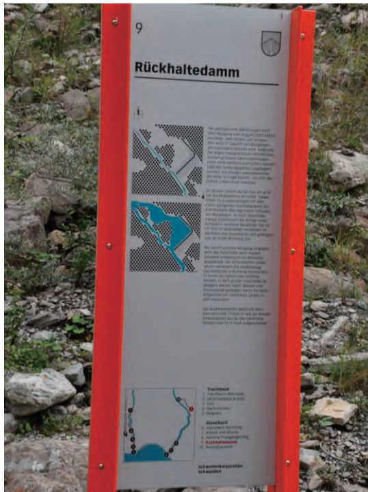
Glyssibachの遊砂地を紹介するパネル
