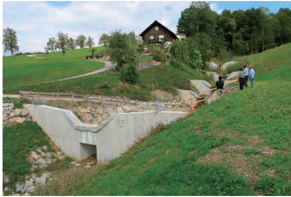
透過型堰堤（下流側）
