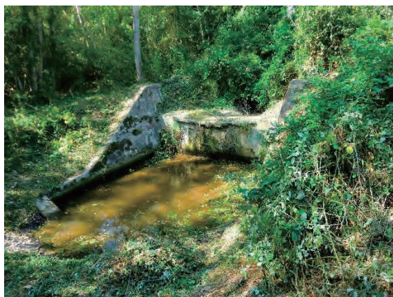
堰堤①全景 (1)
