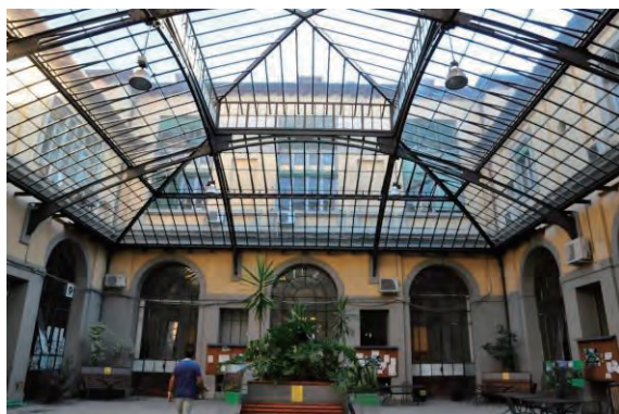
フィレンツェ農林大学建物内
