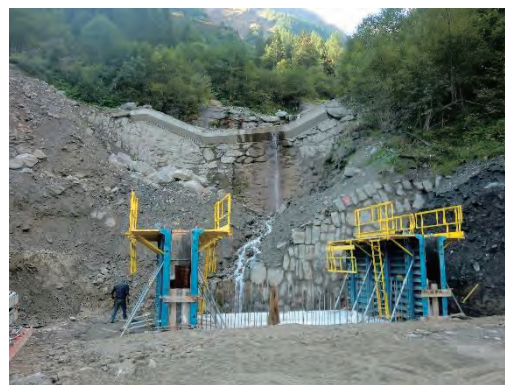
堰堤の工事状況
