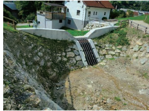
透過型堰堤（上流側）
