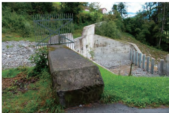
アーチ型堰堤と流木止
