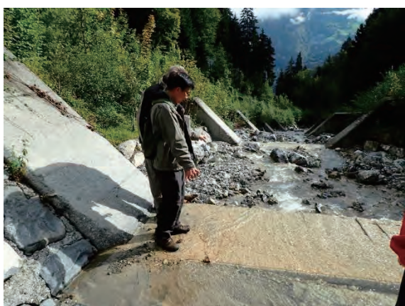
水通し部の摩耗により鉄筋露出した様子
