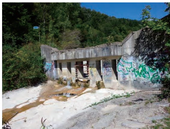
堰堤の下流より撮影
