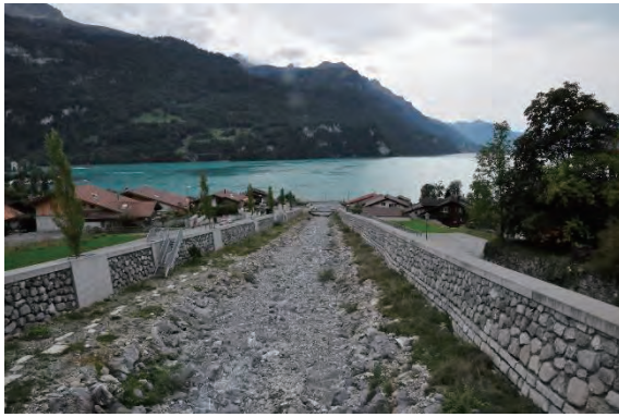
A ゾーンにおける流路工
