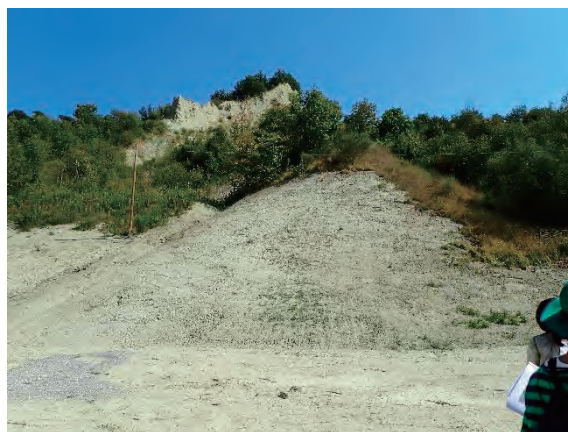
上流側斜面の状況
