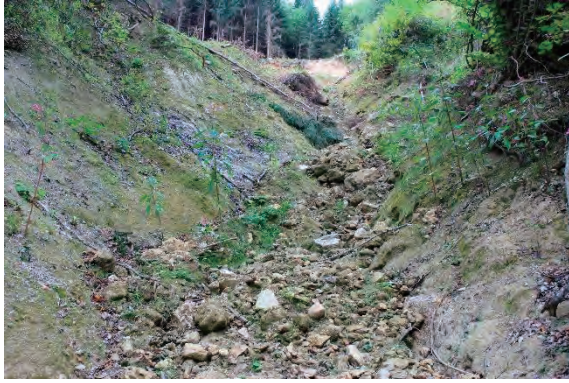
溪流の侵食状況
