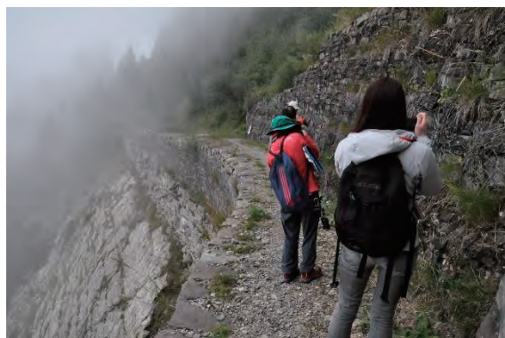
山腹工の状況
