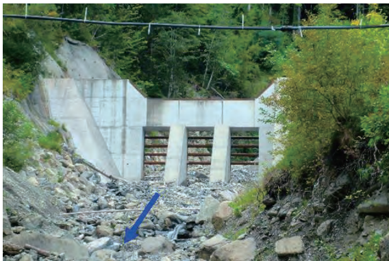
C ゾーンにおける堰堤（下流より撮影）
