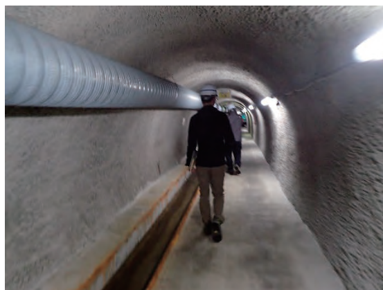
由比地区・大久保排水トンネル（H25 竣工）
