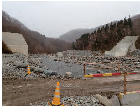
堰堤施工の状況
