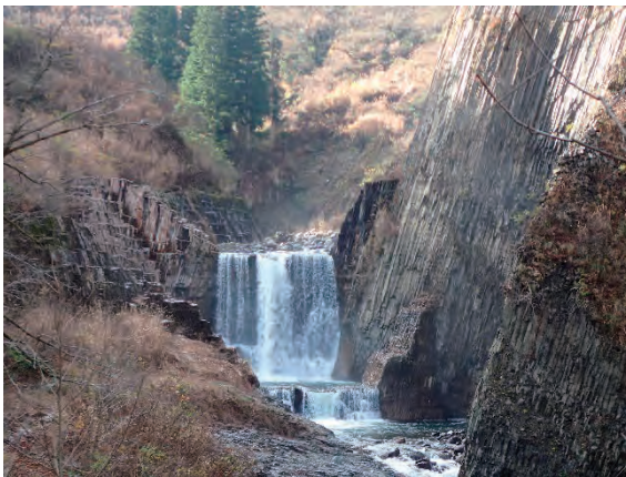
下流より堰堤を望む
