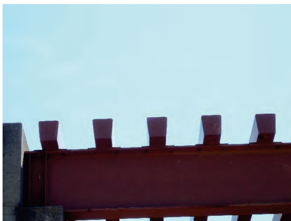
鋼材の状況（逆台形）
