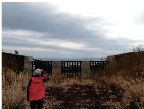
平成 12 年噴火後に施工された 厚木沢堰堤（坪田地区）
