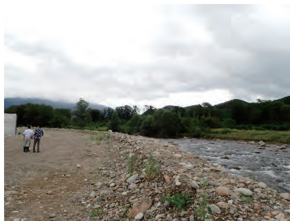
現河道の状況（未施工区間）
