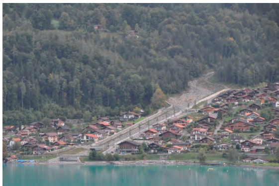
スイス・Glyssibach の流路工
