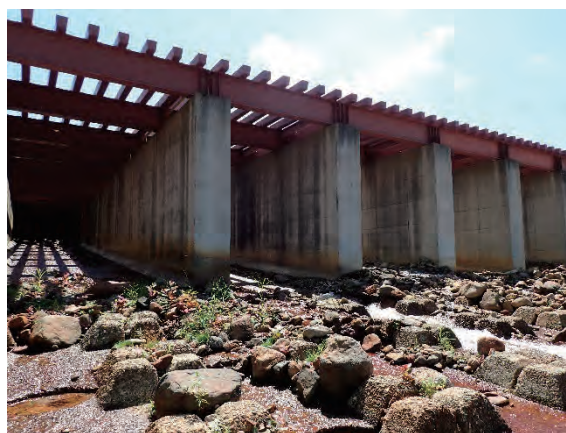
堰堤全景（下流より撮影）
