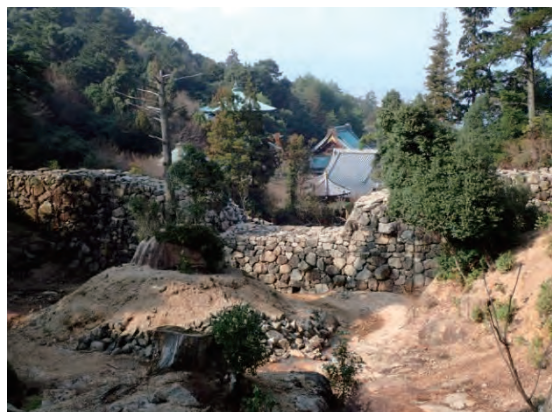
白糸川 2 号堰堤（宮島）
