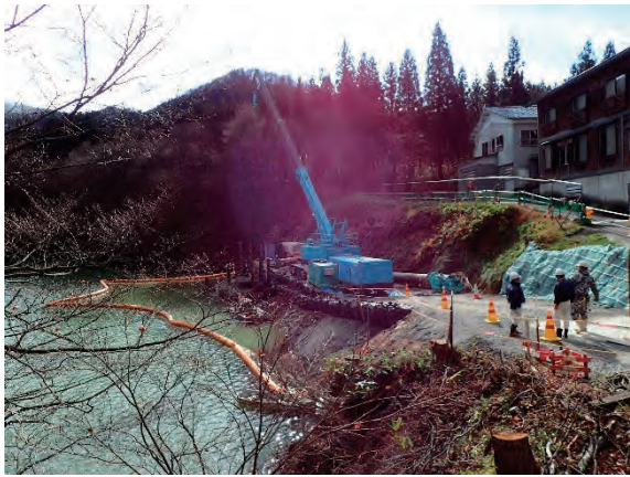
搬入路施工の様子
