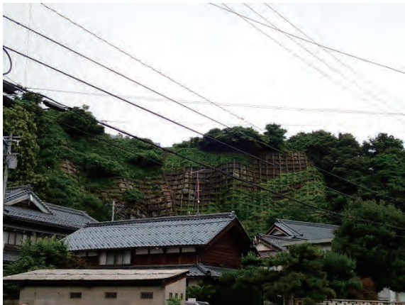
がけ崩れ対策工（法粹工）
