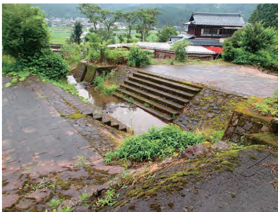
高尾川溪流保全工（左岸より下流を望む）
