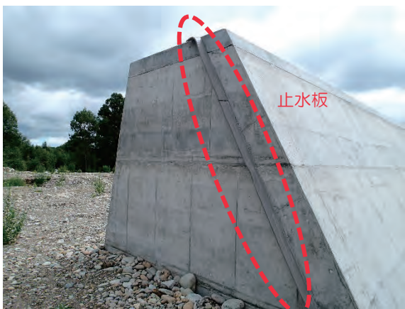
施工済箇所の末端（止水板の設置）
