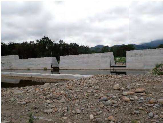
下流より堤体・スリットを望む
