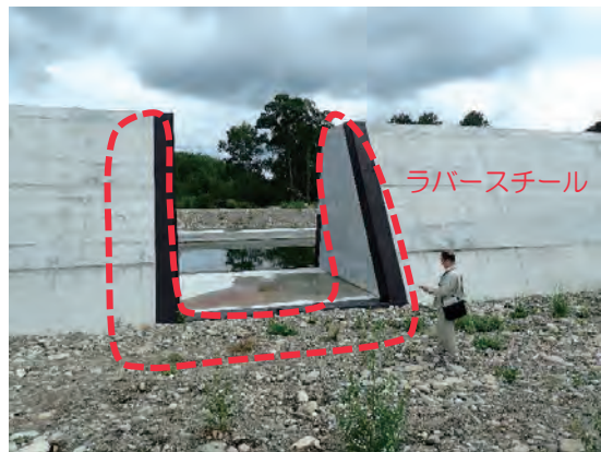
上流よりスリットを望む
