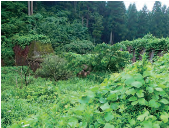
下流側堰堤（右岸上流より望む）
