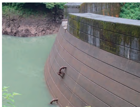
岡本川堰堤湛水部の取水口
