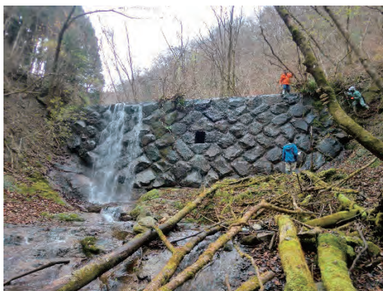
水ノ木沢 2 号堰堤
