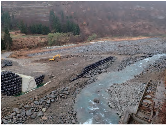
建設中の床固工
