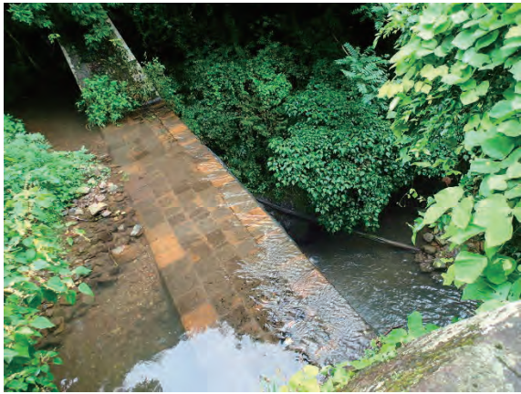
間知石の設置状況
