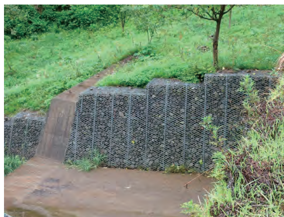
稗苗川 1 号堰堤右岸側壁
