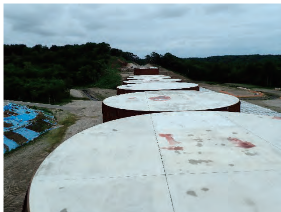
袖部天端から見た堰堤の全景
