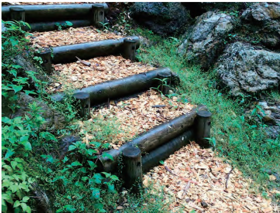
移動路における木材チップ敷設状況
