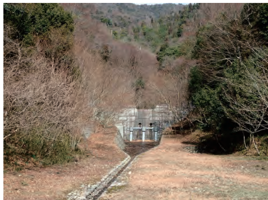
安川左支川堰堤・沈砂地
