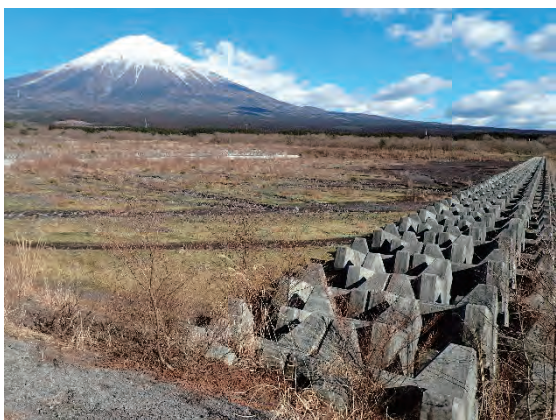
大沢川第 5 上流床固（H21 竣工）
