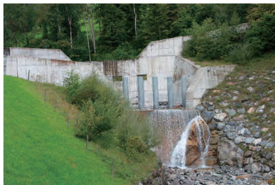
スイス・Steinibach のアーチ堰堤
