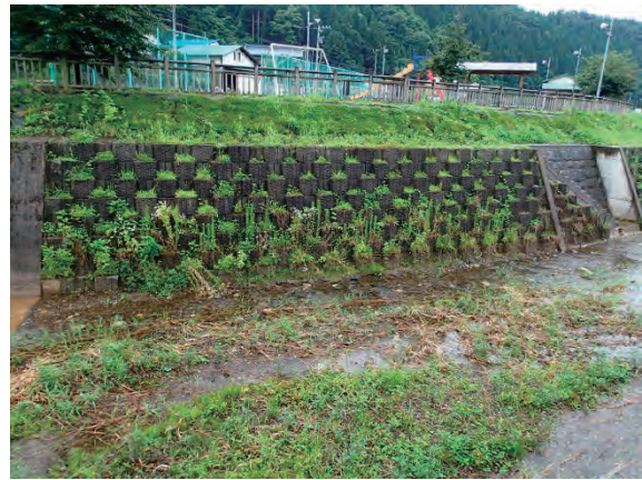
合流後護岸植生の状況
