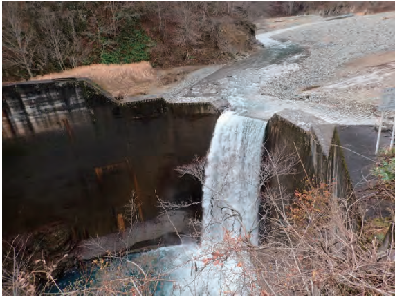
左岸より堰堤を望む
