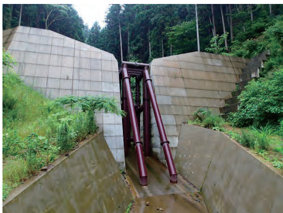
下流より堰堤を望む
