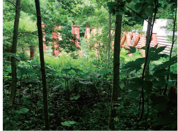
1 号スリット堰堤
