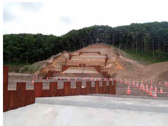
左岸側袖部の切土法面
