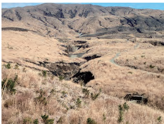
平成 12 年噴火で生成された雄山南麓 ガリ侵食と防止工
