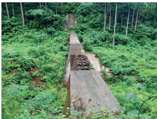
上流側堰堤（右岸より望む）
