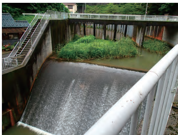
沈砂池・落差工
