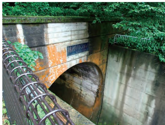
河川トンネル呑口部
