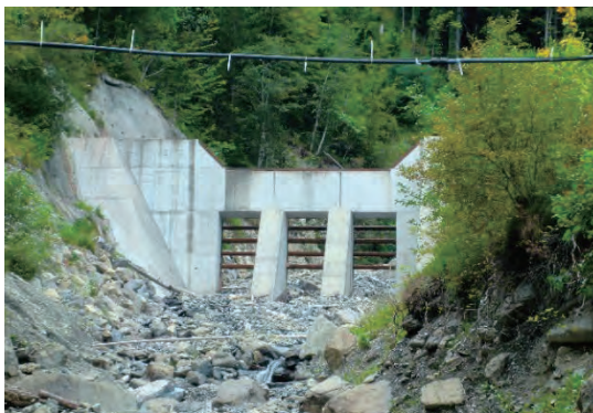
スイス・Glyssibach の透過型堰堤
