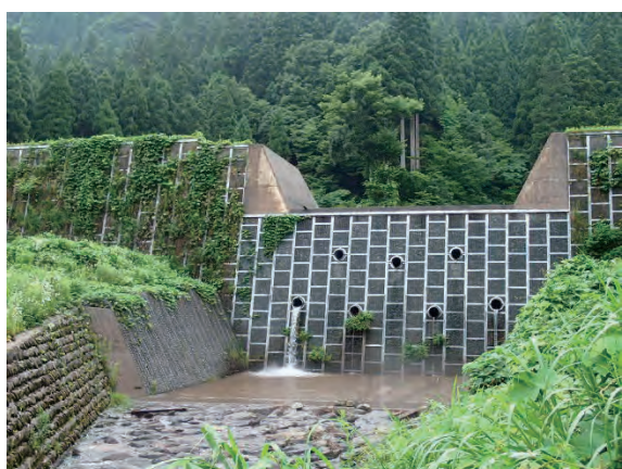
稗苗川 1 号堰堤
