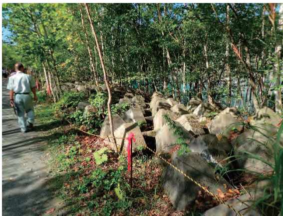
ブロック堰堤袖部（青い池外周）
