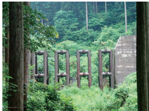
上流側堰堤（下流より望む）
