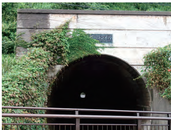
河川トンネル吐口部
