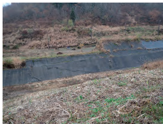
整備された砂防堰堤 2 基
