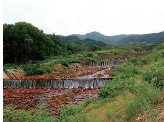
蔵王川火山砂防（36～40号床固工）
