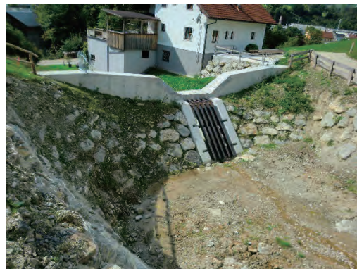
オーストリア・Reisbachriengraben (左：下流の木製堰堤／右：上流の透過型堰堤)
