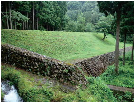
右岸より八号堰堤を望む
