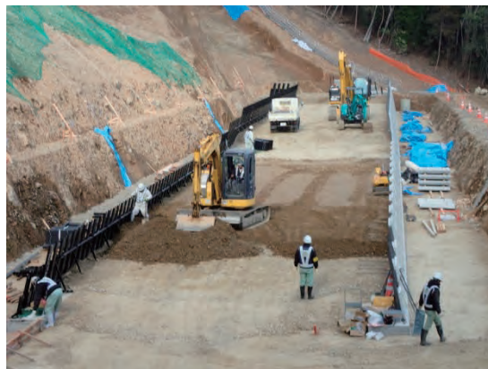
砂防ソイルセメントを用いた堰堤施工
