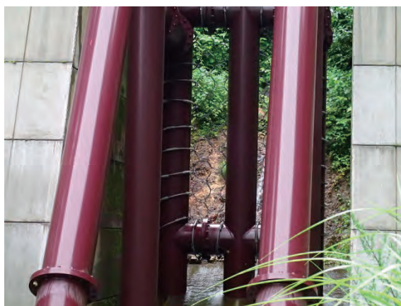
リング状ネットの設置状況
