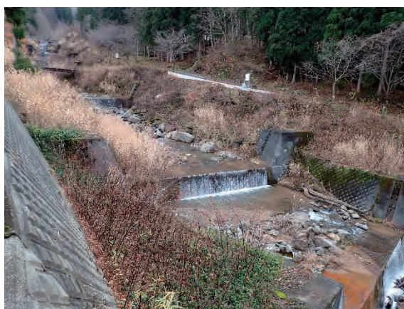
堰堤群の状況
