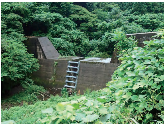
上流側堰堤の横桟
