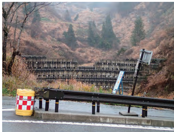
堰堤正面（地形変化に追従した様子）
