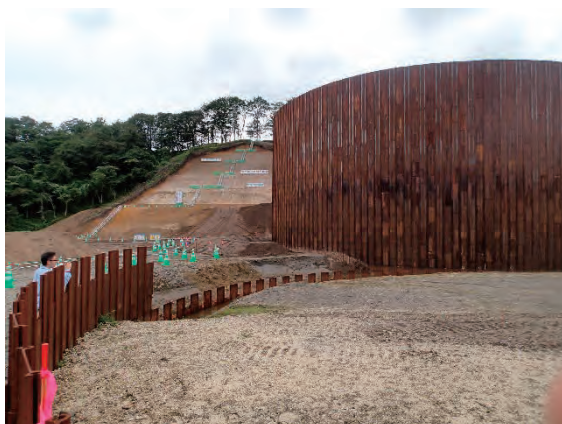
右岸側の完成したセルと切土法面
