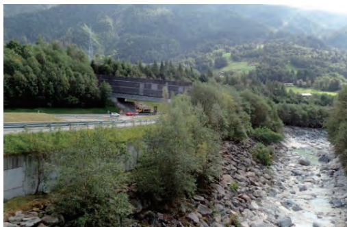
フランス・高速道路の上を渡る流路
