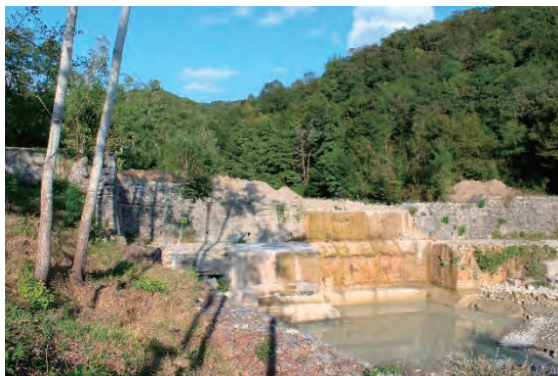
イタリア・Corsalone 溪の底部が抜けた堰堤
