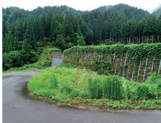
稗苗川 1 号堰堤
