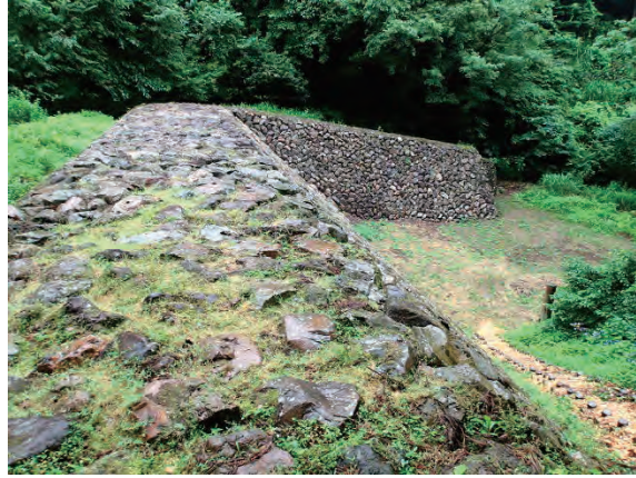
松ヶ端堰堤天端右岸より撮影
