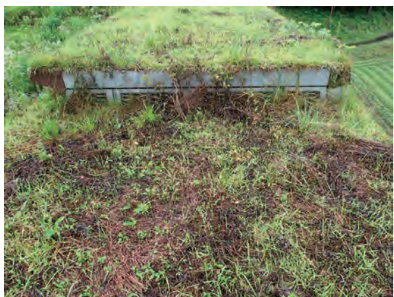
稗苗川 1 号堰堤天端部の植生状況
