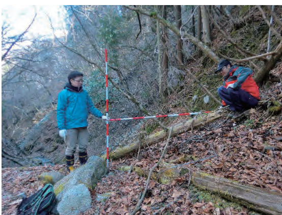
法行沢（大又沢支溪）2 号堰堤袖部形状確認
