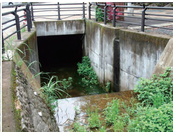
神宮川函渠上流端
