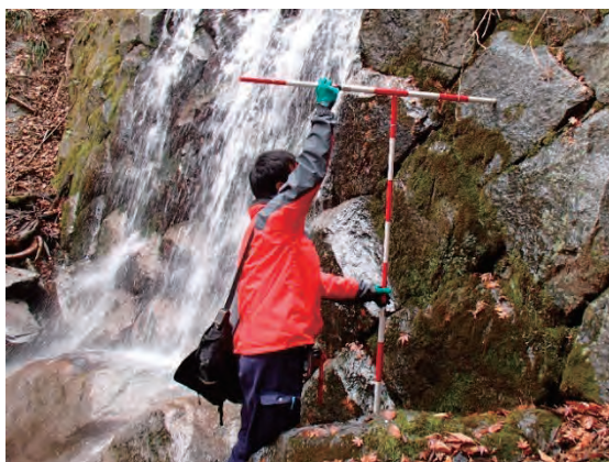
金山沢 7 号堰堤での下流法勾配計測
