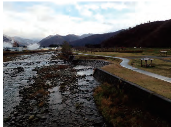
既設床固工の補強工事
