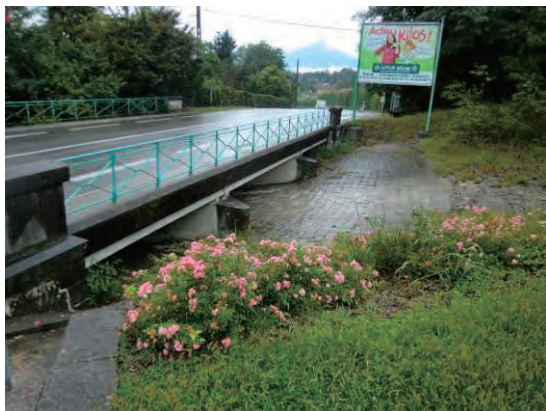
道路橋下の流路工の状況
