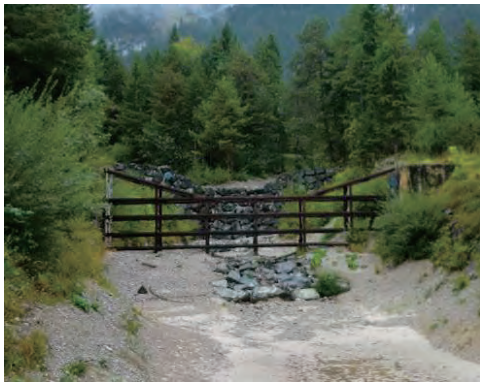
鋼製砂防堰堤の全景 (上流に不透過型堰堤あり)
