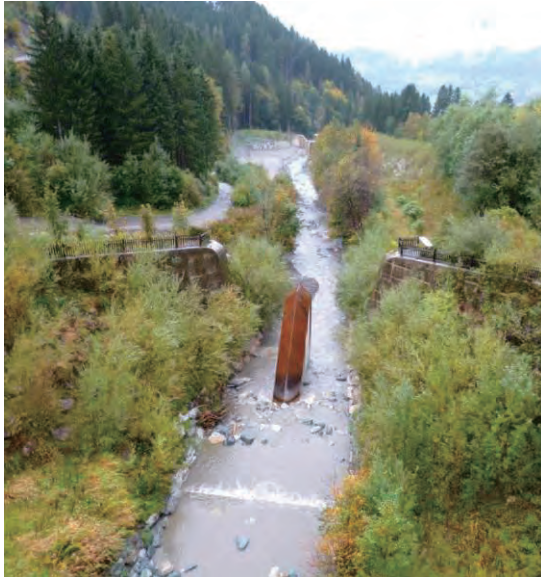
土石流ブレーカー (2012 年調査時)
