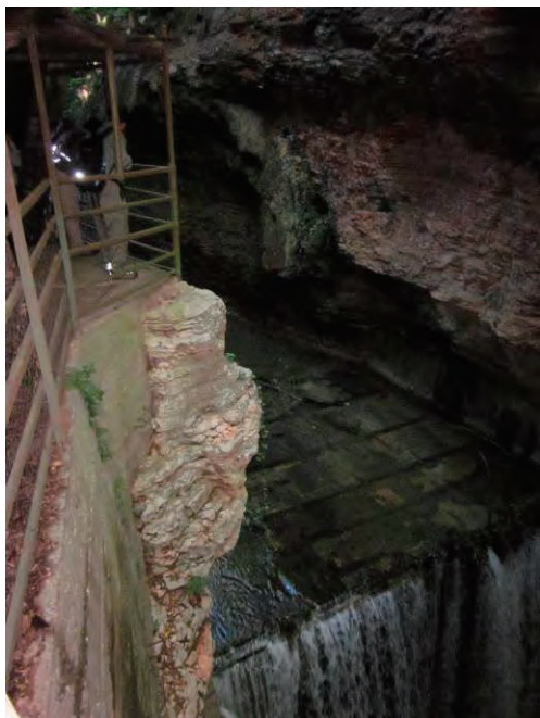
マドルツァ砂防堰堤（水通部天端）
