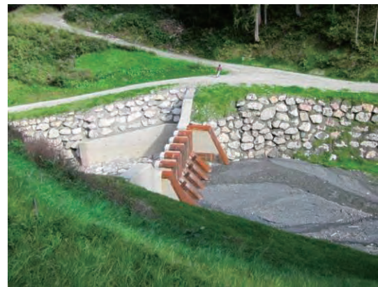
中流部の堰堤を左岸側より撮影
