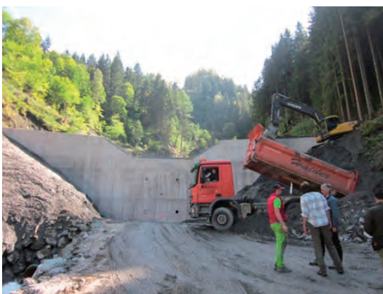
工事中的上流不透過堰堤
