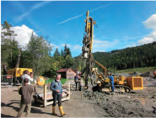
ボーリングの状況
