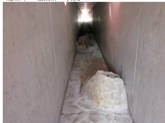
吐出部内の魚道状況
