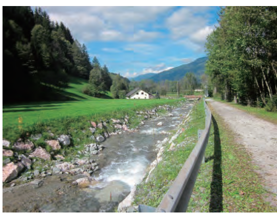
堰堤下流の溪流保全工の状況
