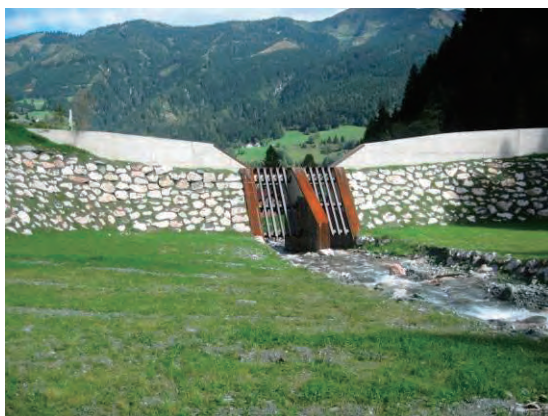
堰堤透過部を上流側より撮影
