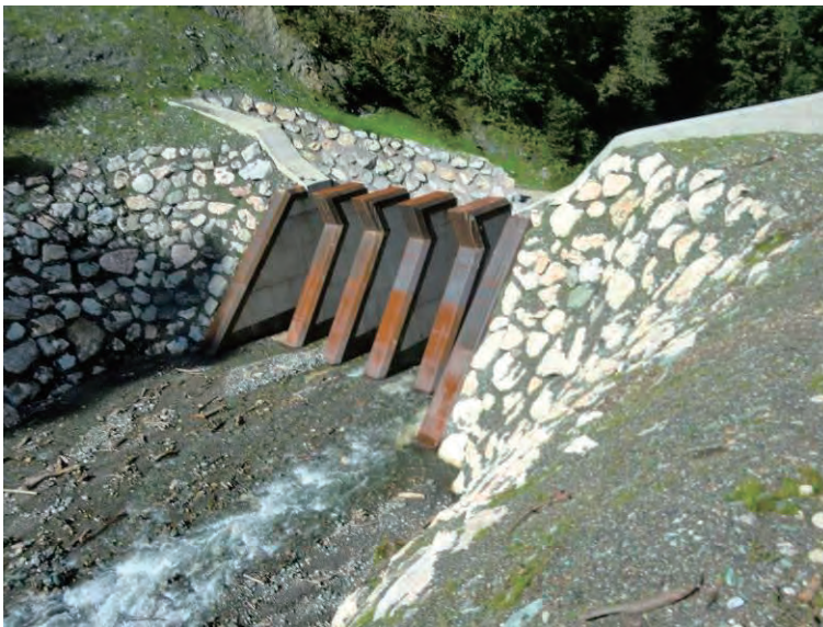
中間域 透過型スリット堰堤
