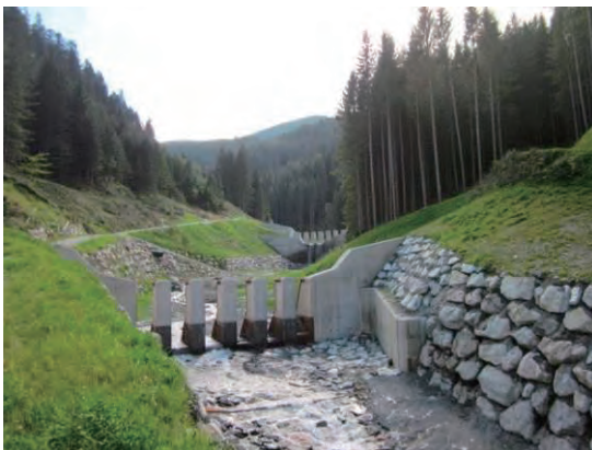
中流部堰堤下流側より上流を撮影（奥は上流部堰堤）
