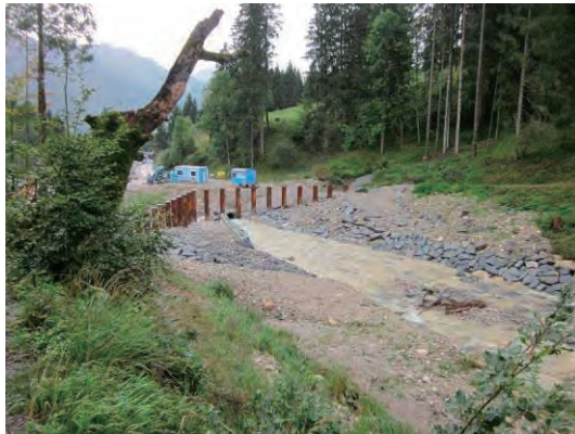
鋼管杭打ちの流木捕捉工とその平面模式図
