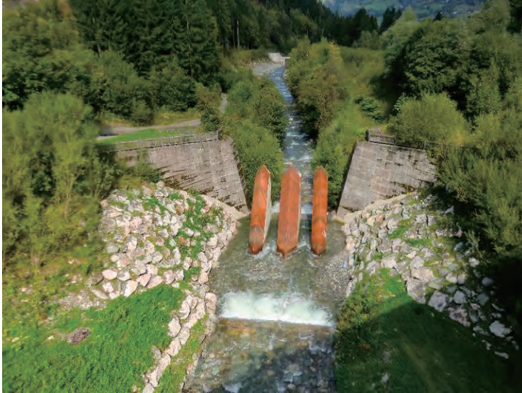
上流 2003 年建造 透過型スリット堰堤
