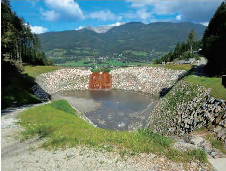
最下流 透過型鋼製スリット堰堤
