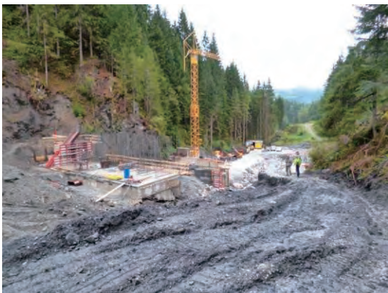
中流の透過型堰堤の状況 (2012 年調査時)
