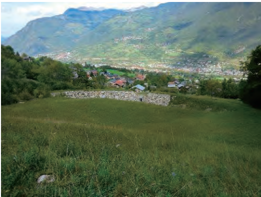
土＋コンクリート＋巨石石張堰堤（上流遠景）
