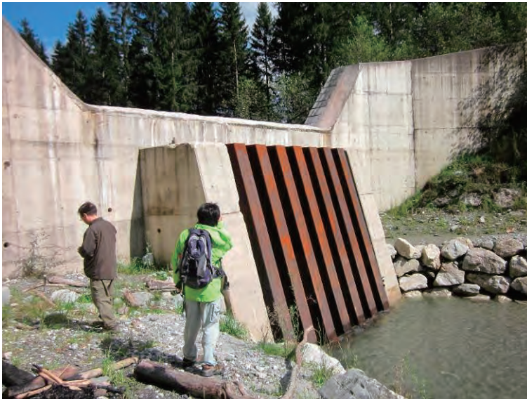
下流 2008 年建造 透過型鋼製スリット堰堤
