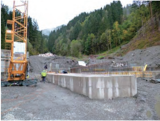
堆積工流入部付近（2012 年調査時）
