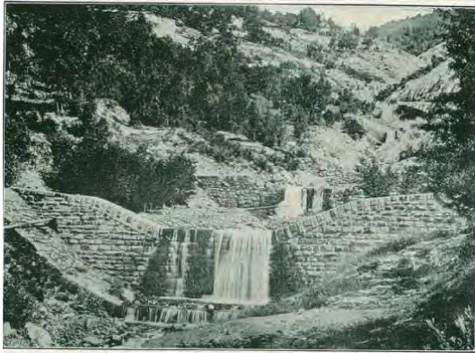
約 80 年前のグロイラス溪の第一号堰堤 出典：村上恵二、昭和 10 年頃 『砂防工事参考写真説明書』
