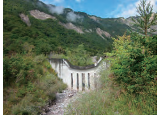
透過型堆積工を下流より撮影
