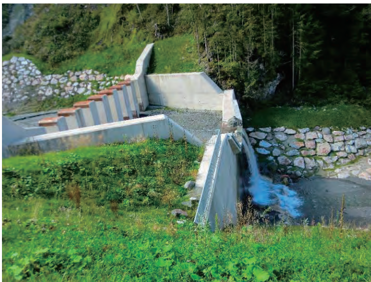
透過型スリット堰堤+不透過型堰堤
