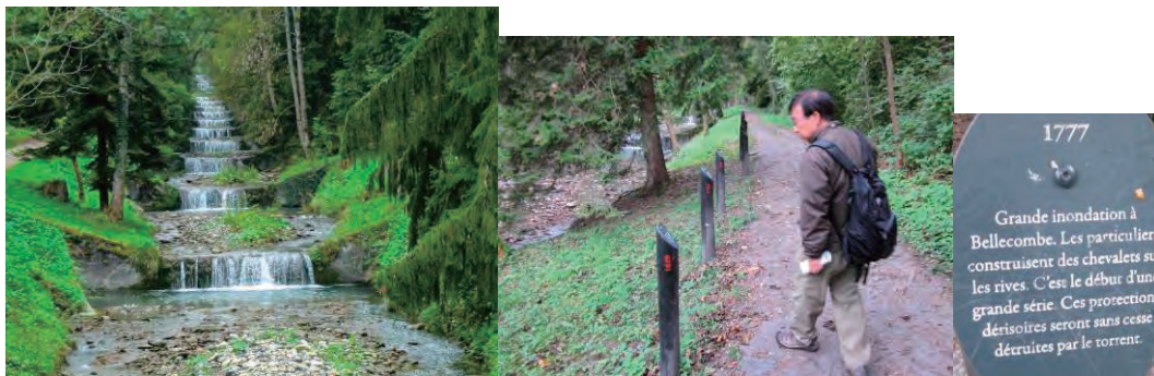
階段式の砂防堰堤群と左岸側の築堤
