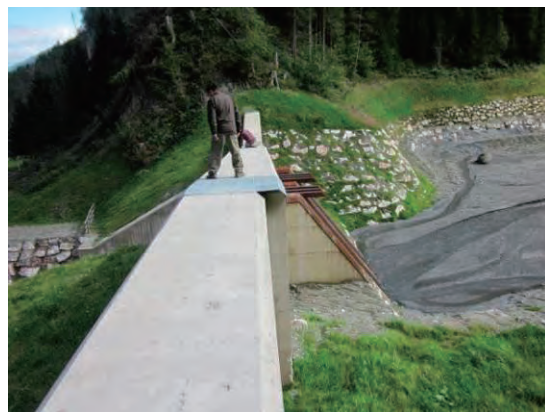
左右岸袖の形状が違う堰堤を上流側より撮影 左岸側より袖部を撮影
