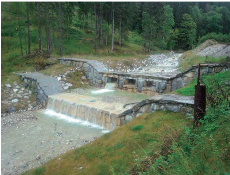
大暗渠の石張鉄筋コンクリート堰堤
