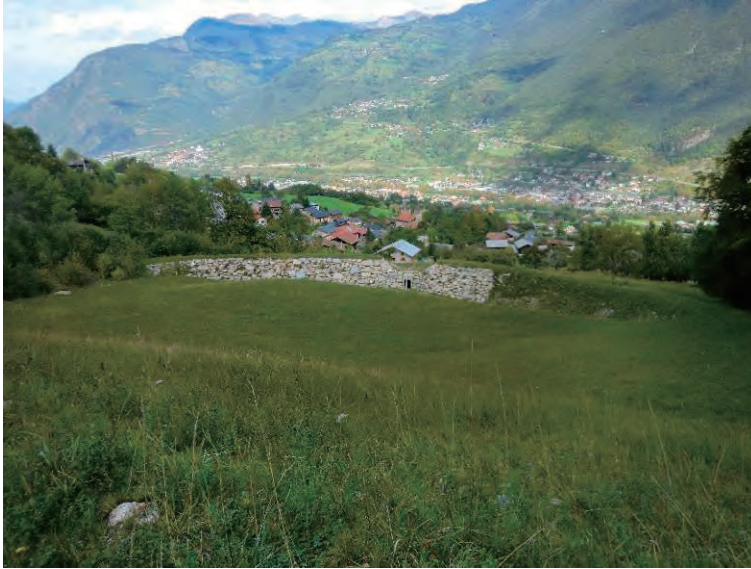
コンクリート巨石石張り堰堤
