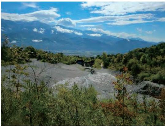
透過型堆積工と下流の保全対象を上流より撮影
