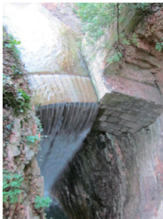
ポンテ・アルト砂防堰堤（近景）
