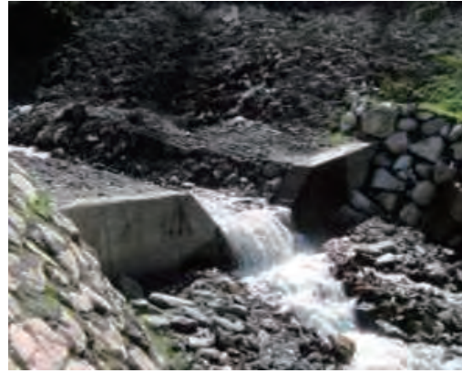
古いコンクリート堰堤の状況
