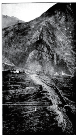
Cliché Mougin, 1898. Pl. III-A. — Torrent de Saint-Julien : le site de déjections et les anciens diques de défense. A rapprocher du cliché Mougin (pl. III-B).
