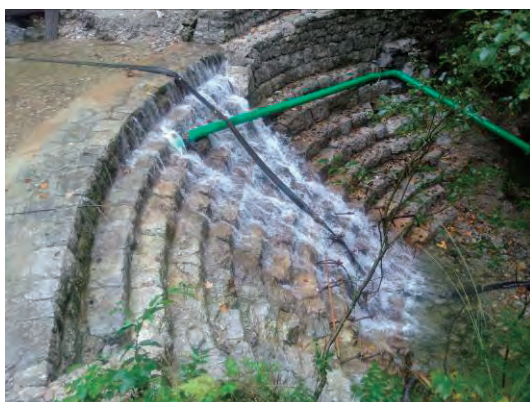
階段状の石積堰堤（右岸より）
