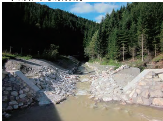
調整池直下流の溪流状況
