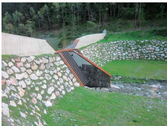
堰堤透過部を上流左岸より撮影
