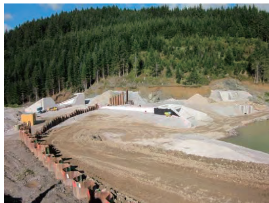
施工中の吐出部の状況
