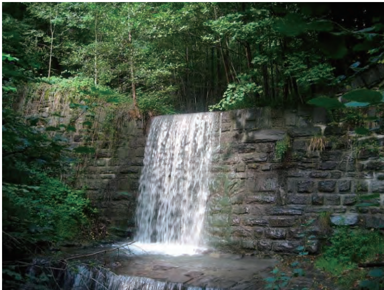
1881 年建造 第一号堰堤 (練石積堰堤)
