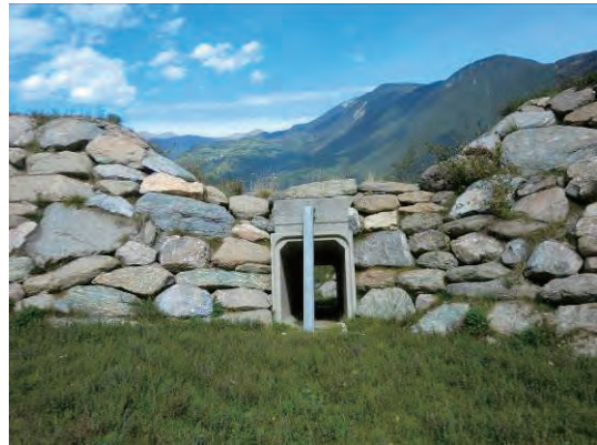
土＋コンクリート＋巨石石張堰堤 （水通し部近景）
