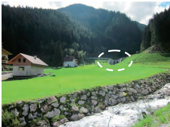
堰堤を下流より撮影
