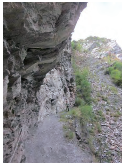
岩盤が切り立ち、オーバーハングした歩道
