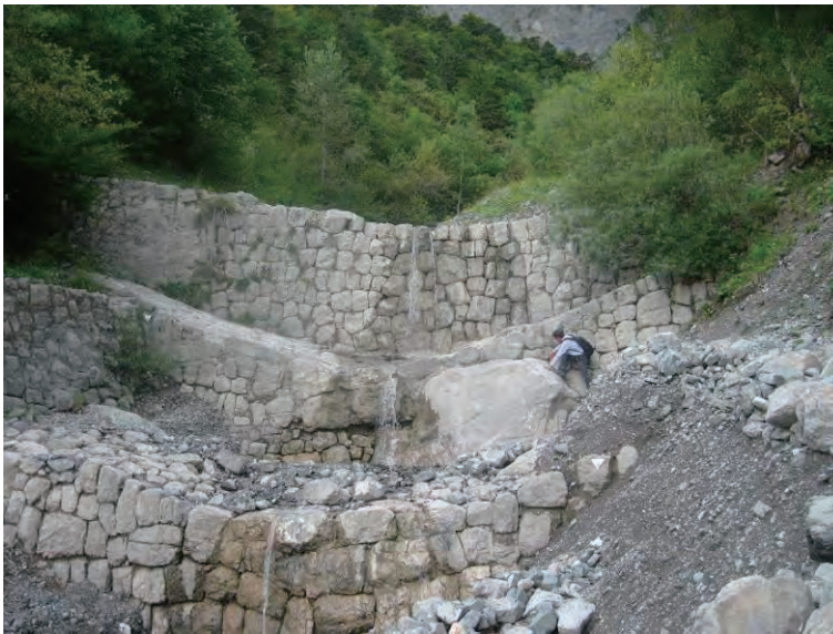
1896 年建造 練石積み堰堤
