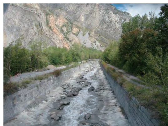
センオ・マーチン・ラ・ポルト溪の流路工
