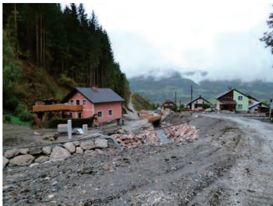
下流の溪流保全工の状況（2012 年調査時）
