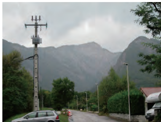
上流の荒廃状況
