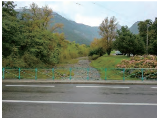
道路橋より上流側を撮影
