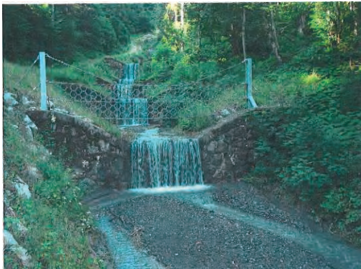
最下流部砂防堰堤のリングネット
