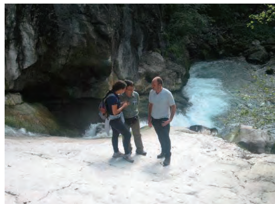
マッソ・カンタンゲル砂防堰堤の左岸側にある 露岩流水部
