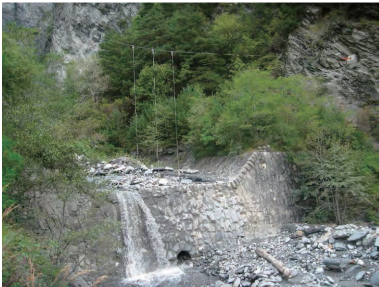
1901 年建造 最上流部の練石積堰堤
