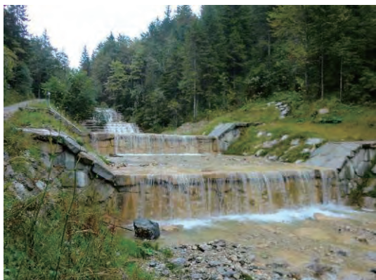
木堰堤（写真の最上流のもの）とコンクリート石張堰堤の階段工
