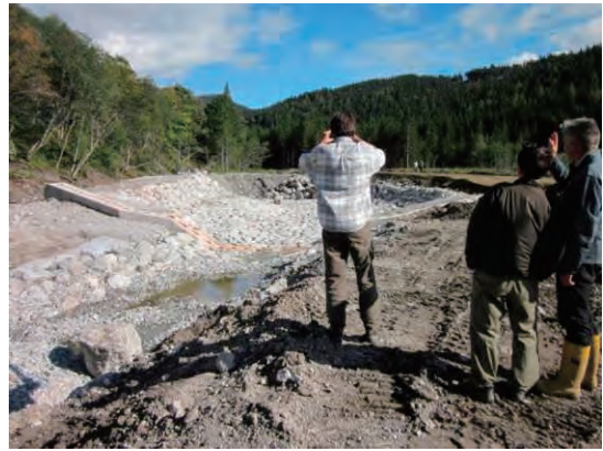
調節池内の環境再生目的の池（工事中）
