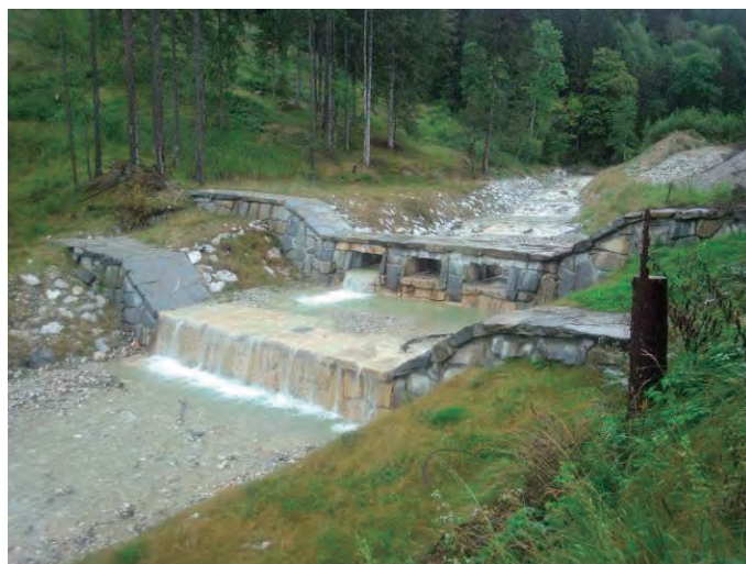
大暗渠を持つ鉄筋コンクリート石張堰堤
