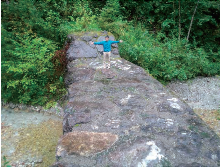
1990 年建造 コンクリート巨石張堰堤 (アーチ構造)
