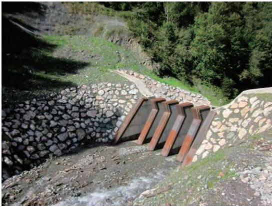
透過型堰堤を上流より撮影
