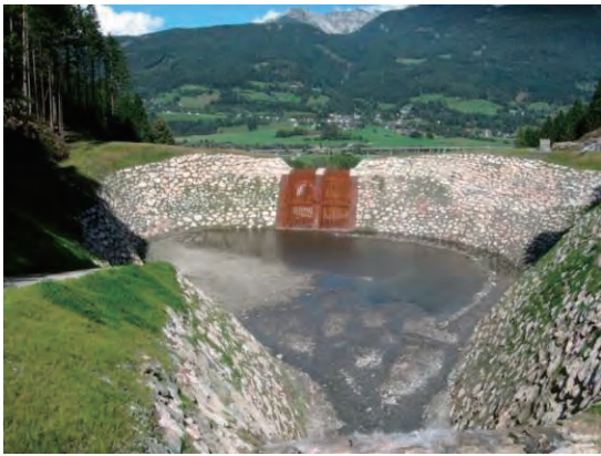
堆積工を上流より撮影
