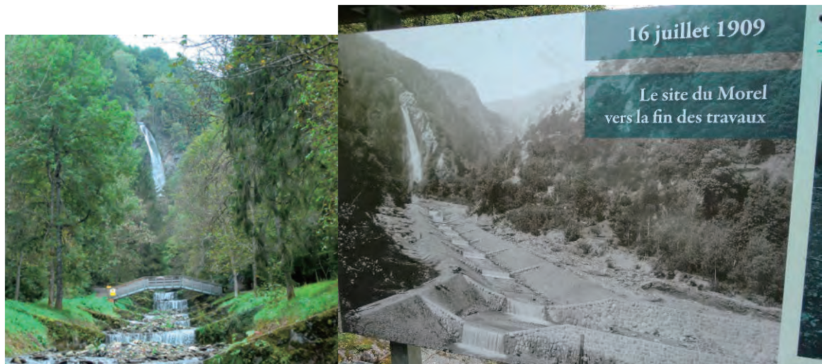
隧道出口の滝とその下流部分の現況と 1909 年の状況
