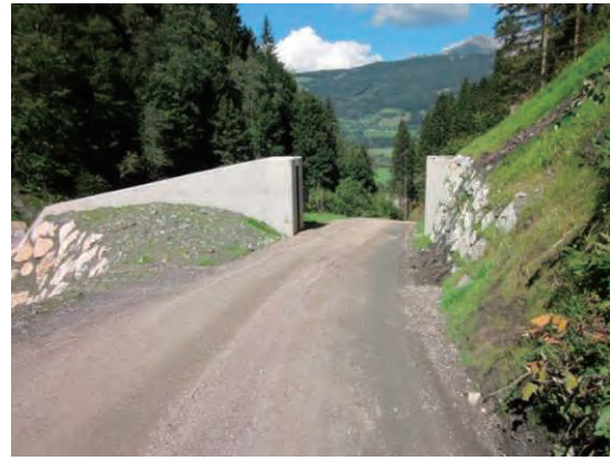
調査時には右岸袖に工事用道路の開口部有
