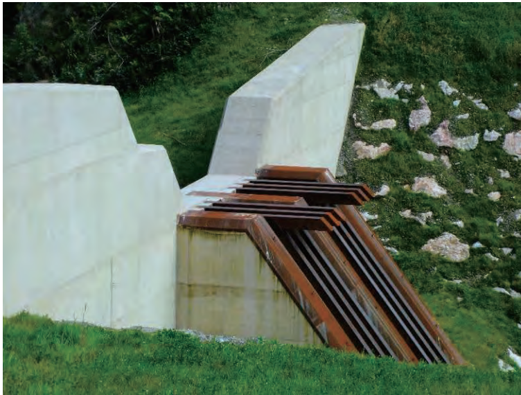
最下流 透過型鋼製スリット堰堤
