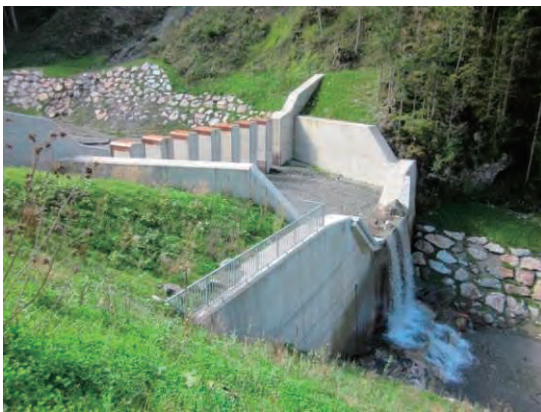
上流部の堰堤を右岸側より撮影
