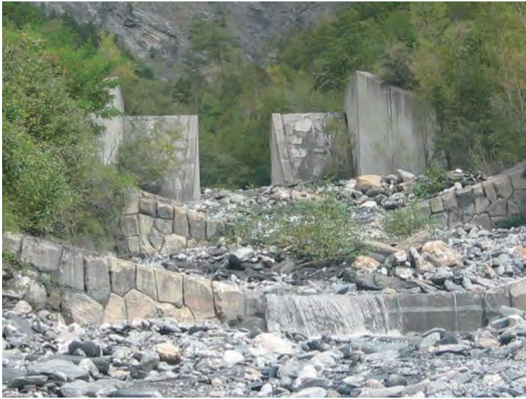
2003 年建造 溪谷出口付近のコンクリート石張スリット堰堤
