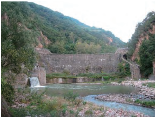
サンジオルジオ砂防堰堤 (正面)
