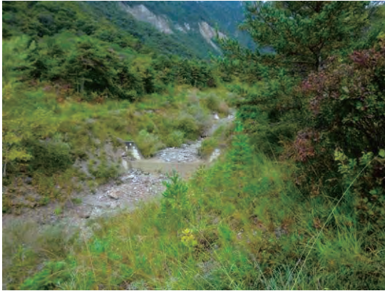
堆積工下流の流路工の状況
