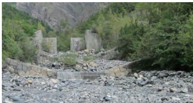
コンクリートスリット透過型砂防ダム
