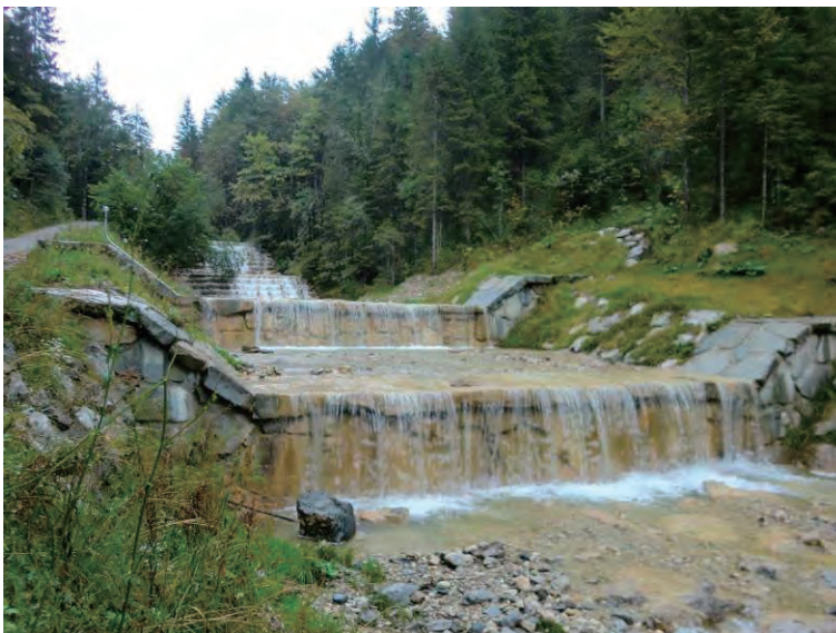
木堰堤とコンクリート石張堰堤の階段工
