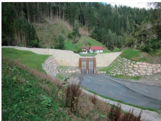
左右岸袖の形状が違う堰堤を上流側より撮影 左岸側より袖部を撮影
