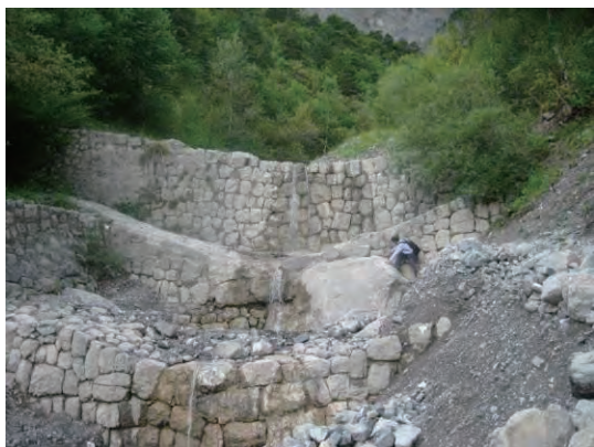
1896 年建造の練石積み堰堤
