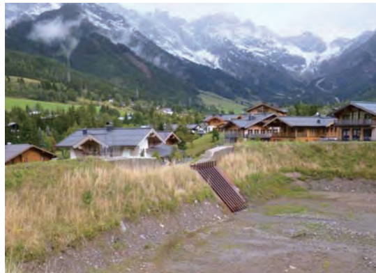
スリットの上部に流木止めが設けられている
