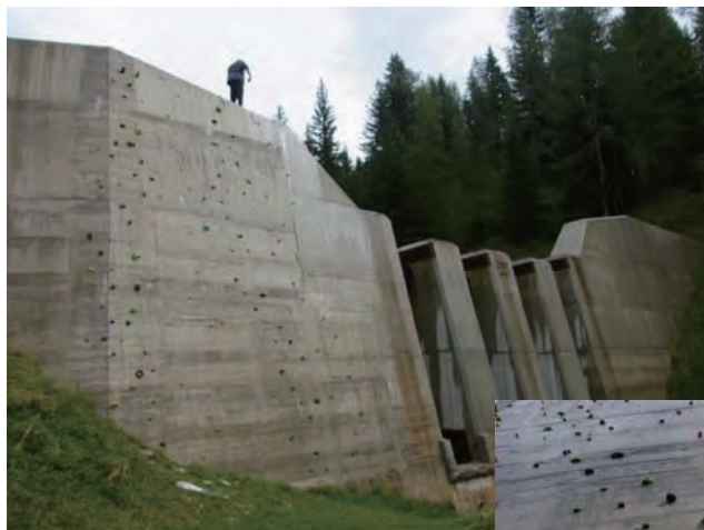
砂防堰堤の非越流部に付けた ロッククライミング練習用の足場
