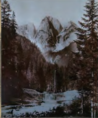
Die Verbauung der Bäche und der Lawinengänge zum Schutz des Gosauer Siedlungsraumes
