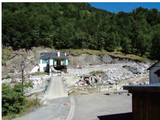
溪岸の侵食状況
