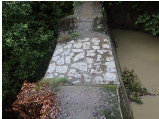
水通し天端に石張りが設置されている状況
