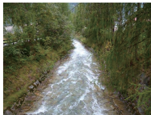
レンゲンフェルト内の溪流保全工
