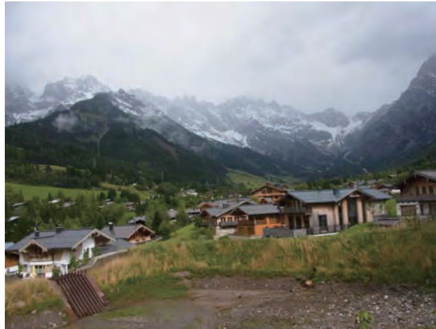
扇状地頂部の土石流堆積工
