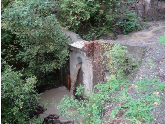
水通し下流側にせり出し（庇部）を設けている状況
