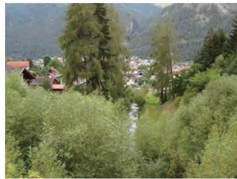
堰堤上流から
