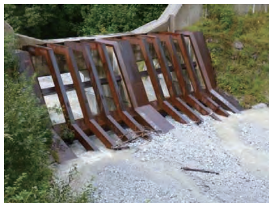
透過型砂防堰堤の上流部の形状
