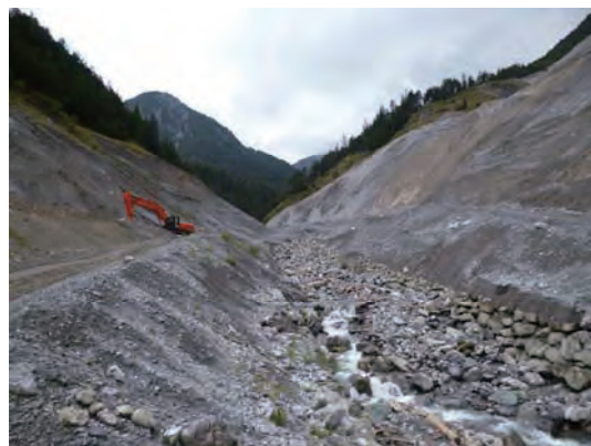
対策工事の状況
