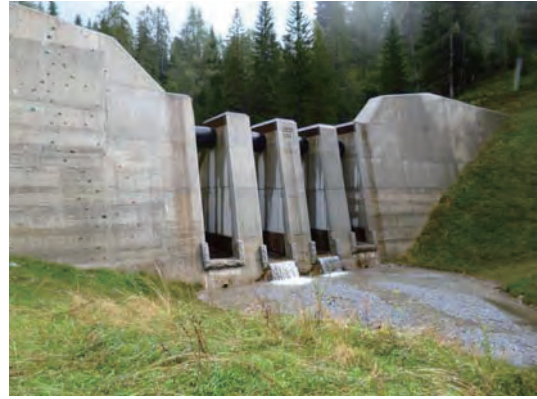
水通し部に張出しが設けられている
