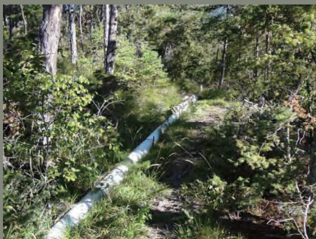
水抜き工。下流までパイプで排水系統構築。
