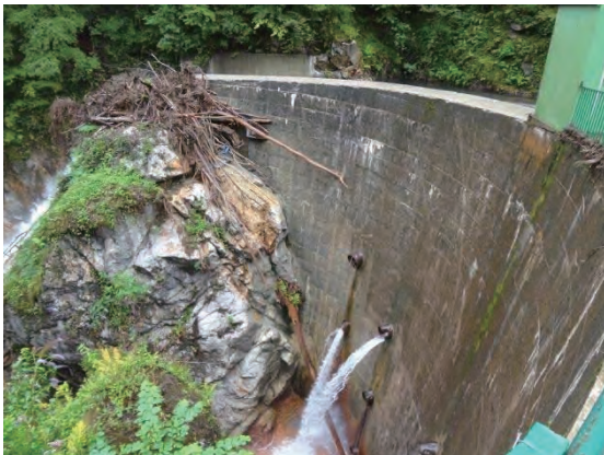
アーチ型砂防堰堤の状況（下流側）
