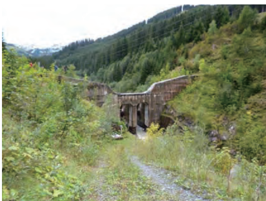
砂防堰堤全景
