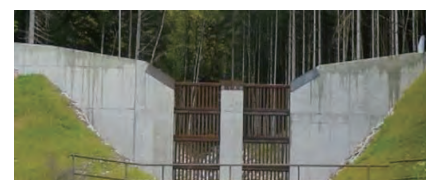
写真-5 屈曲部が無い水通し断面
