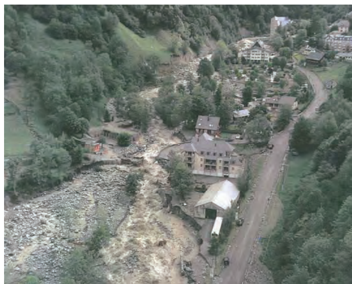
Bareges 地区の被災直後の状況
