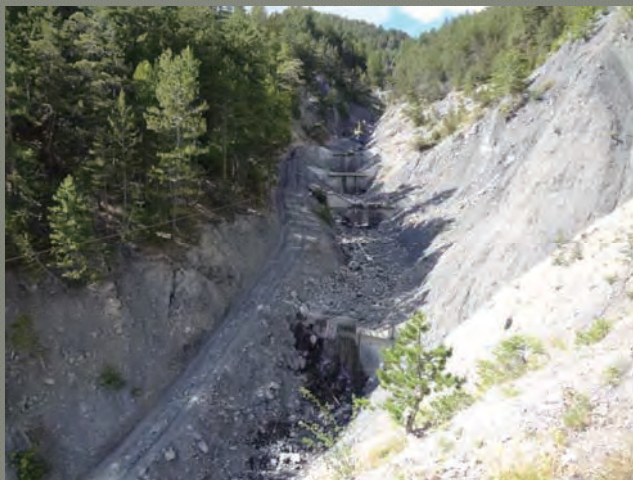
石積み堰堤被災箇所で索道を用いて施工中
