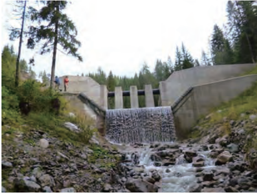
副ダムが整備された基幹ダム
