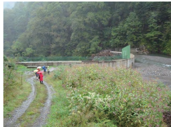
アーチ型砂防堰堤の状況（上流側）
