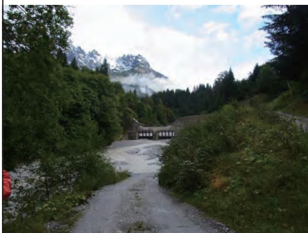
上流にある透過型砂防堰堤
