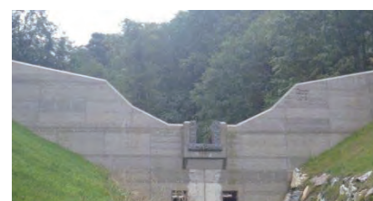
写真-7 切欠き部を設けた水通し断面
