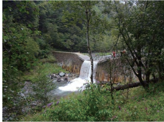
水通し下流側にせり出し（庇部）を設けている状況
