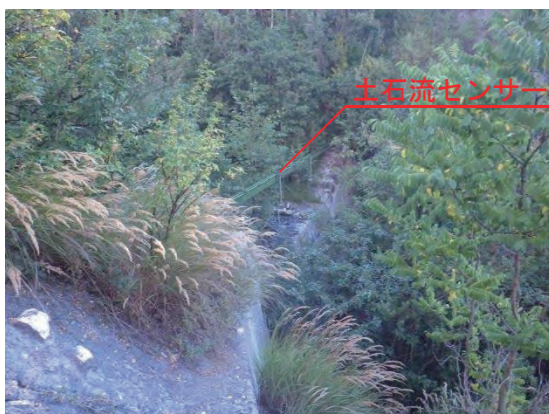
既設堰堤への土石流センサーの設置
