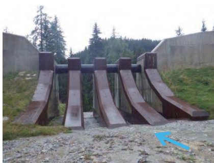
写真-1 スリット上流側の状況
