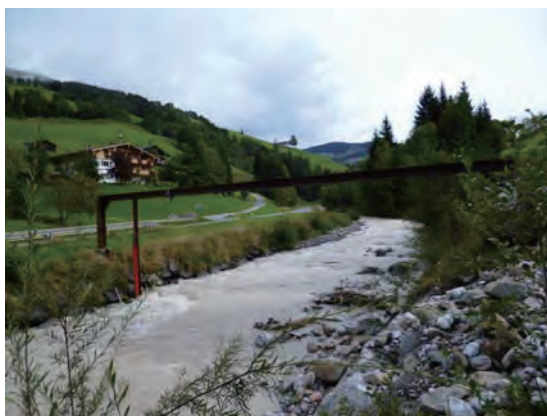
流砂量観測施設
