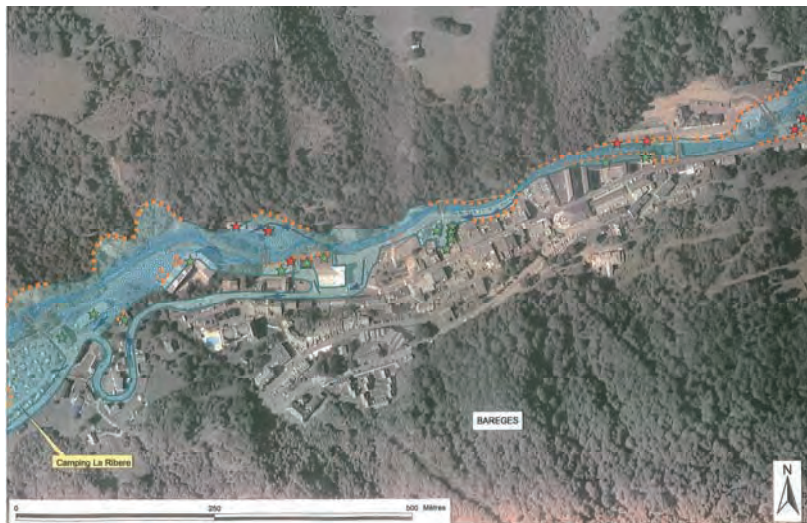
Bareges 地区の土砂氾濫状況
