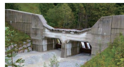
写真-6 屈曲部のある水通し断面
