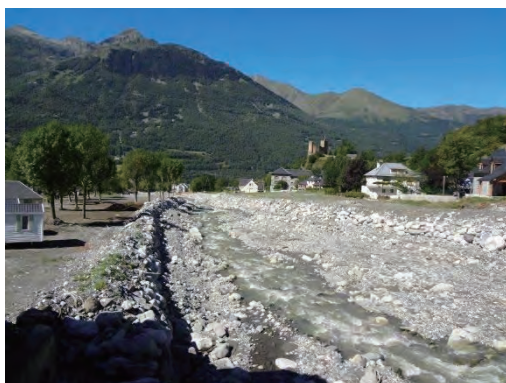
下流側氾濫状況
