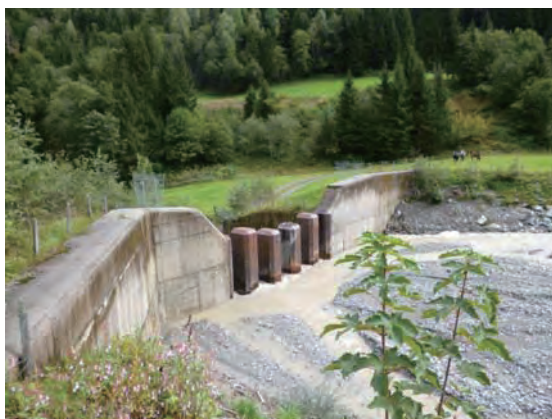
鋼製直立式の透過型堰堤
