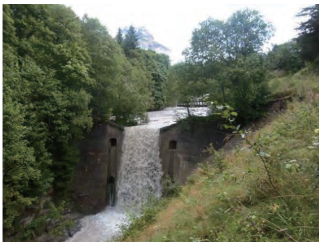
不透過型のアーチ式砂防堰堤
