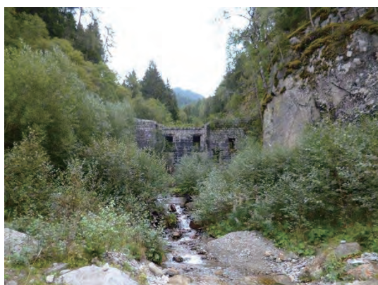
1955 年に施工された砂防堰堤
