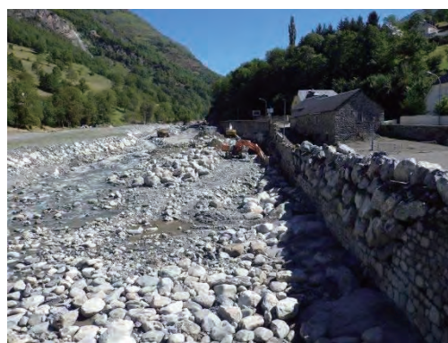
氾濫土砂の撤去状況
