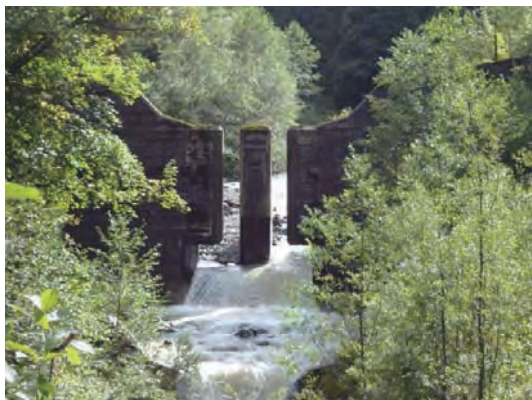
スリット下部が広がっている透過型堰堤
