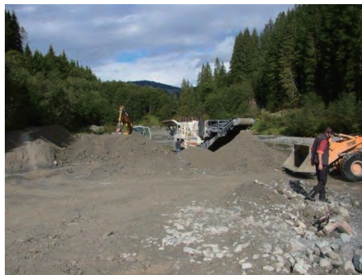
除石管理の状況
