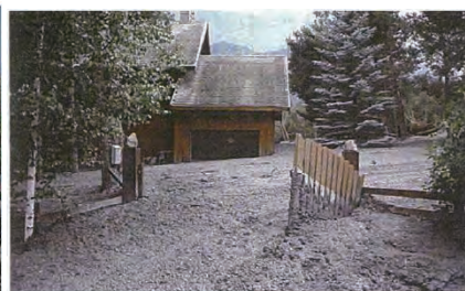
図 1.10 フォコン溪流の泥流発生直後の写真 30
