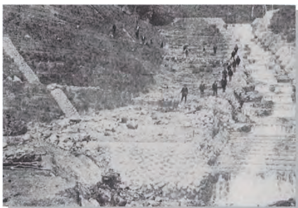
牛伏寺川フランス式階段工完成直前の様子
