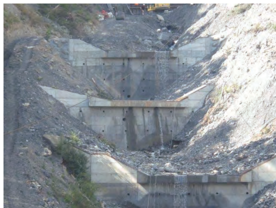
階段状に配置された堰堤
