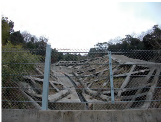
防府市遠ヶ崎東地区の法枠工
