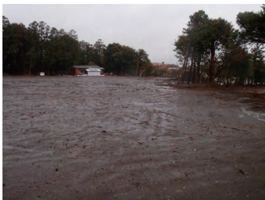
被災した神達地区の様子
