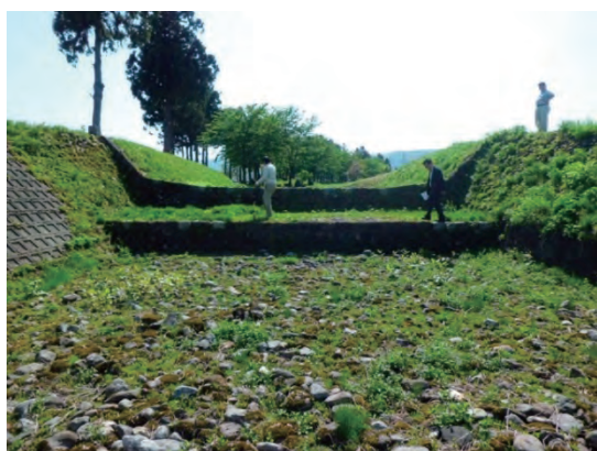
旧河道の全景（下流側より望む）
