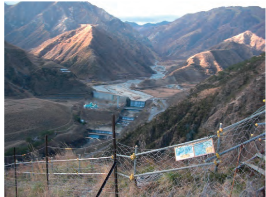
松木山より足尾砂防堰堤を望む
