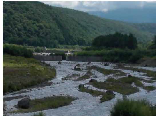
美瑛川第 6 号砂防堰堤 (7 号堰堤から上流を望む)
