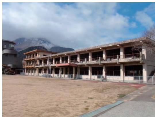
旧大野木場小学校被災校舎
