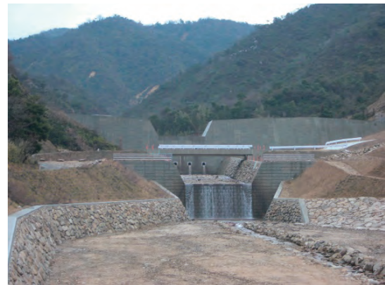
剣川砂防堰堤（下流より上流を望む）
