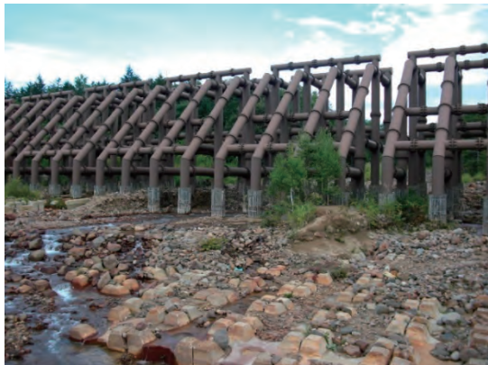
富良野川 2 号透過型砂防堰堤
