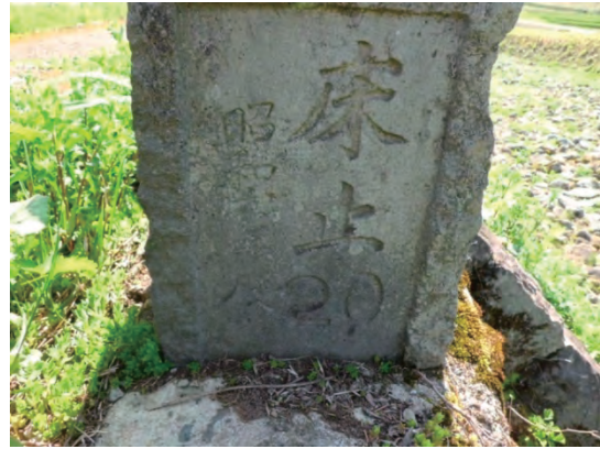
床固工の識別石碑 (床止 20 号 昭和 9 年)
