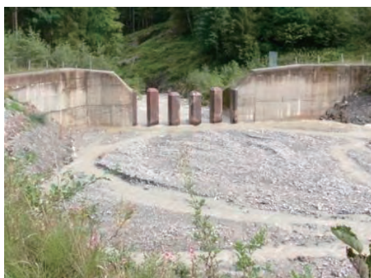
ゼッツバッハの土石流堆積工
