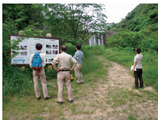
住吉川上流の砂防堰堤調査
