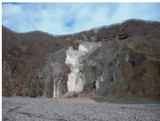
稲荷川上流山腹工
