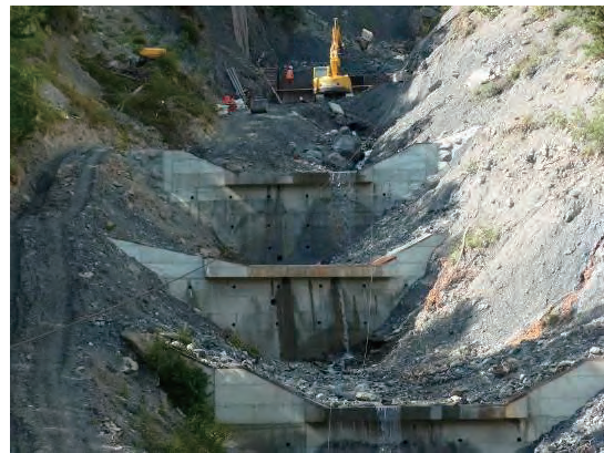
フォコン溪谷の砂防堰堤工事
