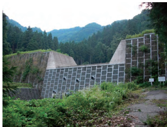
蔵作川砂防堰堤
