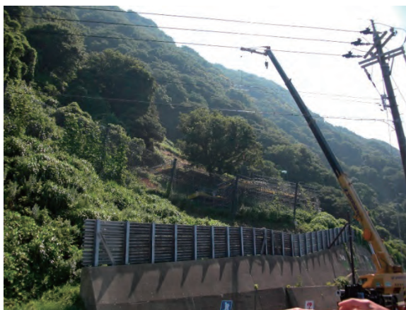
急傾斜地対策工事
