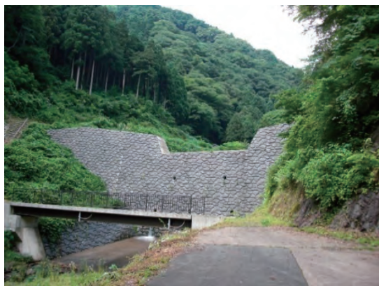
一乗谷川砂防堰堤
