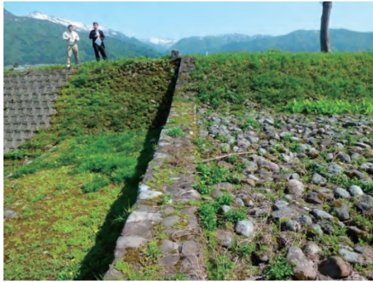
床固工の状況（左岸側より望む）
