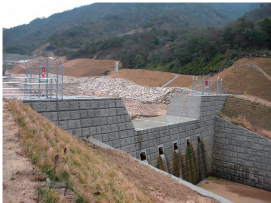
剣川の土石流堆積工（下流端の砂防堰堤）
