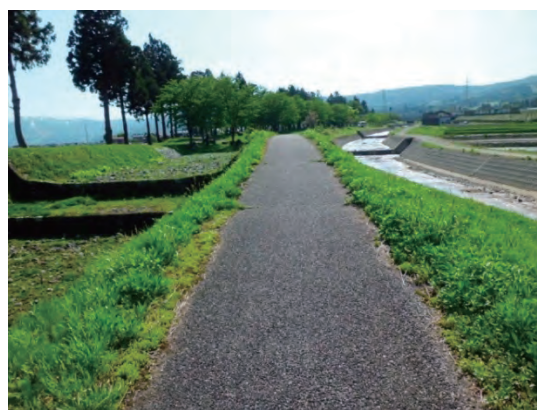
旧河道（写真左）と現河道（写真右） 旧河道は天井川であった
