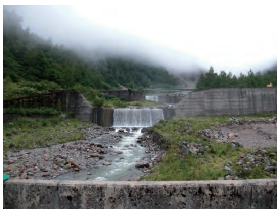
白岩砂防堰堤より上流を望む
