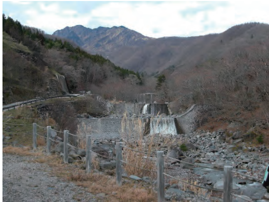
稲荷川砂防堰堤群
