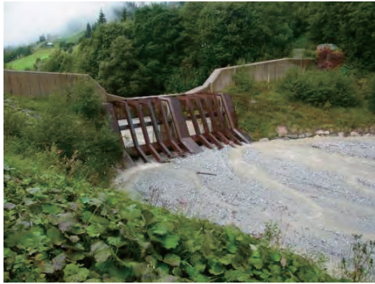
ディエンテルバッハの砂防堰堤
