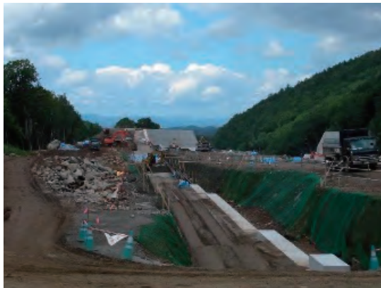
美瑛川第1号砂防堰堤（施工中）
