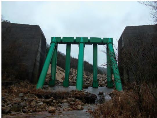
八幡谷溪流堰堤（下流より上流を望む） 石原 1 透過型砂防堰堤（下流より上流を望む）
