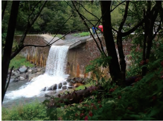
ピケ川の砂防堰堤
