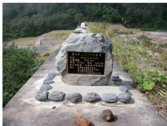
湯川第 12 号砂防堰堤
