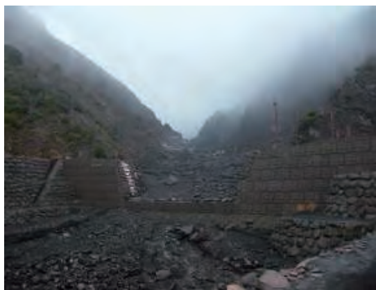
野尻川 8 号堰堤（下流より上流を望む）
