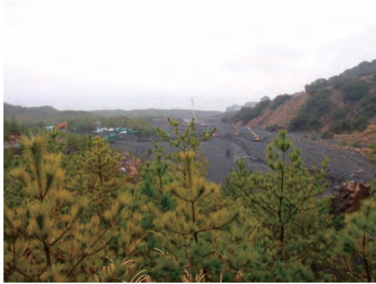
有村川の無人化施工現場
