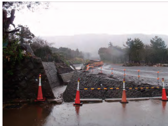
大金沢本川堆積工下流の橋梁より上流を望む
