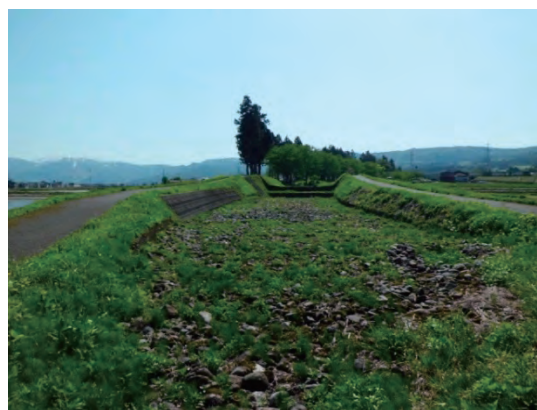
床固工の状況
