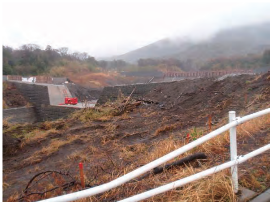
大金沢本川堆積工
