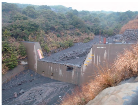
有村川 3 号堰堤（下流より上流を望む）
