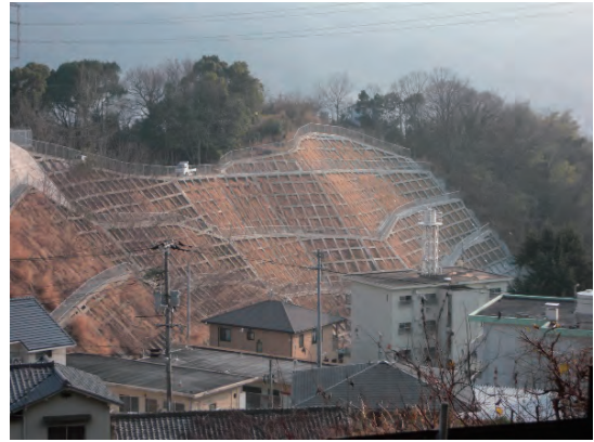
谷原地区の法枠工
