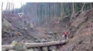
写真.2 断面2を下流より撮影
