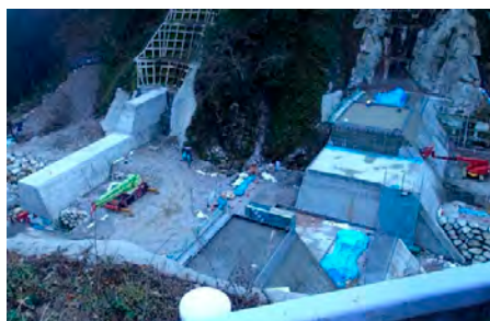
天竜川上流 (コンクリート打設)
