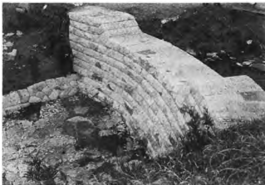
写真-1 東京都水道水源林の大正5年施工堰堤（諸戸北郎博士アルバムより）
