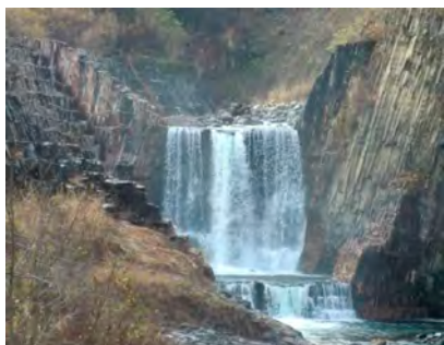
湯沢砂防(七ツ釜堰堤・景観)
