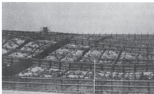
写真－9 防風垣と砂防植栽 （東京大学生態水文学研究所蔵） Photo 9 Hedge and planting along seashore （Owned by the University of Tokyo）
