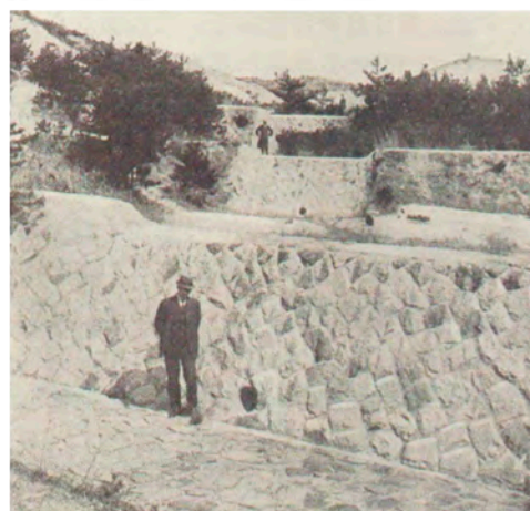
写真-10 愛知県瀬戸地方の練石積砂防堰堤(Hofmann, 1936より)
