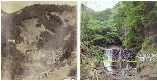
写真—3 峯沢沢第2号堰堤 (左：諸戸北郎博士アルバムより、右：2016年) Photo 3 Minesakazawa No. 2 check dam (left: From Moroto's photos album, right: 2016)
