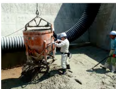
コンクリート打設
