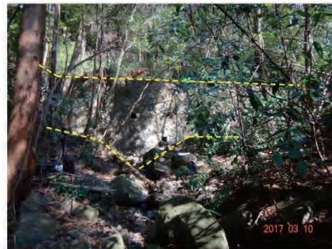
写真4 ②上流側堰堤の全景 (堰堤から約15m下流で撮影)
