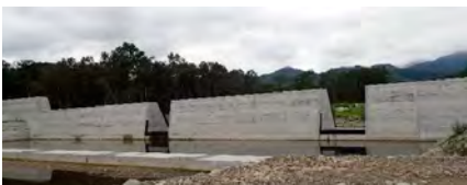
札内川砂防(スリット堰堤)
