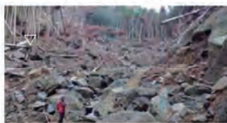
写真.1 断面1を下流より撮影
