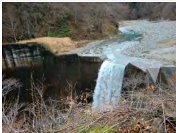
湯沢砂防 (アーチ堰堤、複断面水通し)
