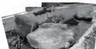
写真-1 流路内の巨礫の停止状況
