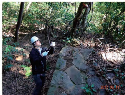
写真2 堰堤の撮影状況
