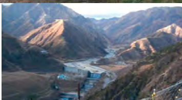
足尾砂防・松木山腹工
