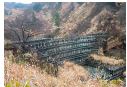
湯沢砂防(ブロック堰堤)
