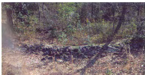
写真-3 萩御殿の石積堰堤（2016年2月24日著者撮影） 土（粘土）を突き固めた堤体の上下流と天端を巻くように割石を張っている。水通部の形状は中央を低くした弧状である
