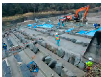
湯沢砂防(魚道)
