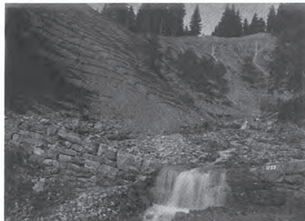
写真-5 シュミッテン溪の砂防堰堤と山腹工 (諸戸北郎博士アルバムより、1900年頃)
