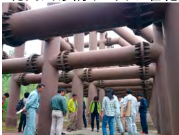
北海道(鋼製堰堤)
