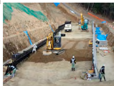
広島西部山系 (砂防ソイルセメント)
