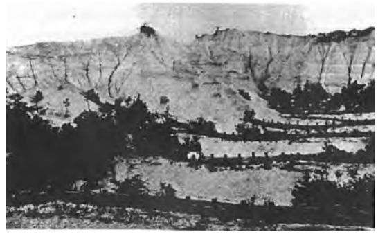
写真-2 1906（明治39）年施工当時のホフマン工事 （愛知県農林水産部, 2005より）
